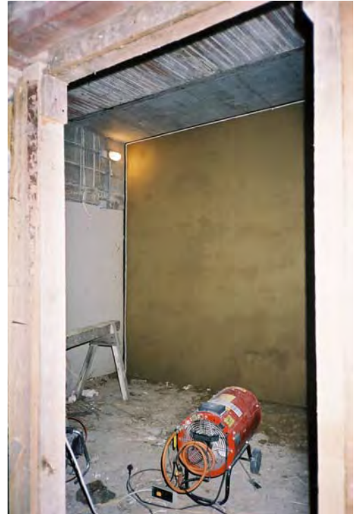
fertige Vorsatzschale
