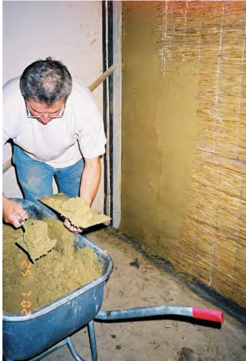
Auftragen der 1.Lage Lehmputz
