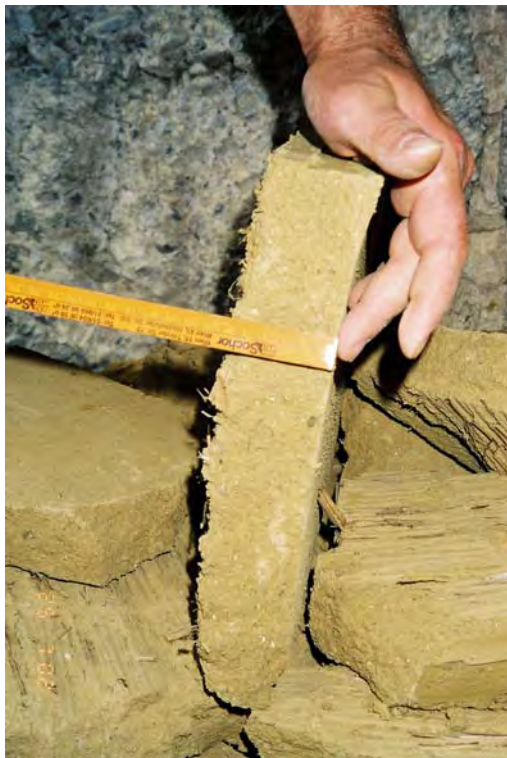
Abgebrochene erste Vorsatzschale VSI 3 Lagen Lehm. Dicke der Lehmschichte mit 3 Lagen.
