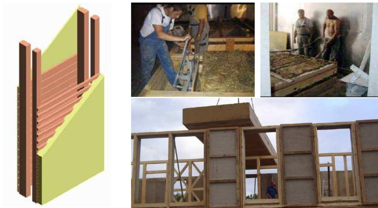
Abbildung 1: Fertigteile- Konstruktionsprinzip [natur & lehm]
