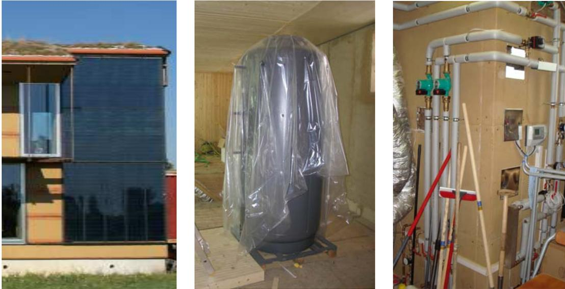
Abbildung 3: Links: Thermischer Solarkollektor in Fassade; Mitte: 1500 Liter Solarspeicher vor Einbau; Rechts: Der fertig eingebaute, mit Flachs gedämmte und mit natur & lehm Biofaser-Lehmverbundplatten verkleidete Speicher mit isolierten Leitungen. Für die Nachheizung wurde ein E-Heizstab in den Speicher integriert. Der E-Heizstab befindet sich in der oberen Speicherhälfte, oberhalb des Vorlaufanschlusses zum Heizkreis.
