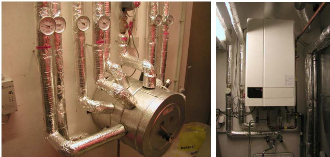
Abbildung 10: Hydraulische Weiche und Gastherme
