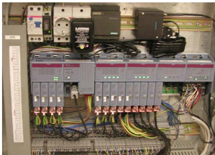
Abbildung 4: Einbaues Logger-System im Kindergarten Ziersdorf
