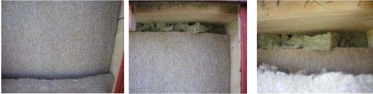
Abb. 24: Unzulässiger Messaufbau Testbox Hanf
