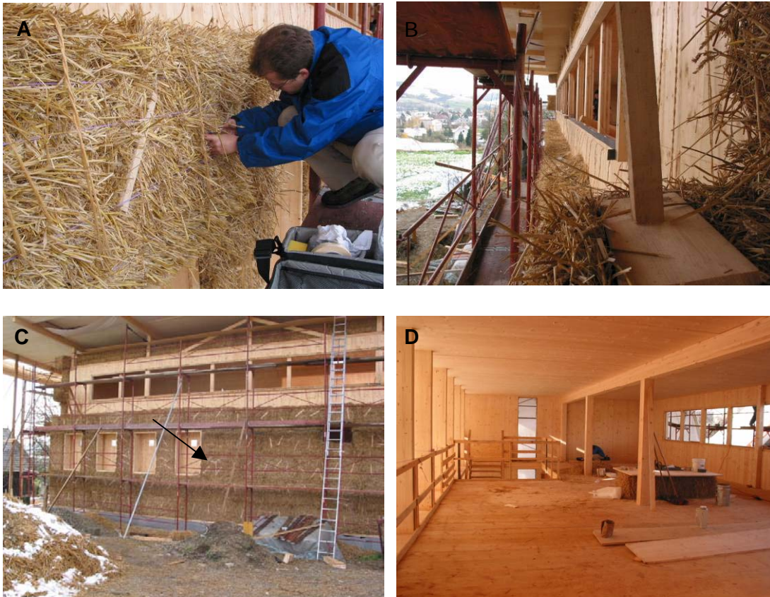
Abb. 57: Probennahme am 25.10.2004; (A) Entnahme von Stroh mit steriler Schere, (B) Entlang der Nordfassade wurden 4 Proben entnommen, (C) Entnahmestelle am Messfühler für Probe Nr.7 Nord, (D) Luftkeimsammlung mit dem Sartorius MD8 im noch offenen Innenraum.
