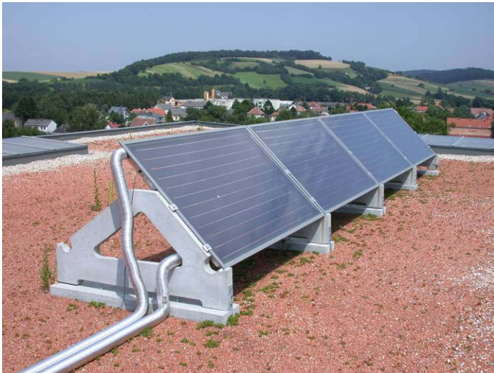
Abb. 3: 10 m 2 Solarkollektoren auf dem Flachdach bzw. stückholzbefuenerter Speicherofen im Ausstellungsraum integriert.
