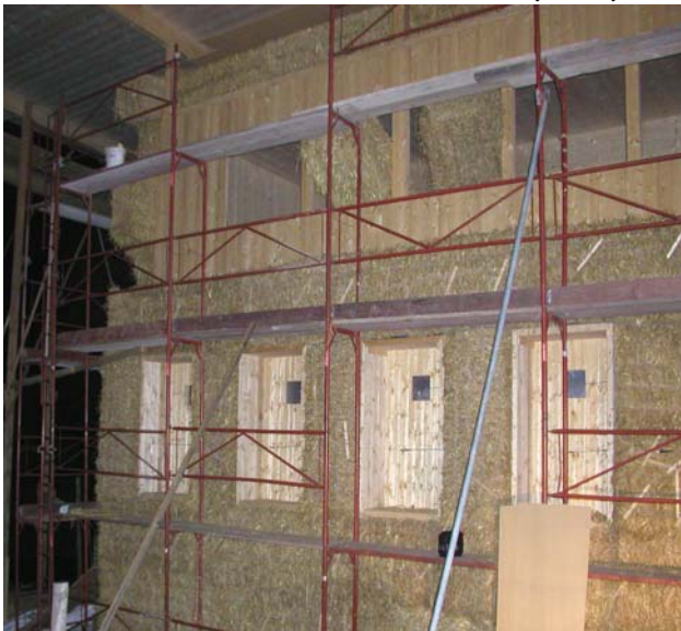
Abb. 1: Nordwand – Strohdämmung und Testboxen
