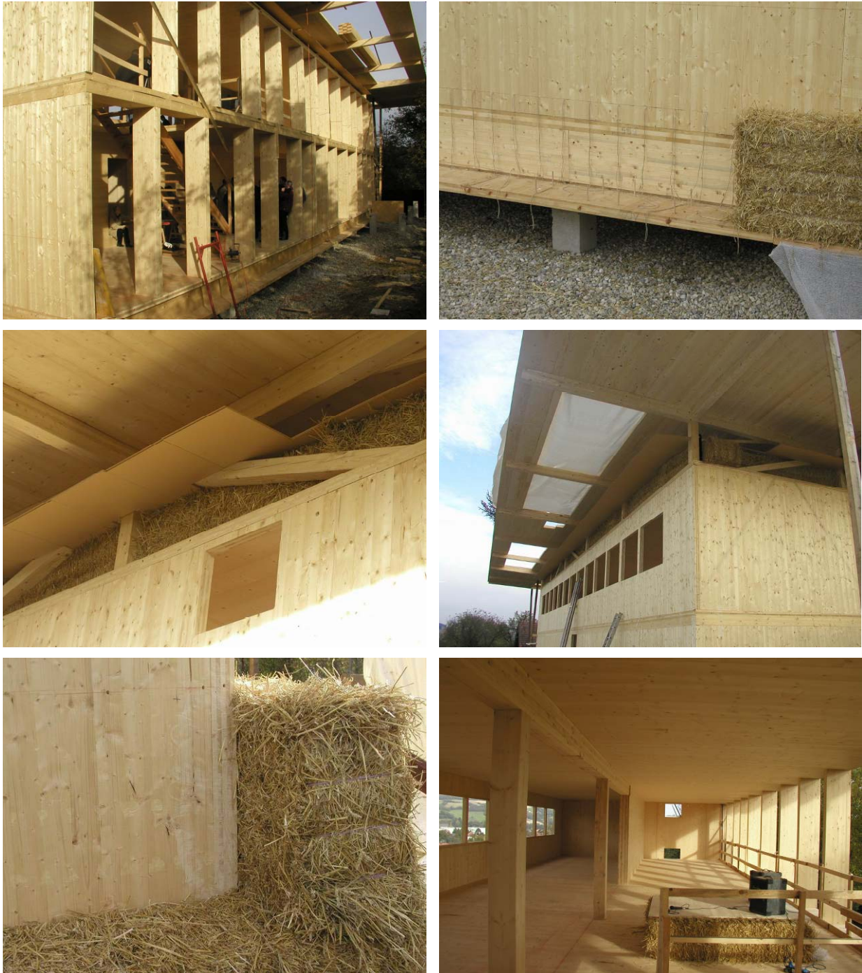
Abb. 60: S-House Ansichten Errichtung
