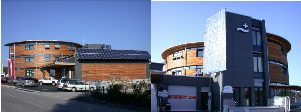
Abb. 16: 90° geneigtes Sonnensegel ( 3,6 \text{ kW}_{\text{peak}} ), bzw. ( 6,2 \text{ kW}_{\text{peak}} ) um 40° geneigt
