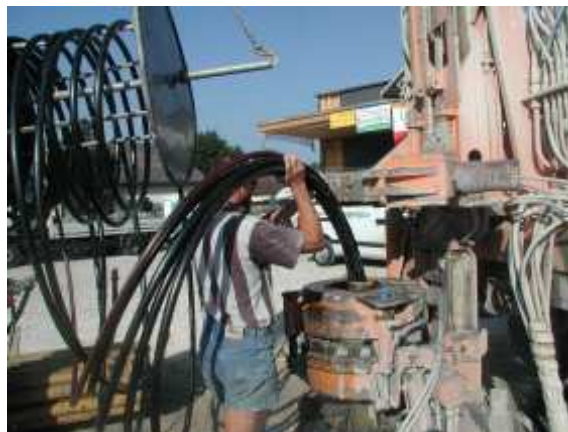
Abb. 15: Einbringen der Tiefensonden - vier Rohre je Sonde, über das fünfte Rohr (rote Markierungsstreifen) wird das Bohrloch hinterfüllt. Beim ChristophorusHaus wurde das spezielle Hinterfüllmaterial „Stüwatherm“ verwendet, das die Wärmeleitfähigkeit durch Zugabe von Quarzkorn im Vergleich zu konventionellen Bentonit-Zement-Gemischen um bis zu zehn Prozent erhöht.
