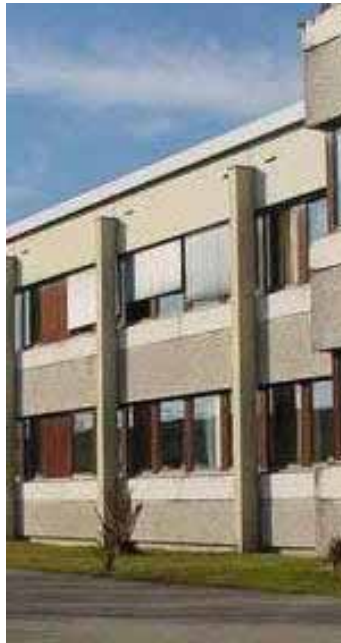
Abb. 4.1: Schule in Schwanenstadt vor thermischer Sanierung, deutlich erkennbar sind die Stahlbetonstützen. Quelle: Lang et al. [2004].
