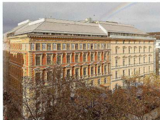
Hotel am Schuberting: Sanieren bedeutet auch den sensiblen Umgang mit historischer, erhaltenswerter Bausubstanz.
