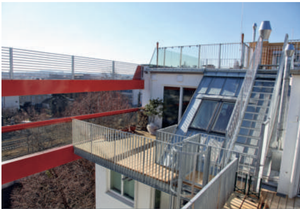
Das ausgebaute Dach hat Qualitäten
