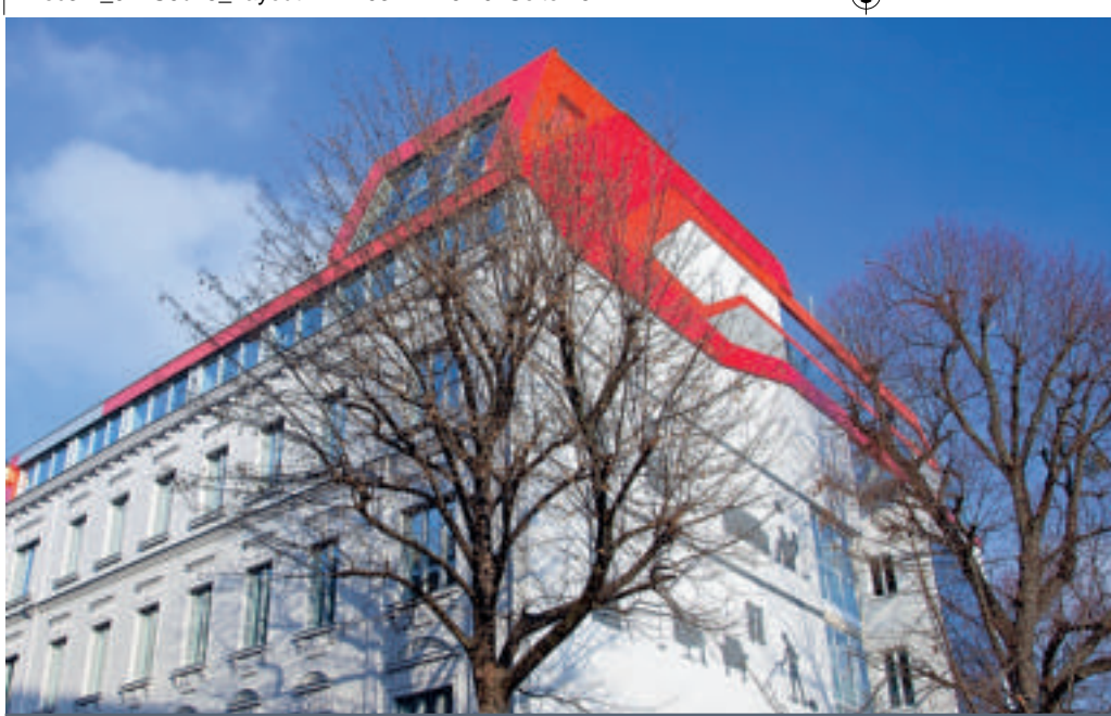
Der Heizwärmebedarf des Gründerzeithauses wurde von 186 auf 23 kWh/m 2 jährlich reduziert
