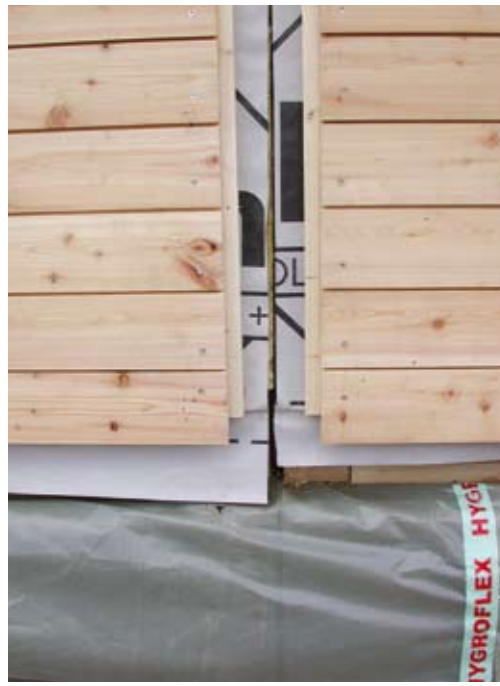
Abb. 4, 5: Raummodule mit Kreuzlagenholz am Beispiel Impulszentrum Graz: Transport mittels Lkw zur Baustelle, Modulstoß-Fassade. Fotos Riess
