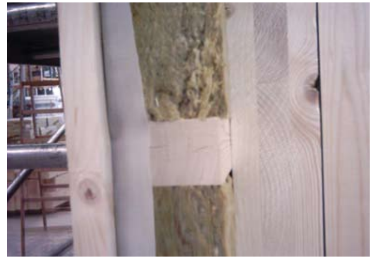
Abb. 6: KLH-Wandaufbau: KLH-Mineralfaser-Winddichtung-Lattung (Hinterlüftungsebene). Foto: Kulmer
