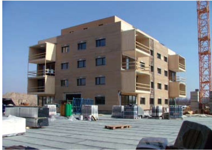
Abb. 10–13: Errichtung der Wohnhausanlage Mühlweg: Treppenhäuser mit gedeckter Tiefgarage; KLH-Platten vorbereitet zur Fertigung; Montage der ersten Fertigteile, Drücken in die Fußposition; Fertigstellung der Fassaden und der Loggien. Fotos BAI
