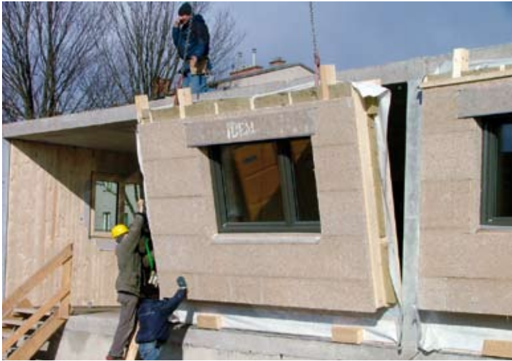
Abb. 10–13: Errichtung der Wohnhausanlage Mühlweg: Treppenhäuser mit gedeckter Tiefgarage; KLH-Platten vorbereitet zur Fertigung; Montage der ersten Fertigteile, Drücken in die Fußposition; Fertigstellung der Fassaden und der Loggien. Fotos BAI
