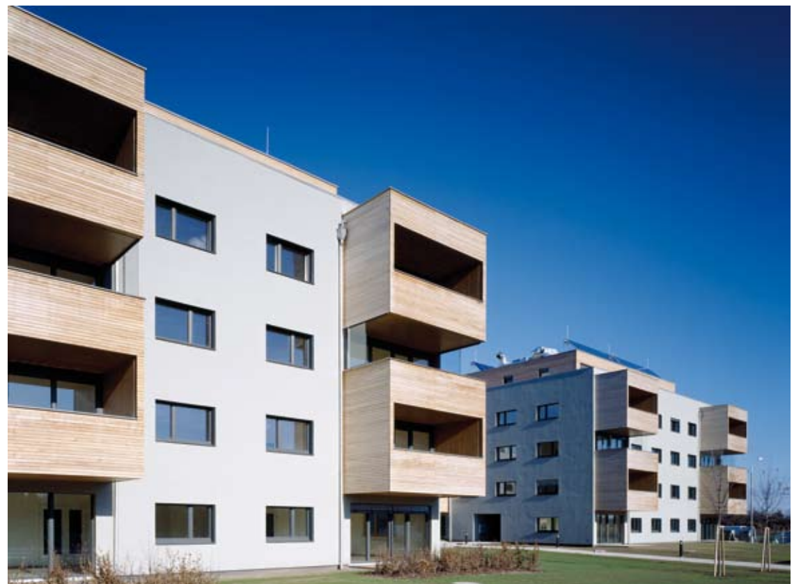
Abb. 2: Haus am Mühlweg – Passivwohnhaus in Holzmixbauweise, Wien; Arch. Dietrich | Untertrifaller
