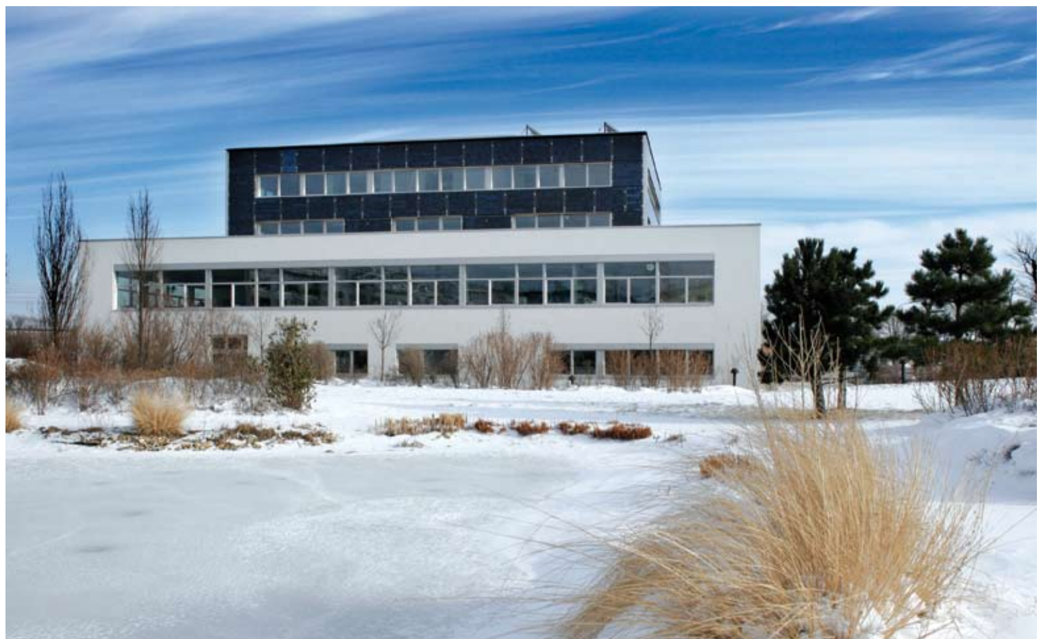
Abb. 1: SOL4, Ostfassade, Januar 2005. Foto: Kirschner
