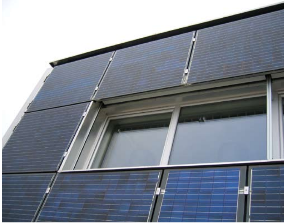
Abb. 6, 7: Photovoltaikfassade, CLIP-ON Befestigungsdetails. Fotos: Edeltraud Haselsteiner
