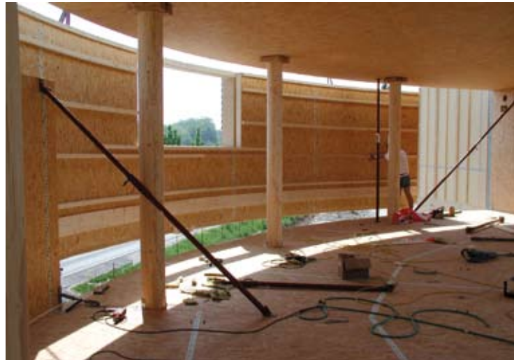
Abb. 8-10: Konstruktion der Rundholzstützen, Außenwände und Decken
