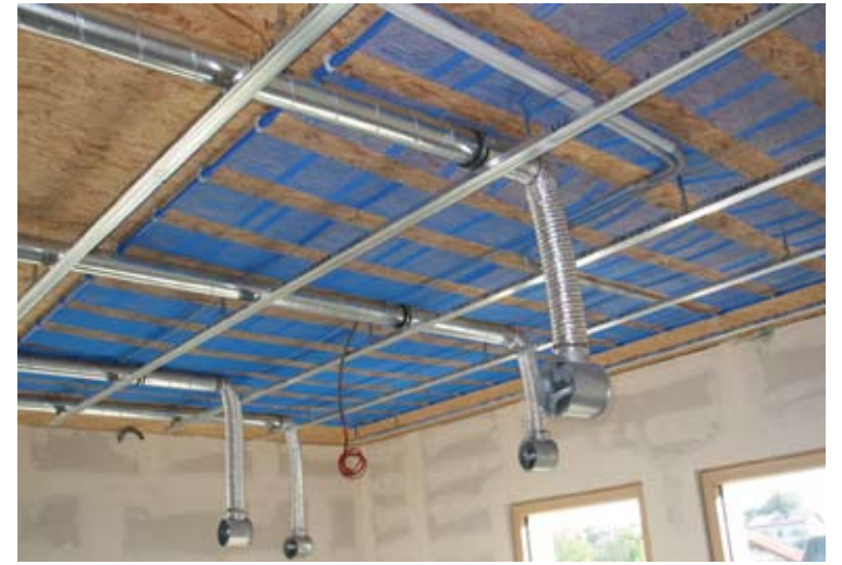
Abb. 11: Heiz-/Kühlflächen an der Decke mit Lüftungsrohren. Fotos: BBM
