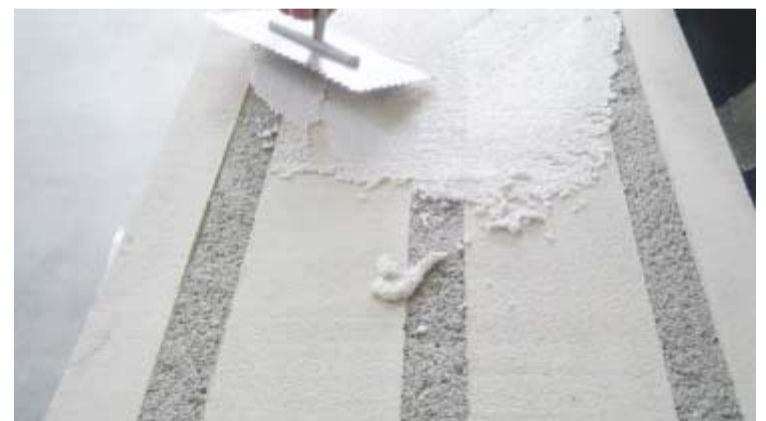
Abb. 13: Prototyp des aufgespritzten und verputzten Zellulose-Schlitzabsorbers
