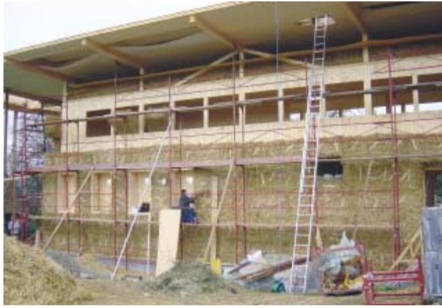
Abb. 7: Die Strohballen werden auf die Holzstangen der darunter liegenden Ebene gesteckt und gegen Verrutschen fixiert.
