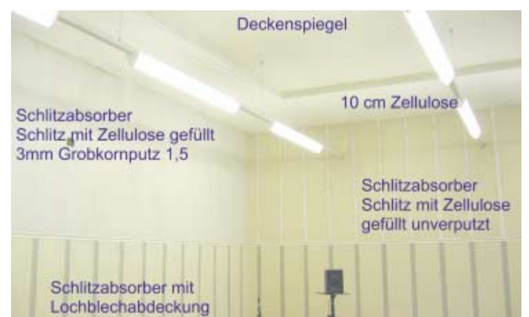
Abb. 14: Anordnung der Absorberflächen bei der akustischen Sanierung eines Klassenzimmers: Verputzte und unverputzte Zellulose-Schlitzabsorber sowie aufgespritzter, reinweißer Zellulose-Deckenabsorber und „Schallspiegel“ in Deckenmitte. Fotos: TU Graz
