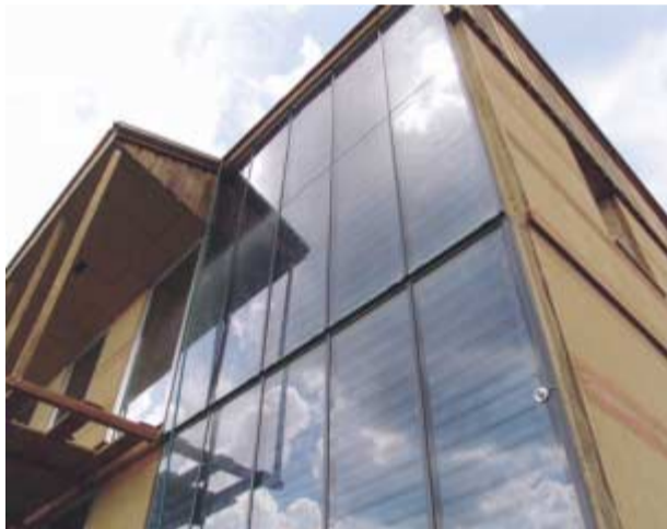
Abb. 4: Fassadenkollektor
