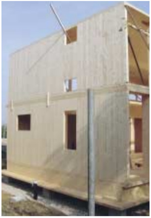
Abb. 6: Massivholz-Plattenkonstruktion als Innenhülle
