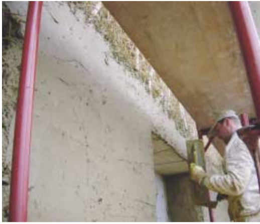
Abb. 8: Nach dem Aufbringen wird das Lehmmaterial glatt verstrichen.
