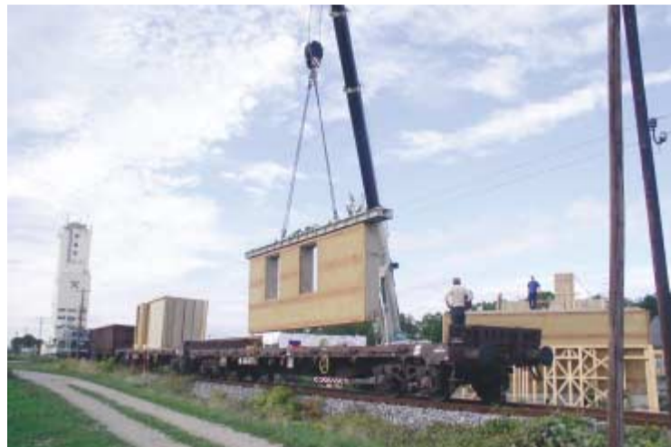
Abb. 3: Lieferung und Montage der Wand und Deckenmodule. Fotos (2), Grafiken: Georg W. Reinberg
