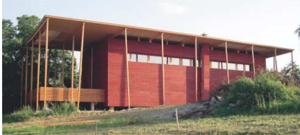
Abb. 10: Fertiggestelltes S-HOUSE. Fotos: GrAT
