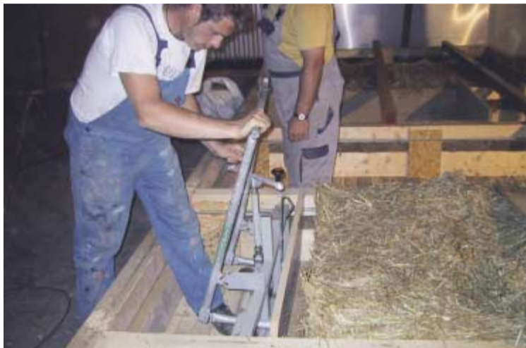
Abb. 2: Einbau der Strohdämmung in den vorgefertigten Holzrahmen. Foto: natur&lehm
