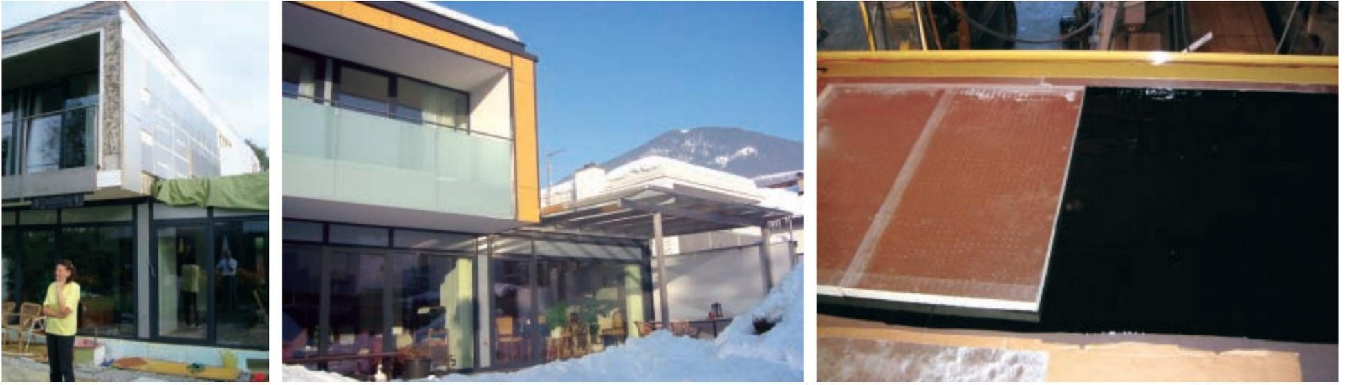
Abb. 15–17: Fassadensanierung mit Vakuumdämmplatten und VIP-3D-Dachsystem. Fotos: blitzblau
