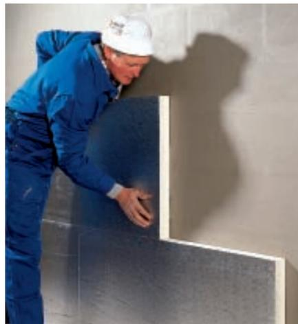
Abb. 7, 8: Vollflächig verklebte, alukaschierte Polyurethan-Hartschaumplatten. Ebenso einfach anzuwenden, aber ökologischer sind Innendämmsysteme aus Calciumsilikat (kapillaraktiv) oder Schaumglas (dampfdicht). Fotos: Steinbacher
