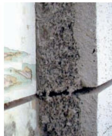
Abb. 9: Schnitt durch das Innendämmsystem: Tragfähige Putz- und Farbschichten wurden vor dem Aufbringen der Zellulosedämmung nicht entfernt. Foto: TU Graz
