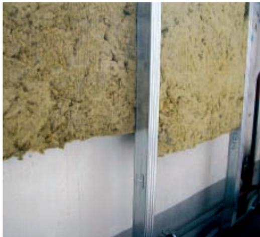
Abb. 6: Mineralwolle-Innendämmung zwischen Ständerkonstruktion. Foto: Energie Tirol
