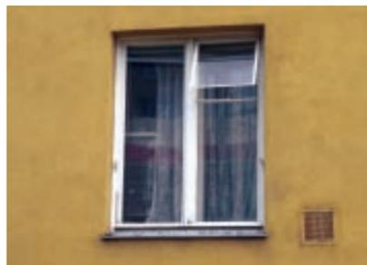
Abb. 13, 14: Lüftungsflügel Fenster aus dem „Katalog der Modernisierung“
