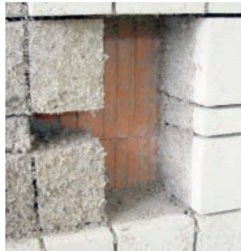
Abb. 8, 9: Aufgespritzte Zellulosedämmung, herausgetrennte Prüfkörper. Fotos: Michael Mandel (4)
