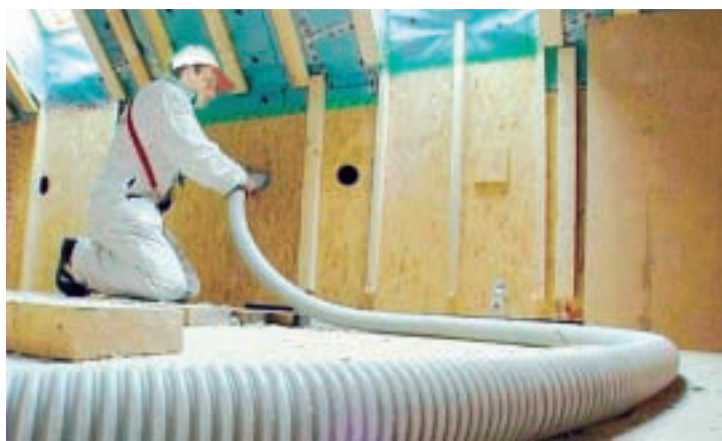
Abb. 10, 11: Eingeblassene Zellulosedämmung, Wand und Dach. Fotos: Thermofloc (2)
