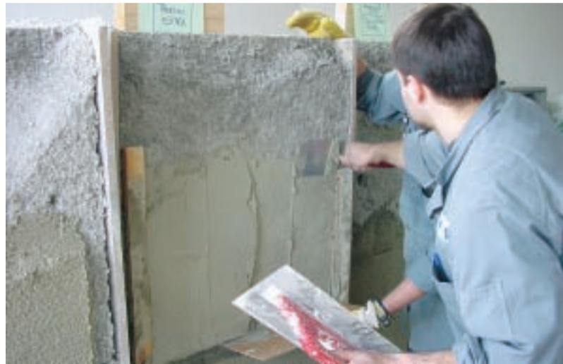
Abb. 7: Aufbringen einer Putzschicht auf aufgespritzter Zellulosedämmung
