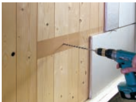
Abb. 10, 11: Eingeblassene Zellulosedämmung, Wand und Dach. Fotos: Thermofloc (2)
