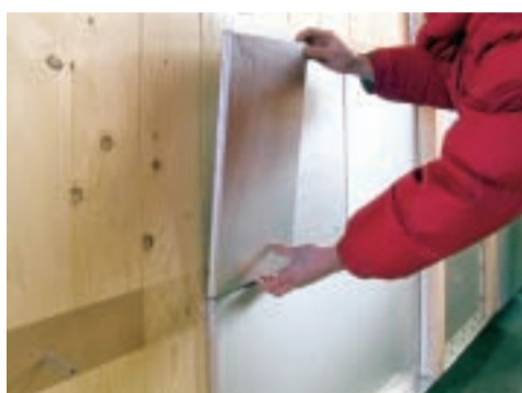
Abb. 12a bis 12f: Mechanisch befestigte Vakuumdämmplatte
