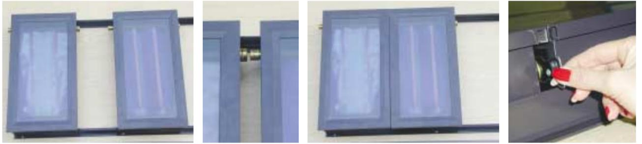
Abb. 4–7: Montage der Integral SUN2000 Kollektoren: Einlegen und Zusammenschieben; Einrasten & Zusammenkuppeln; Verbindung mittels Sicherungsfeder. Fotos: Siko Solar
