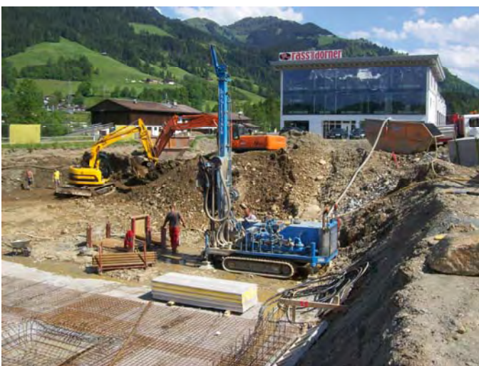
Bild: Erdsondenbohrungen für die Heizung und Kühlung der Arche Neo
