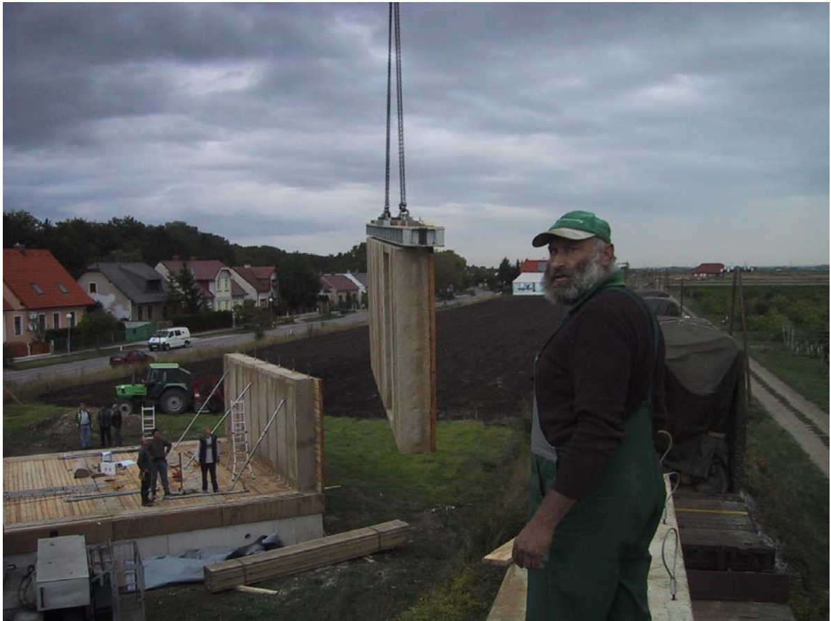
Bild 4: Montage mit 80 t Kran (Maximalgewicht 7 t pro Modul)
