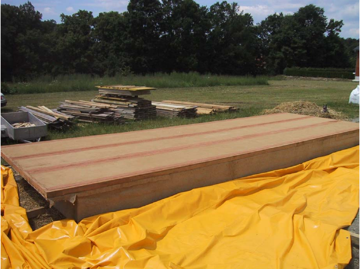
Bild H: Zwischenlagerung und Trocknung der Deckschicht der zuletzt gefertigten Module im Freien vor der Halle, da der Platz unter Dach in der Halle nicht für alle Module ausreichte. Hier das Erdgeschoß-Giebelwandmodul, geschoßhoch, Länge 9 m.
