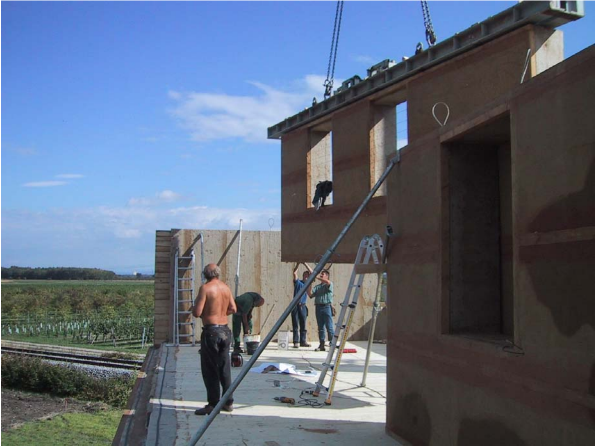
Bild 6: 3.Tag: Versetzen und Verkleben der Wandelemente mit Lehm-Vliestechnik im OG
