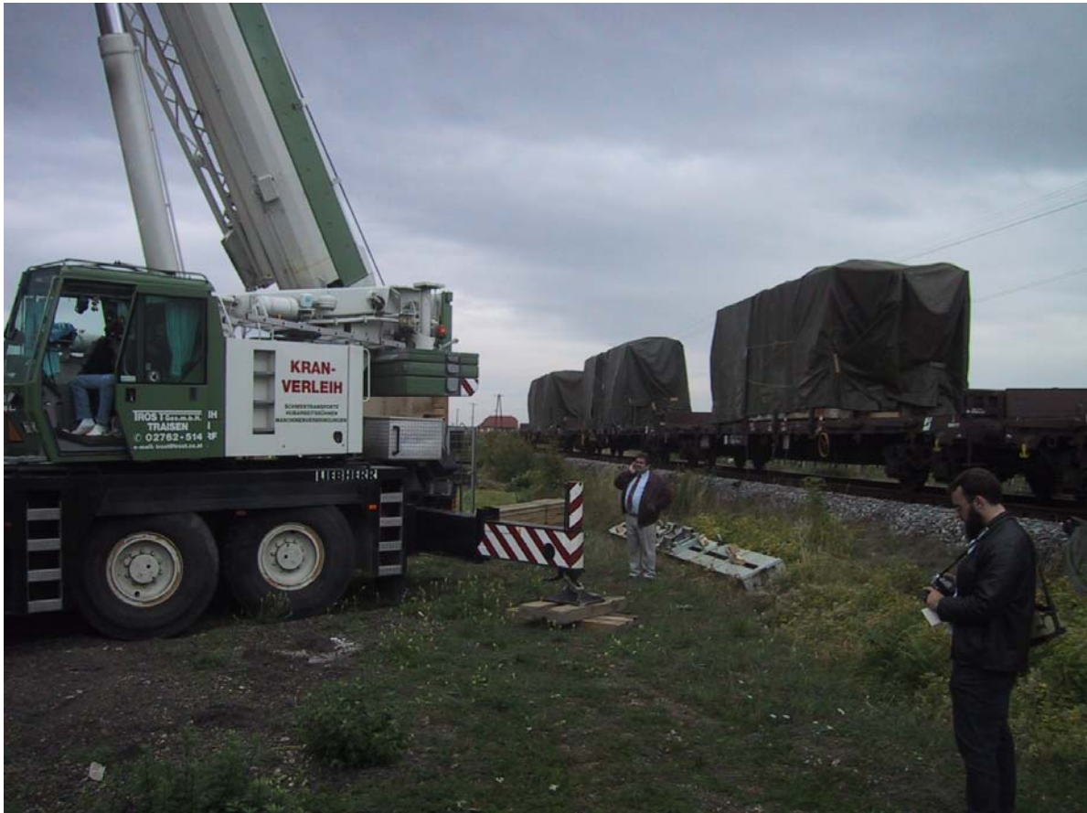
Bild 3: 2.Tag: Pünktlicher Antransport der Wandmodule
