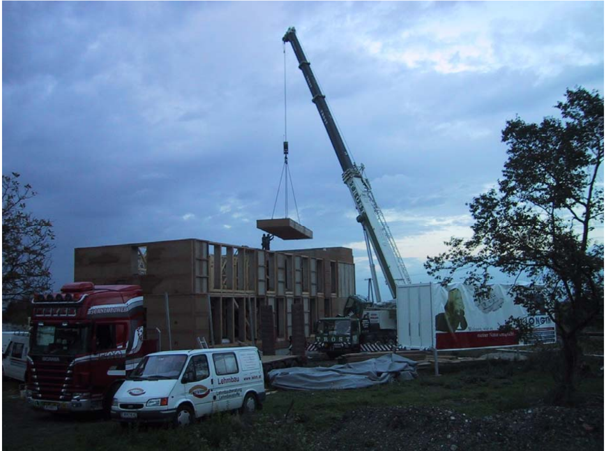
Bild 11 Das 2. Dach-Modul wird versetzt,
