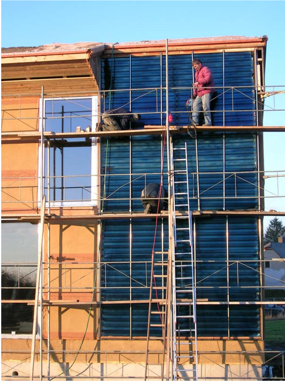
Bild 16 Montage des thermischen Fassadenkollektors
