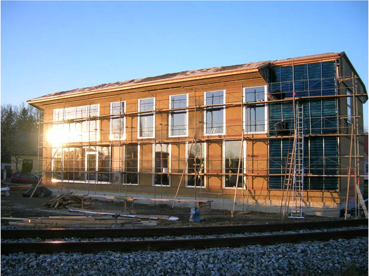
Bild 17 Fertig verglaste Solarfassade mit Terrassentür und Fassadenkollektor
