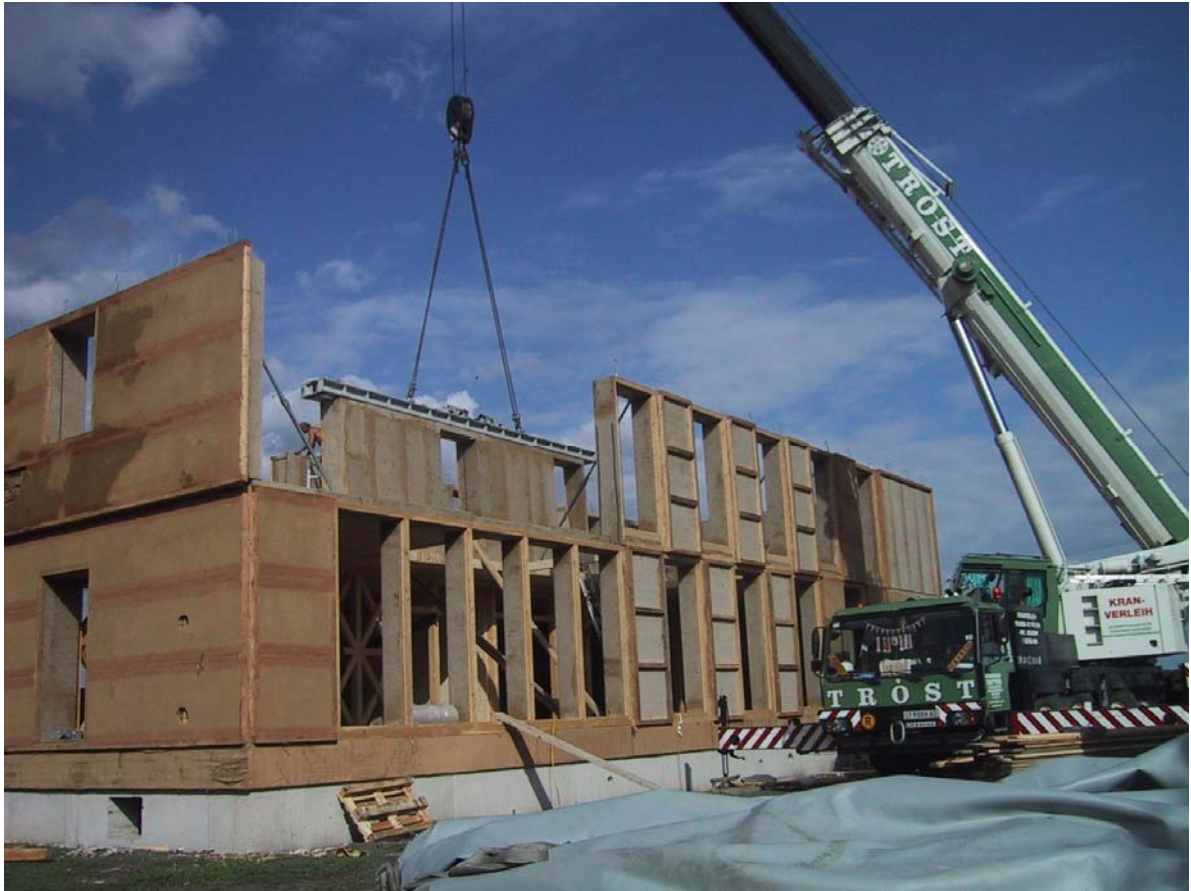
Bild 9: Südfassade mit versetzendem Kran
