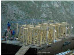
Montage Holz-Stahl-Konstruktion Erdgeschoss
