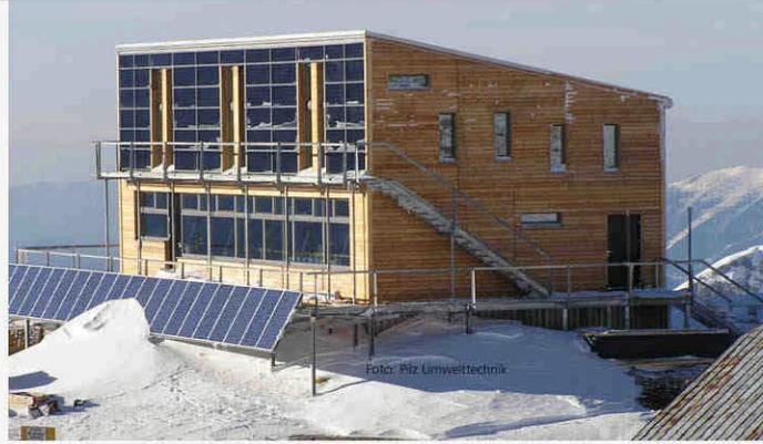
Südostansicht November 2004, Photovoltaik Paneele vor Terrasse, Solarthermie fassadenintegriert im Obergeschoss
