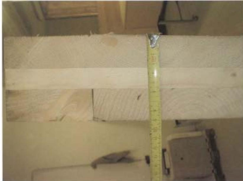
Grundkonstruktion: Kreuzlagen-Platte (dreischichtig)
