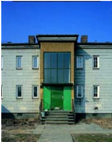
Abb.: Belß- Lüdeckestraße (GSW Berlin), 2003 Siedlung vor der Sanierung
