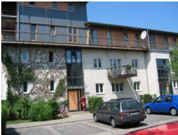
Abb.: Belß- Lüdeckestraße (GSW Berlin), 2003 Siedlung nach der Sanierung
