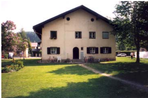
Abb.: Südtiroler Siedlung (GSWB, Bischofshofen), 2003 Haus 2 vor der Sanierung
