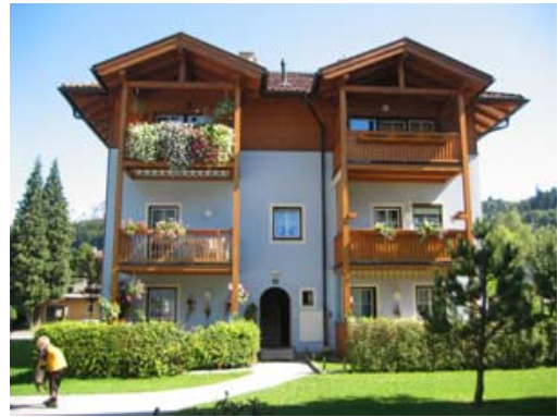
Haus 1 nach der Sanierung
