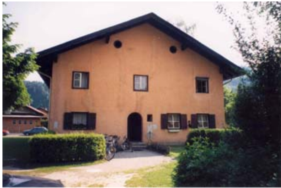
Abb.: Südtiroler Siedlung (GSWB, Bischofshofen), 2003 Haus 1 vor der Sanierung
