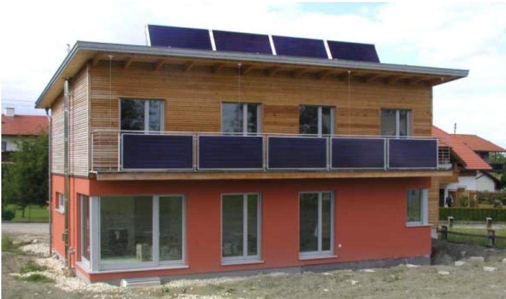
Abb. 10: Das Haus der Pilotanlage mit Dach- und Balkonkollektoren.
