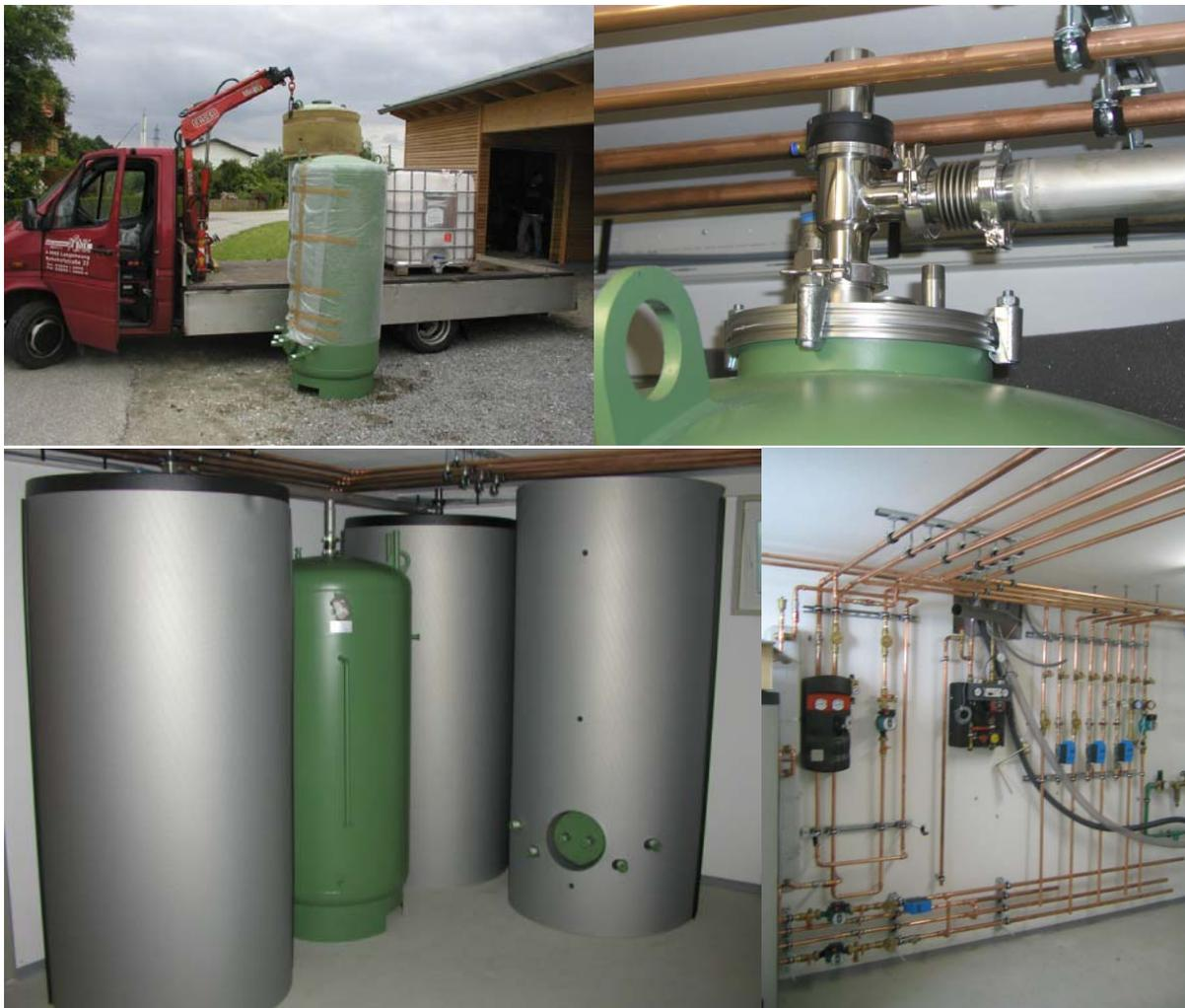
Abb. 12: Installation der Pilotanlage (Anlieferung der Speicher (links oben), Dampfventil an einem Sorptionsspeicher (rechts oben), Sorptionsspeicher, Pufferspeicher und Vorratsbehälter (links unten), Installation der Hydraulikkreise (rechts unten))
