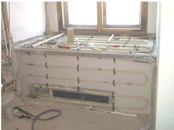
Abbildung 61: Abluftelement am Kastenfenster in Bau
