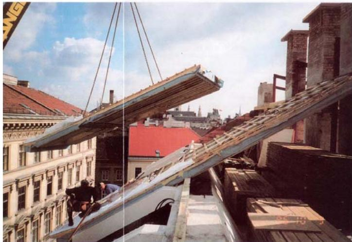
*Abbildung 36: Versetzung der vorgefertigten Dachelemente*
