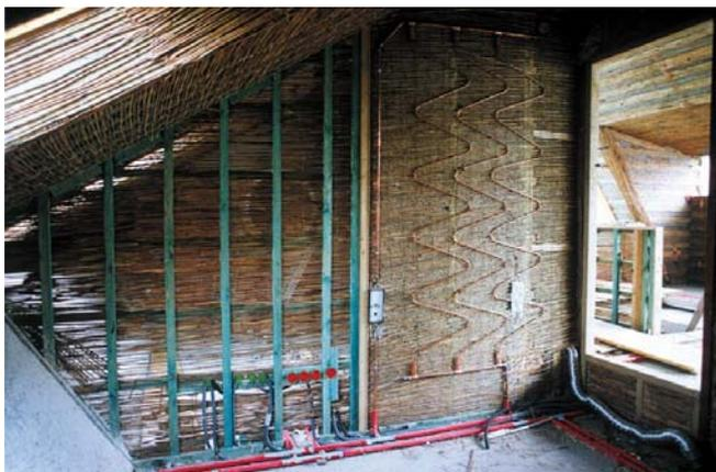
*Abbildung 35: Wandheizelemente auf Schilfmatten als Putzträger*
