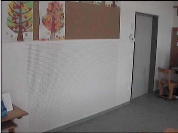
*Abbildung 57: Schallgedämmte Überströmöffnung in einer Klasse mit Quelllufteffekt.*
