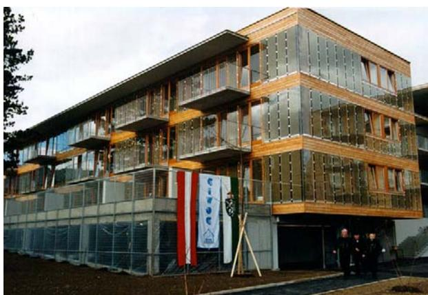
Einen Ausnahmefall stellt die energetisch transparente Wärmedämmung mit Kartonwaben über einer ausreichenden Dämmlage dar, diese vermag zwar nicht viel Energie zu gewinnen, der dynamisch ermittelte U-Wert wird aber je nach Orientierung nahe Null zu liegen kommen bzw.  $0,1 \text{ W/m}^2\text{K}$  auch im Norden bei richtiger Dimensionierung nicht überschreiten.
