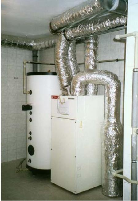
Abbildung 16: Wärmepumpenkompaktaggregate für Passivhäuser. Die gesamte Haustechnik für Heizung, Warmwasser und Lüftung ist in einem Kompaktgerät von Gefrierschrankgröße integriert. (Quelle: Projektdokumentation Penka, AEE)
