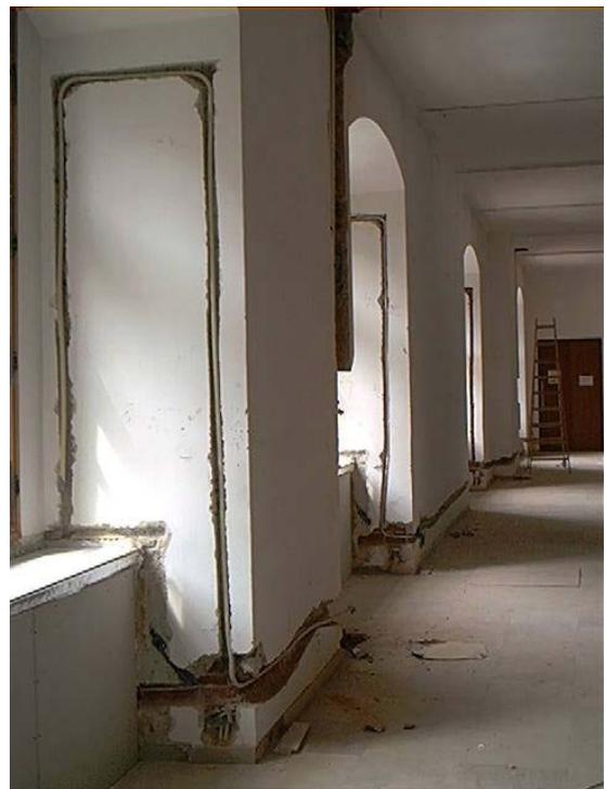
Abbildung 62: Bauteilheizung
