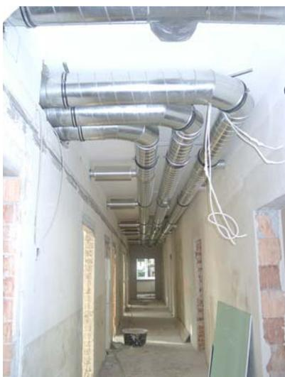
Abb. 1: Zuluftkanäle mit Abzweigen in die Büros, Abluftkanal in der Mitte
