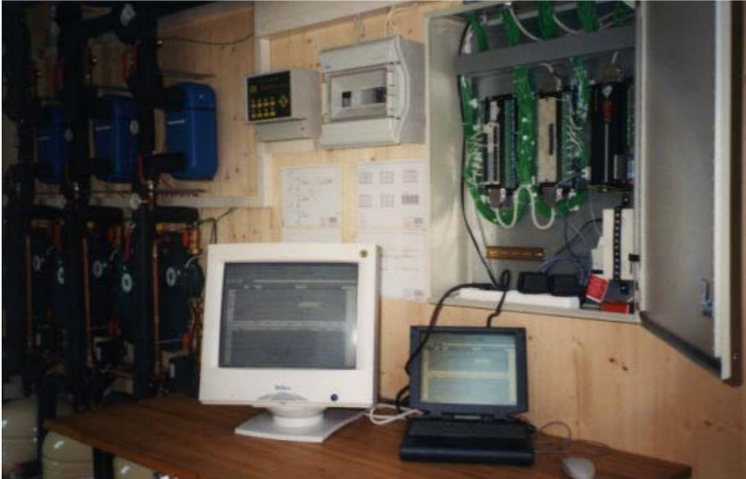
Abbildung 16: Ansicht des Messdatenerfassungssystems (Schaltschrank, Regler und Visualisierung)
