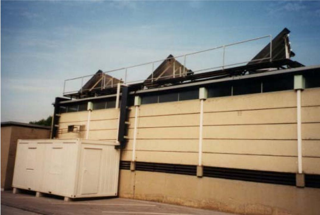
Abbildung 7: Seitenansicht der Versuchsaufbauten. Einzelkollektoren am Flachdach und Container zur Aufnahme sämtlicher Hydraulikinstallationen, Regelungen und der messtechnischen Einrichtungen.
