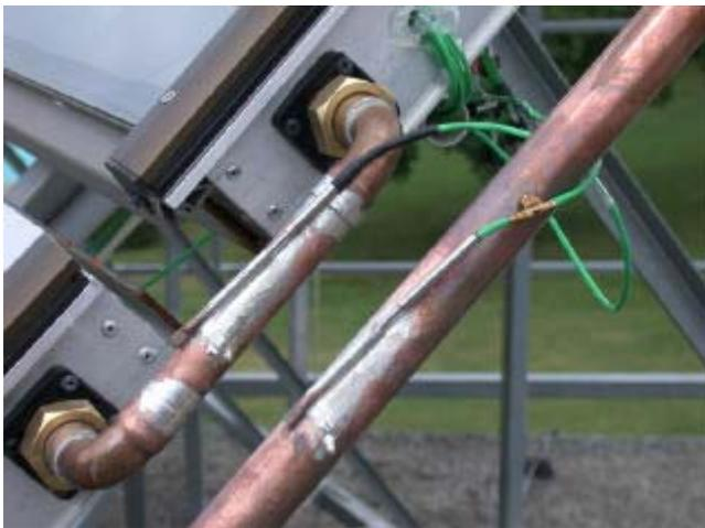
Abbildung 66: Hydraulische Verbindungsleitungen zwischen den Kollektoren inkl. Temperatursensoren (ungedämmter Zustand).
