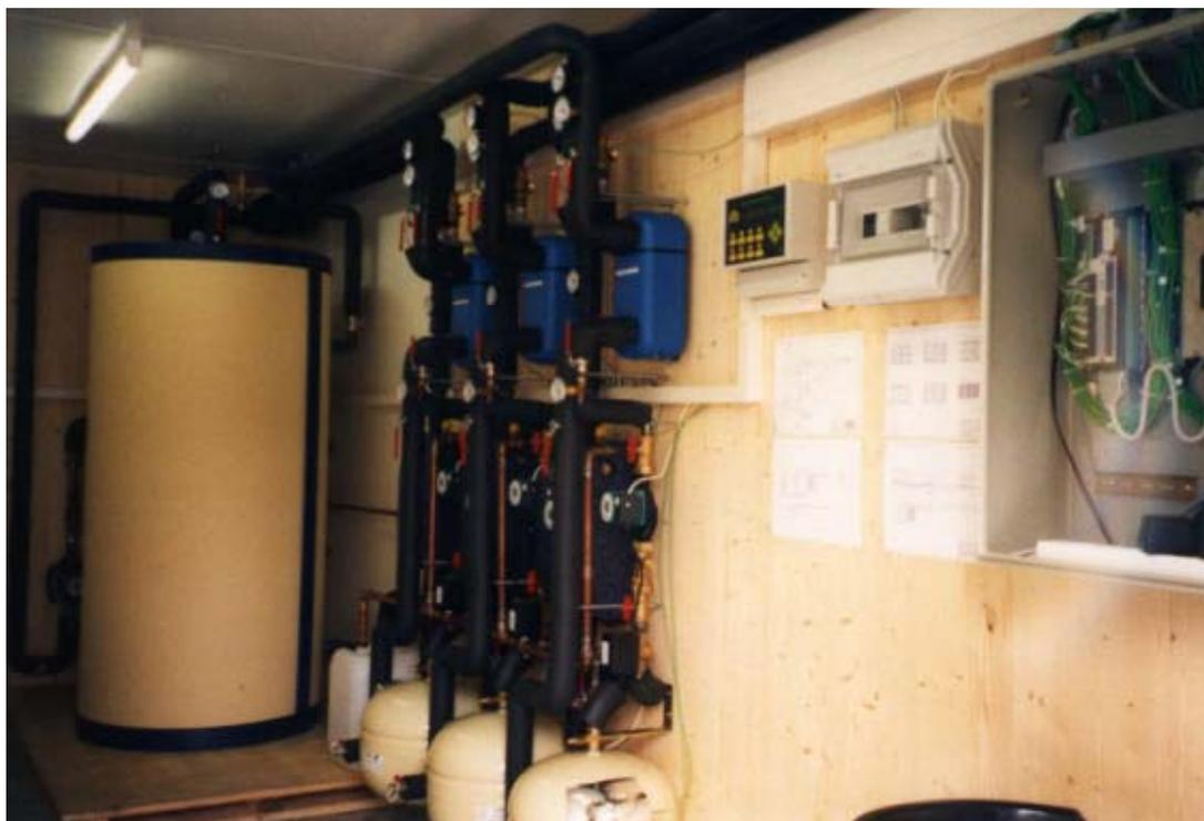
Abbildung 6: Ansicht der Hydraulikinstallation sowie der freiprogrammierbaren Regelung im Container des Versuchsstandes der AEE INTEC
