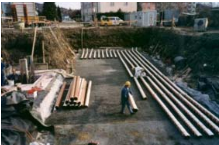
Abbildung 80: Verlegung der 15 parallelen PVC-Rohre unter der Fundamentplatte des Gebäudes
