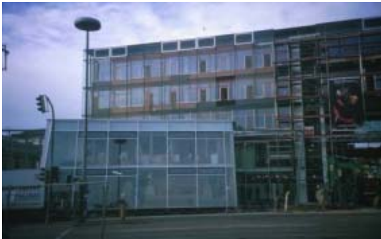
Abbildung 89: Süd- Ostansicht des Bürogebäudes. Im Bild ist deutlich die Doppelfassade ersichtlich
