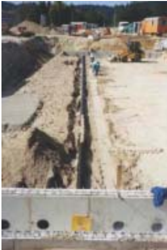
Abbildung 102: Verlegung des Rohrregisters. Im Vorder- und Hintergrund sind die beiden Sammelschächte ersichtlich
