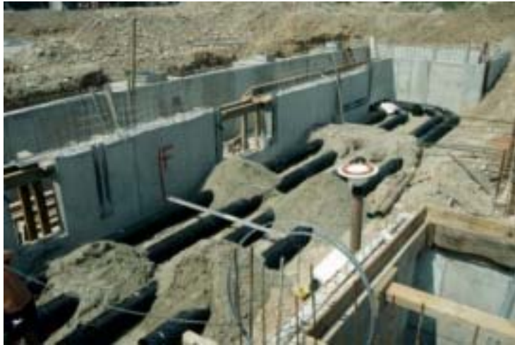
Abbildung 86: Verlegung der EWT Rohre. Es wurde 7 PE-Rohre mit je 100 m entlang des Gebäudes verlegt.
