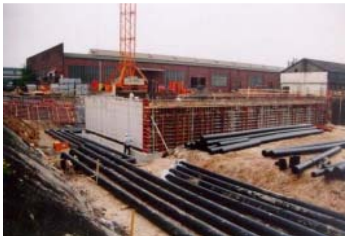
Abbildung 95: Verlegung der EWT Rohre. In Summe wurden 2100 m Rohr verlegt.
