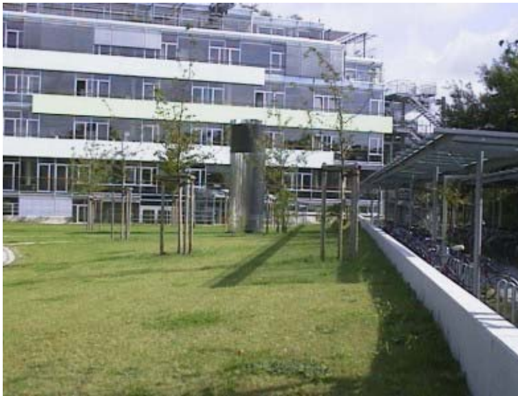
Abbildung 97: Bürogebäude der Landesversicherungsanstalt Schleswig – Holstein mit dem Ansaugturm des EWT im Vordergrund.
