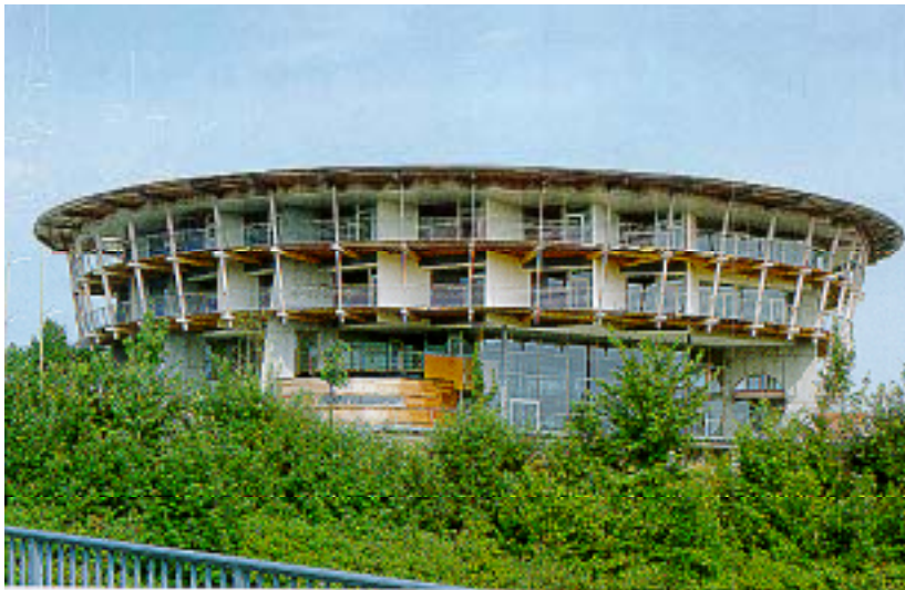
Abbildung 87: Südansicht des Bürogebäudes Gniebel
