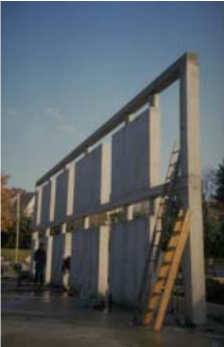
Abbildung 78: 25 cm starke Innenwand aus Stahlbeton als Speichermasse
