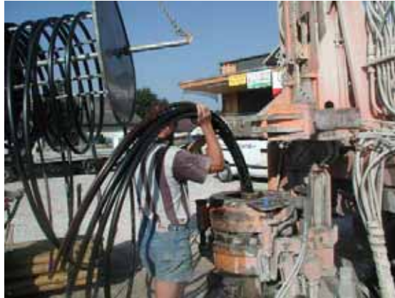
Abbildung 6: Einbringen der Tiefensonden - vier Rohre je Sonde, über das fünfte Rohr (rote Markierungsstreifen) wird das Bohrloch hinterfüllt. Beim ChristophorusHaus wurde das spezielle Hinterfüllmaterial "Stüwatherm" verwendet, das die Wärmeleitfähigkeit durch Zugabe von Quarzkorn im Vergleich zu konventionellen Bentonit-Zement-Gemischen um bis zu zehn Prozent erhöht.
