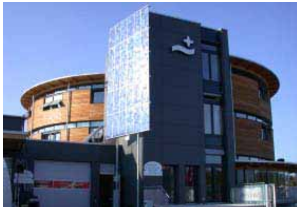
Abbildung 7: 90° geneigtes Sonnensegel (3,6kW peak )
