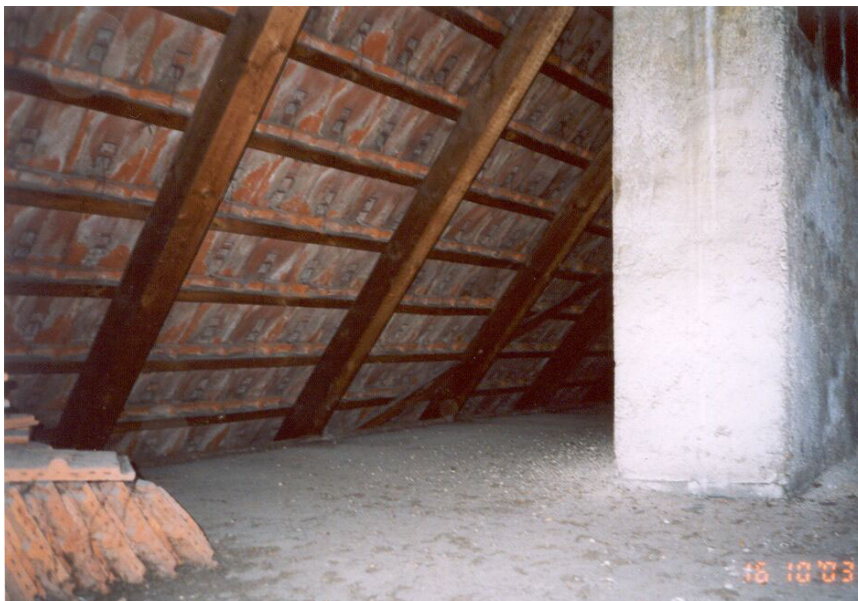
Oberste ungedämmte Geschossdecke
