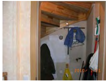
Abbildung 23: nicht abgedichtetes, außer Betrieb genommenes Abgasrohr (ohne Abbildung vor Anlegen des Unterdruckes)
