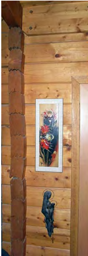
Abbildung 3: Verformungen und Vorköpfe des BV ART im Erdgeschoß
