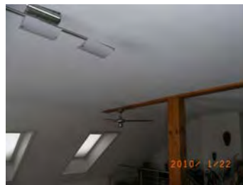
Abbildung 37: Leckagen im Bereich der Firstpfettendurchdringung und eines Ventilator-Elektroanschlusses sowie eines Dachflächenfensters (ohne Abbildung vor Anlegen des Unterdruckes)
