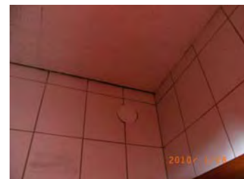
Abbildung 13: Leckagen im Bereich des Anschlusses der abgehängten Decke an die Innenwand und der Installation
