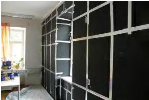
Abb. A5 Innenwanddämmung geklebt
