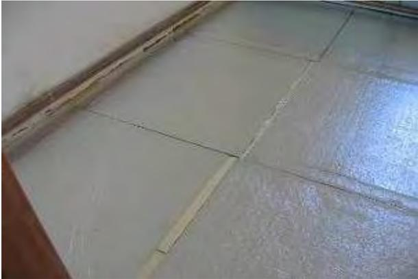
Abb. A3 Dämmung auf Fußboden im Innenbereich mit erkennbarer Fugenbildung aufgrund von Maßungenaugigkeiten
