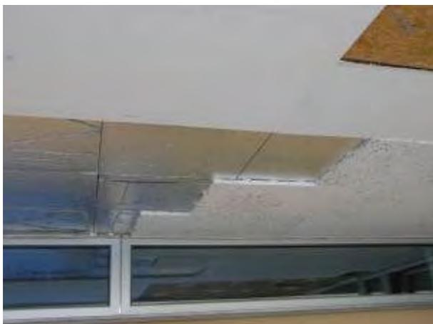
Abb. A7 Deckenverlegung geklebt als WDVS
