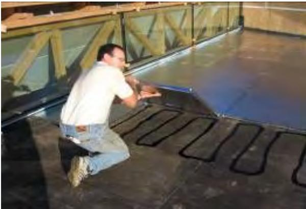
Abb. A4 Verlegung von Vakuumdämmung im Klebeverfahren auf einem Flachdach
