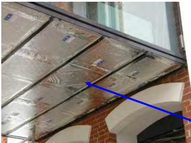
Abb A6 Deckenmontage in Klemmleistenteknik mit erkennbarem belüftetem Paneel
