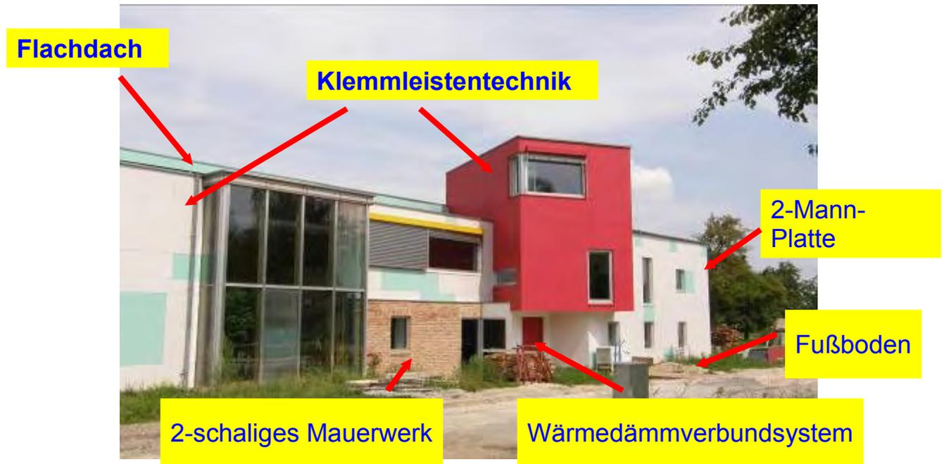
Abb A8 Übersicht der Lage der durchgeführten Befestigungsmöglichkeiten am HDZ-Projekt "Erste Sanierung eines Bauernhauses auf Passivhausstandard mit Vakuumdämmung"
