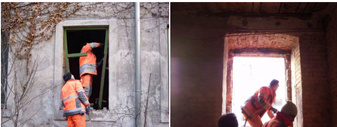
Abbildung 80: Abbruch Fenster und Herstellen Glattstrich
