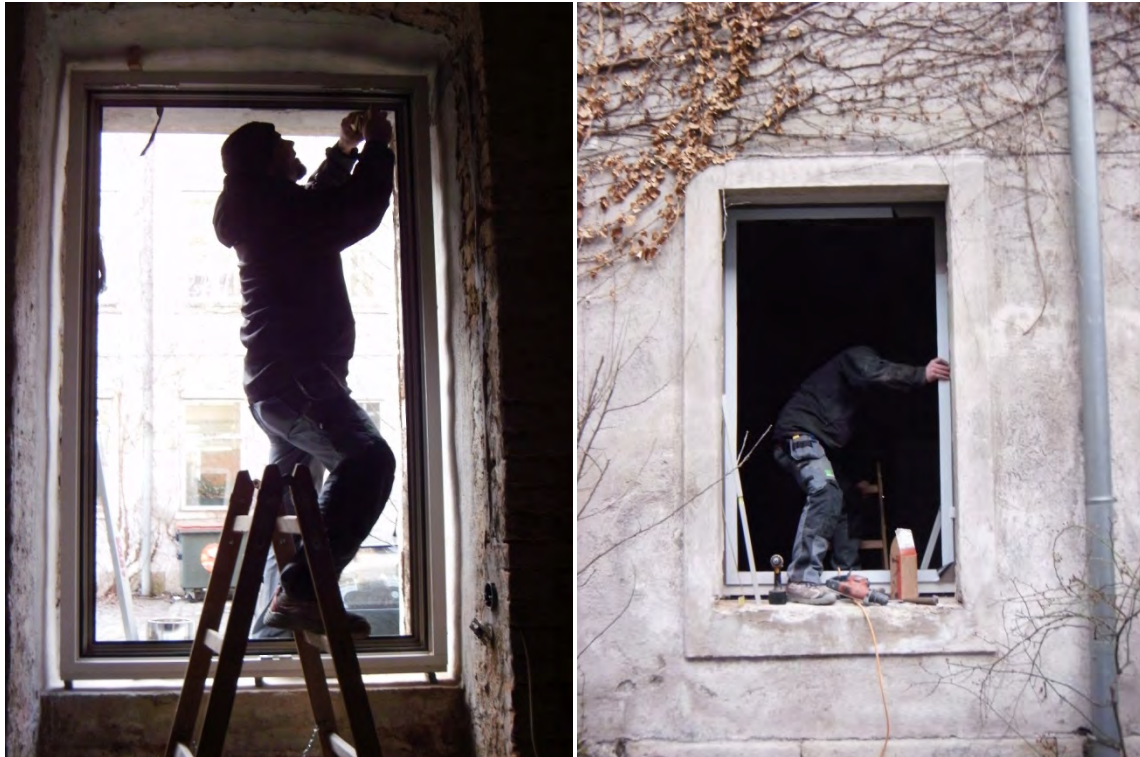
Abbildung 81: Einbau Fenster
