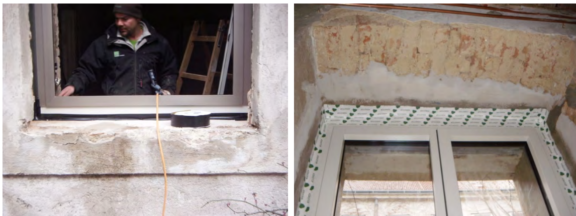
Abbildung 82: Abdichtung außen und innen
