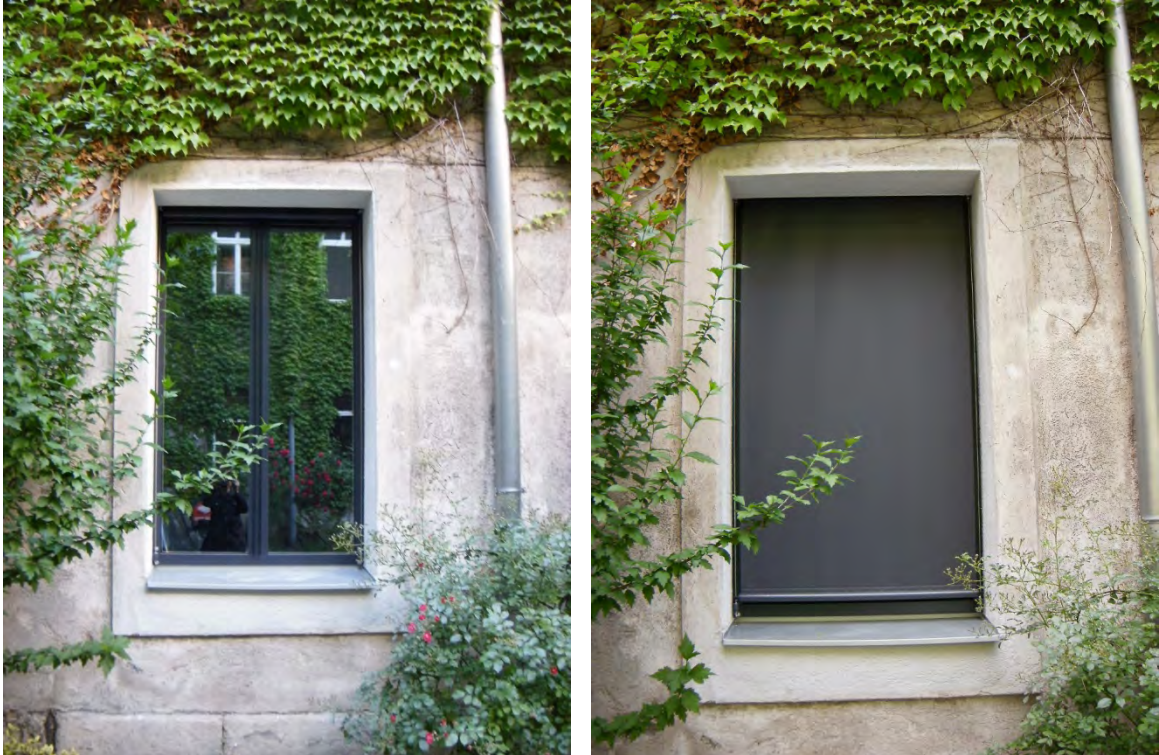
Abbildung 83: Eingebautes Fenster, rechts mit geschlossener Markise
