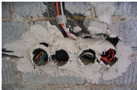
**Abbildung 1: SO NICHT! Ungeeignet eingesetzte Steckdosen in einer Massivwand (Altbausanierung). Hier sind auch nach dem Verputzen der Wandfläche Leckagen an den Kabeleinführungen und Dosenrückseiten zu erwarten (Foto: Passivhaus Institut).**
