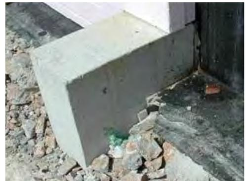
**Kellerdecke** - Die Betonierarbeiten wurden wegen häufiger Wetterwechsel und unüblich tiefer Temperaturen mehrmals verschoben. Zur Gewichtsersparnis wurde die Decke nur 14cm stark bemessen. Dies brachte große Schwierigkeiten beim Eisenbinden und beim Anbringen der Schweißgründe, die als Ankerplatten für den aufgehenden Holzbau bedeutsam sind. Die Kellerdecke bildet die wesentliche Schnittstelle zwischen den Gewerken Massiv- und Holzbau.
