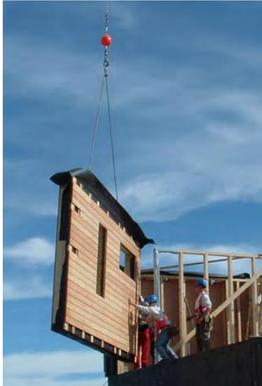
**Dachfertigteile** – Das Transportgewicht jedes der 15 Teile betrug einschließlich Dämmung und beidseitiger Beplankung ca. 900kg, was vor allem bei den häufig vorkommenden Windböen an die Grenzen des Flugvermögens ging.
