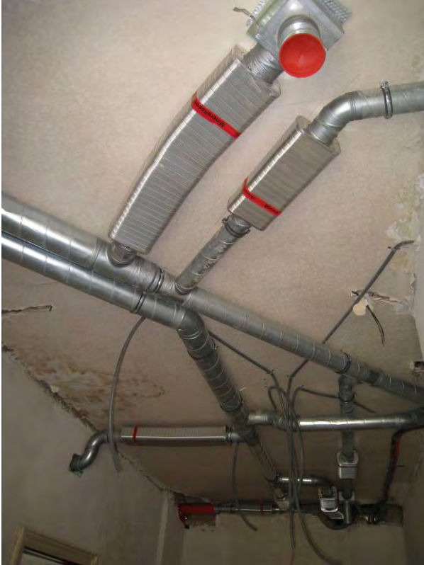
Lüftungsrohre roh, Nebenraum vor Verkleidung
