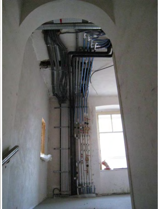
Installationen roh Stgh vor Verkleidung
