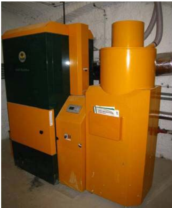
Pelletskessel im KG Althaus
