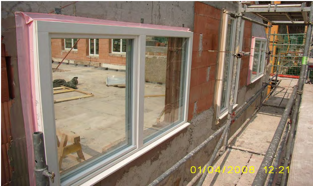
Luft- und dampfdichte Einbindung ans Mauerwerk aussen
