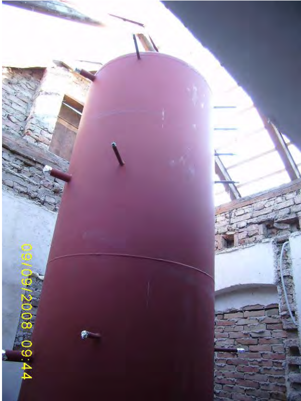
Speicher roh in Nebengebäude offen
