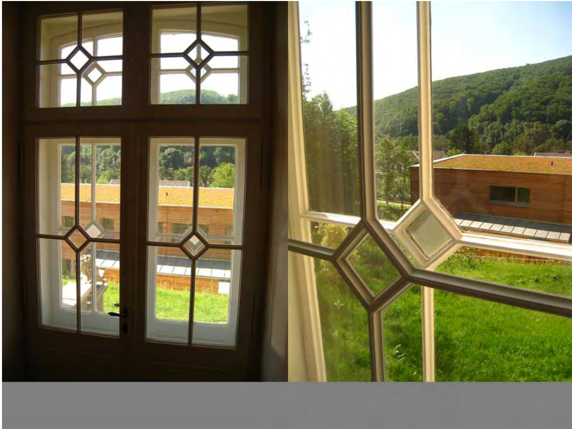
Sprossenbildung aussen Original glasteilend, Innen bei 2fach Isolierverglasung aufgesetzt
