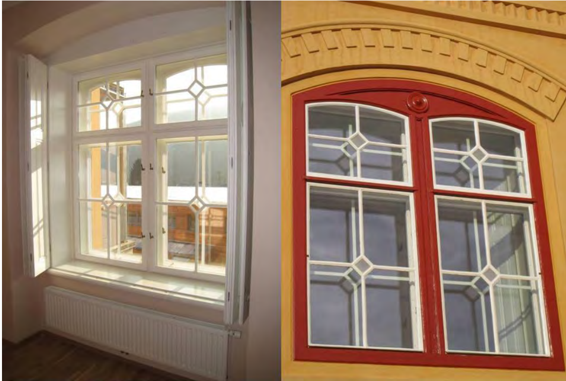
Fenster zweiteilig neu Innen- und Aussenansicht
