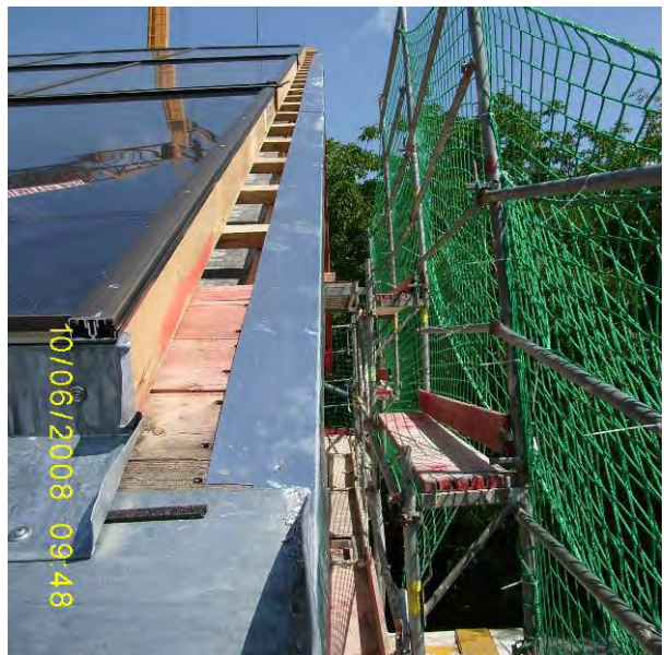
Kollektorelemente konstruktiver Anschluss First und Ortgang vor Verblechung
