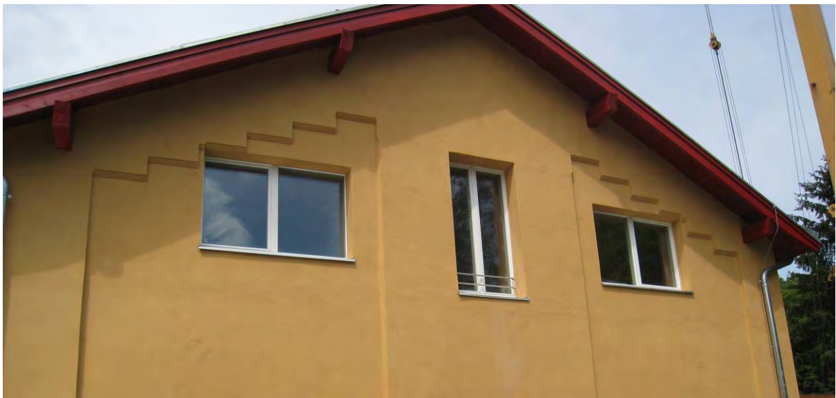
Ansicht Ost DG, Rahmen überdämmt
