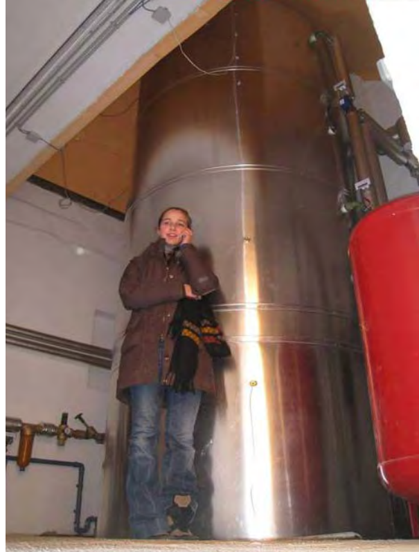
Speicher & Gebäude gedämmt und verkleidet
