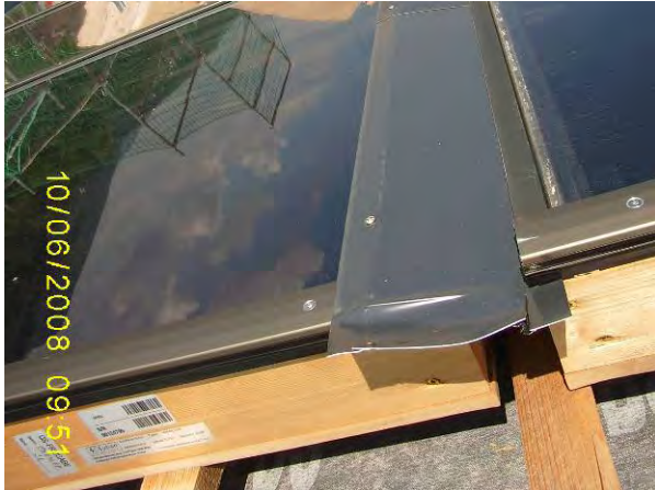
Kollektoren Zwischenverblechungen der Einzelfelder
