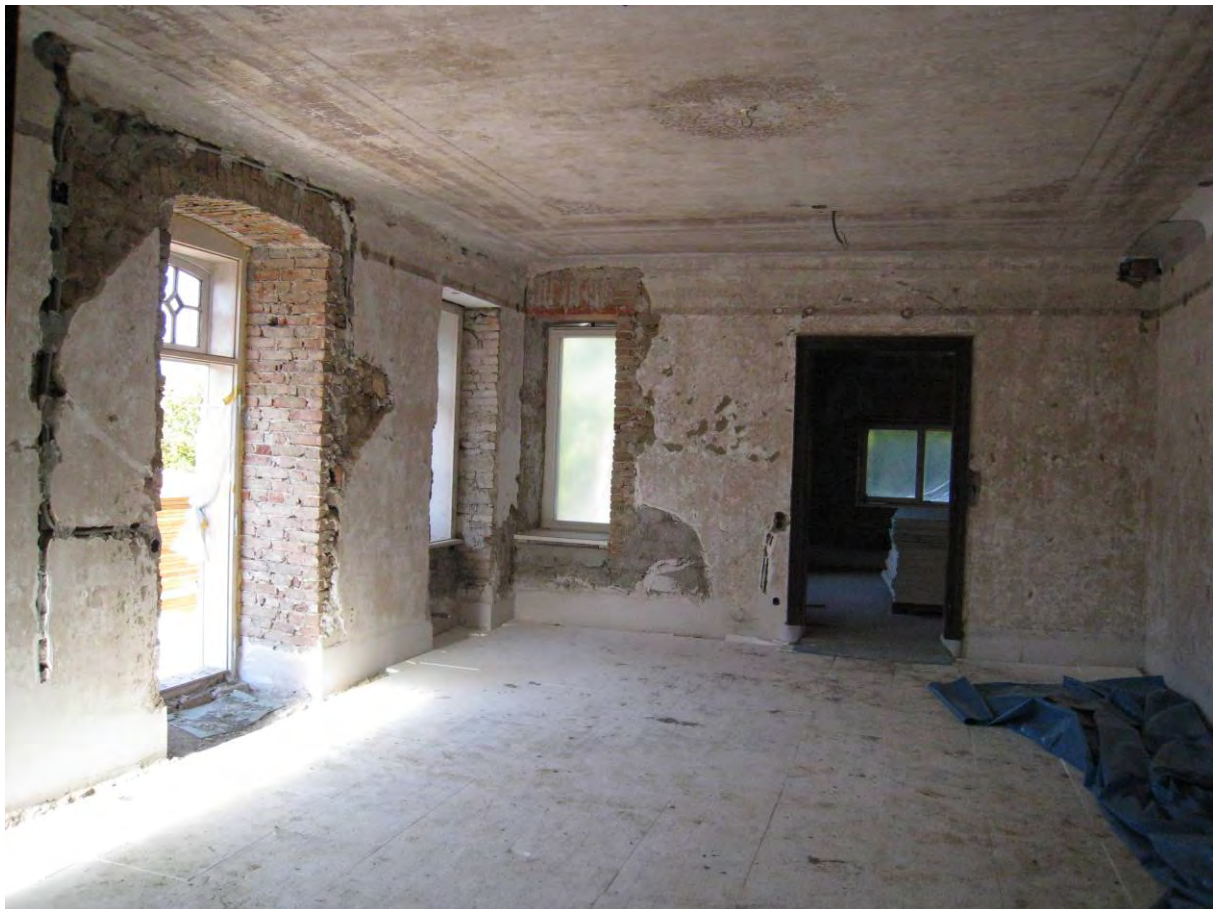
Wohnraum EG EPS dämmplatten vor Aufbringung von Estrich und Dampfsperre
