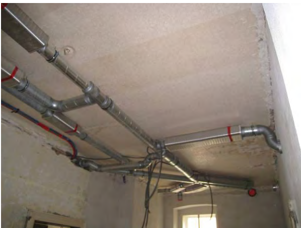
Lüftungsrohre roh Nebenraum vor Verkleidung
