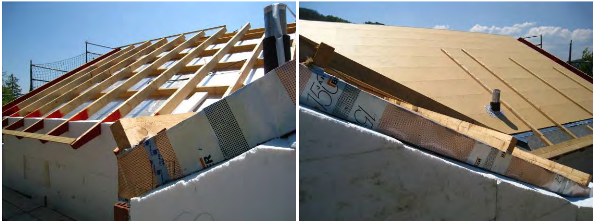
Dach Südfläche Konstruktion vor Dämmung; Nordfläche mit Unterdach & tlw. Konterlattung
