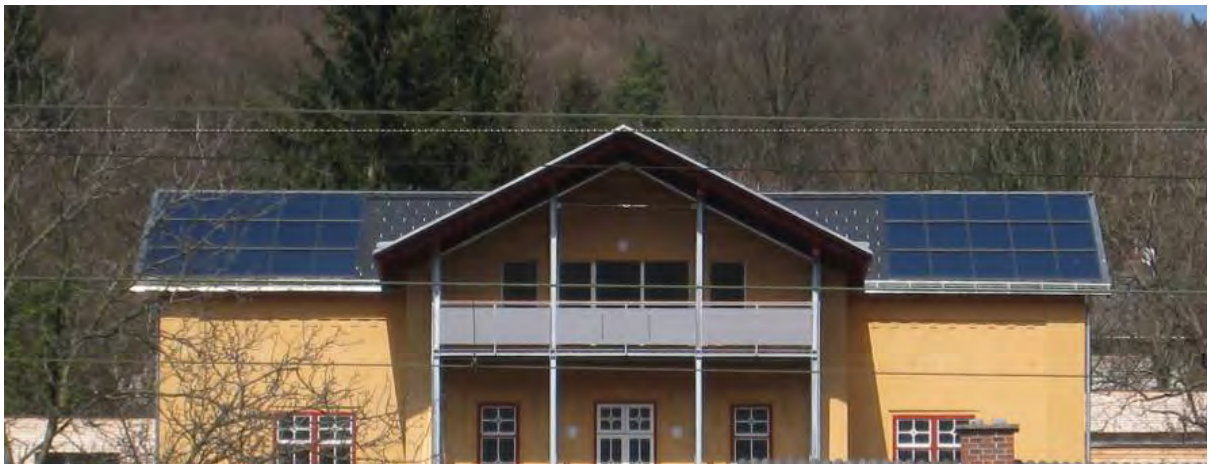
Ansicht Kollektoren dachintegriert
