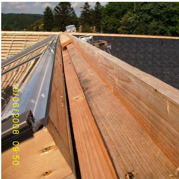
Kollektorelemente konstruktiver Anschluss First und Ortgang vor Verblechung
