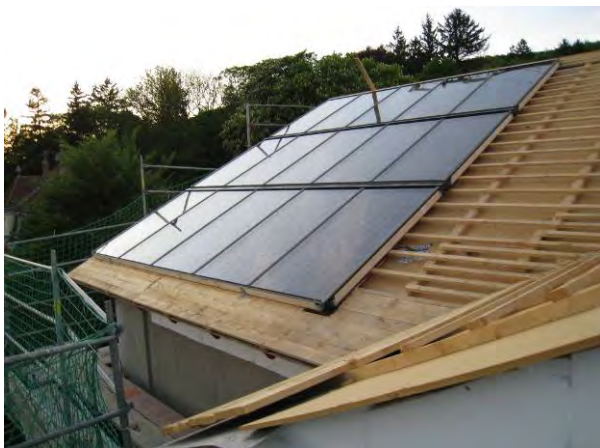
Kollektorelemente Südwest und Südost vor Verblechung
