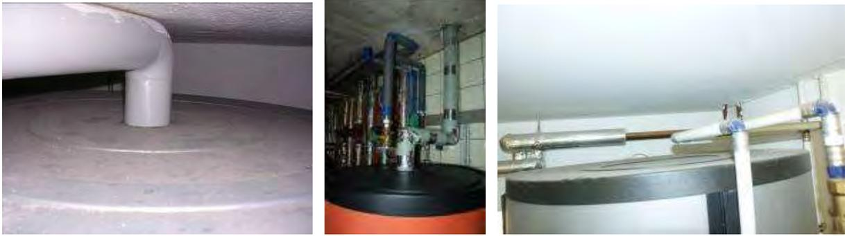
Abbildung 41: Beispiele für einen gut gedämmten oberen Bereich des Speichers mit im günstigsten Fall vollkommen geschlossenen Dämmungsdeckel (Quelle: AEE INTEC)
