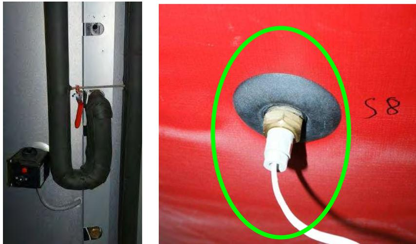
Abbildung 42: Beispiel für gute / akzeptable Installationsdetails: links: gedämmter Thermosiphon (Quelle : INES Education); rechts: gut fixierter Temperaturfühler, die freiliegende Metallmuffe stellt jedoch noch eine Schwachstelle dar und könnte vermieden werden (Quelle: AEE INTEC)
