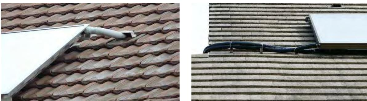
*Abbildung 16: links: gut gedämmte Rohrleitung im Außenbereich inklusive Schutz; rechts: die außengeführte Rohrleitung ist zwar gut gedämmt, der Schutz fehlt jedoch; (Bildquelle: INES Education / Frankreich)*
