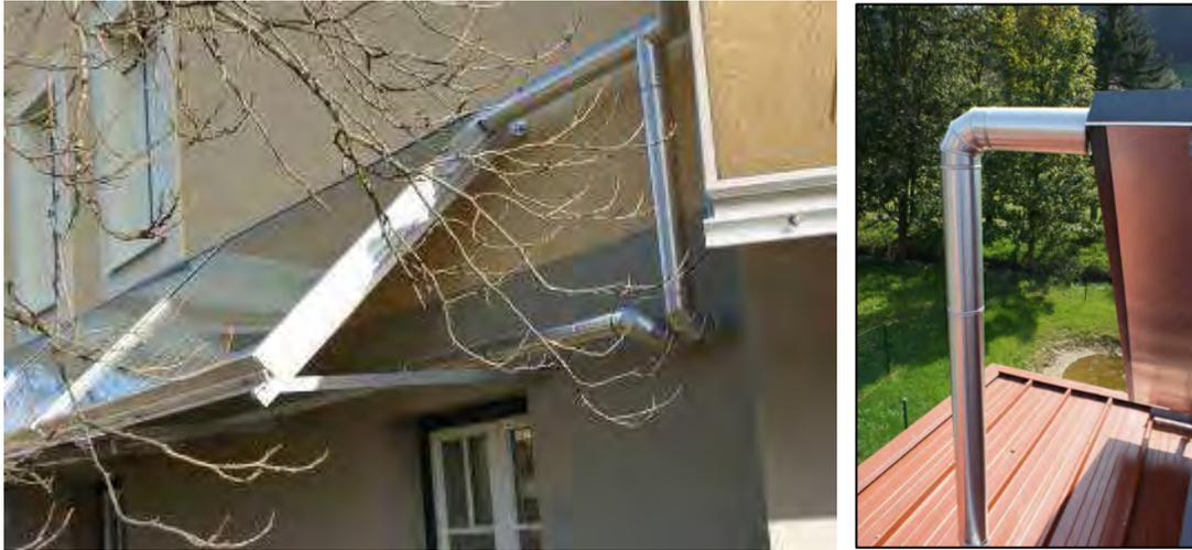
Abbildung 46: Rohrdämmung im Außenbereich (Quelle: AEE INTEC / Austria)
