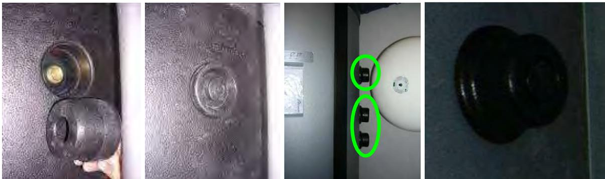
Abbildung 43: gute Beispiele für vorgefertigte Installationselemente für ungenutzte Rohranschlüsse am Speicher (Quelle: Sonnenkraft: links; Bösch: rechts).
