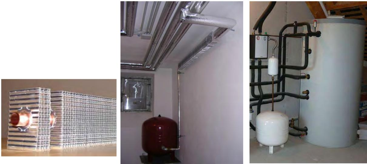
*Abbildung 48: Stagnationskühler, ausgeführt als eine Heizleiste (links), im eingebauten Zustand (mitte), oder der Einbau eines "Vorschaltgefäß"(rechts) schützen das Expansionsgefäß im Falle der Stagnation*
