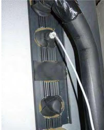
*Abbildung 44: Beispiel für zumindest nachträgliche Isolierung der Rohranschlüsse und Temperaturfühler – auch für ungenutzte Anschlüsse (Quelle : INES Education)*
