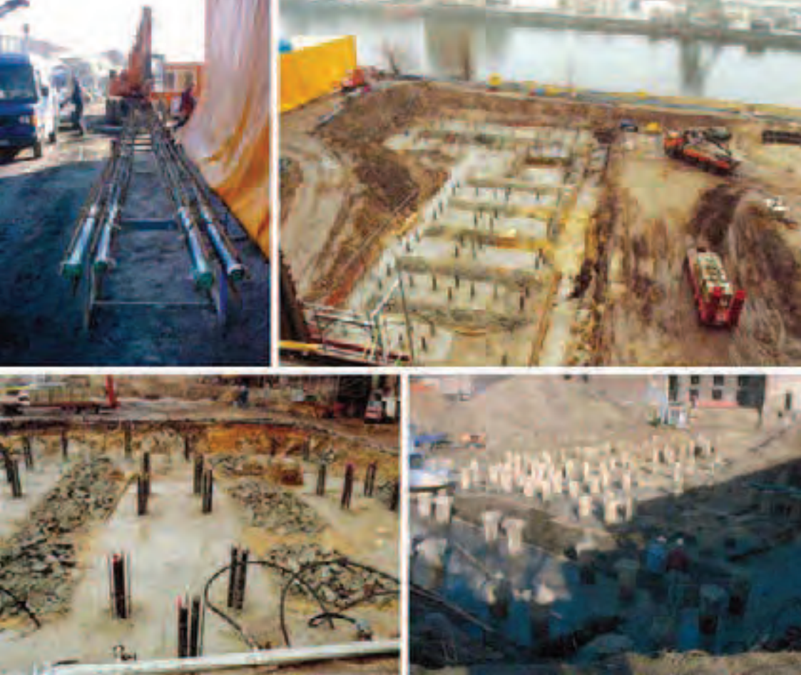
◀ Abbildung 1 Herstellung von Energiepfählen
