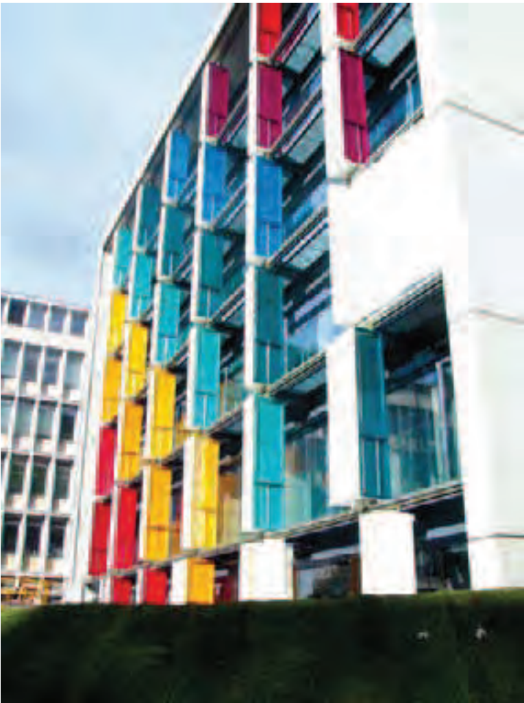
▲ Abbildung 1 Gebäude der Biokathalyse der TU-Graz, Österreich
