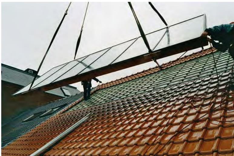
**Abbildung 22** Montage der Solarkollektoren am REH Brüssel (Quelle: EREC)
