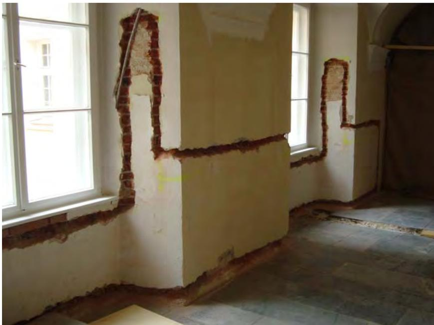
**Abbildung 45** Für die Rohrführung der Bauteilheizung vorbereitete Außenwände im Gangbereich des Klosters (Quelle: AEE INTEC)
