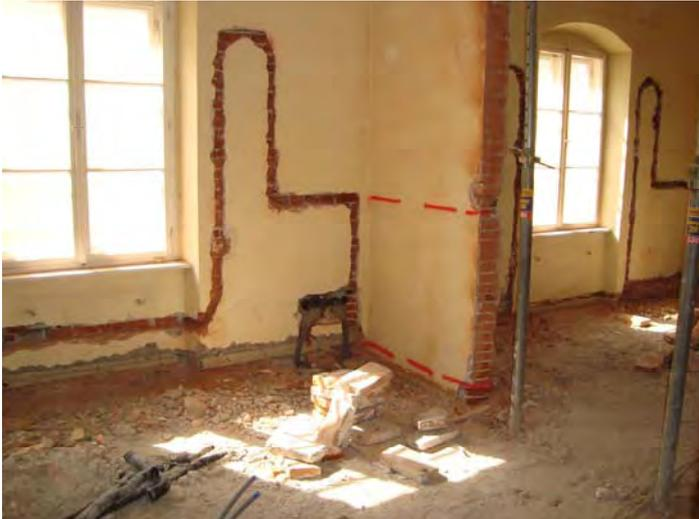
**Abbildung 36** Bauteilheizung - Rohrführung in den Klosterräumen (Quelle AEE INTEC)
