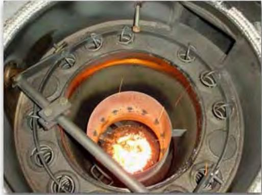
**Abbildung 18** Der Pelletskessel des REH Brüssel in Betrieb (Quelle: EREC)
