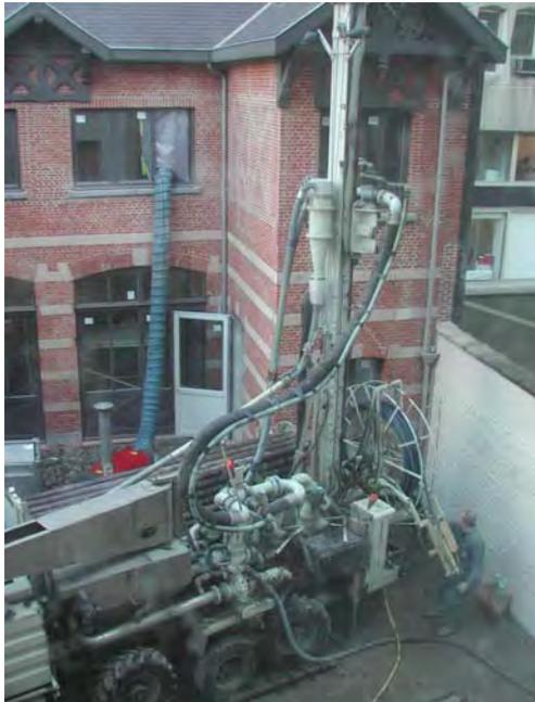
**Abbildung 19** Anbringen der Bohrlöcher für die Wärmepumpenanlage im Hof des REH Brüssel (Quelle: EREC)
