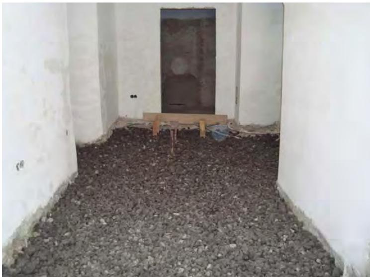
**Abbildung 33** Einbringen von Schaumglasschotter in den Gängen des Klosters (Quelle: AEE INTEC)
