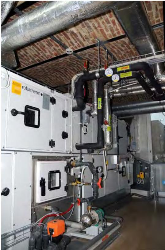
**Abbildung 23** Kernstück der Heizungs-, Lüftungs- und Kühlungsanlage im Keller des REH Brüssel (Quelle: EREC)
