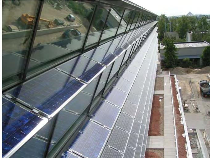
Abbildung 3-7: Fassadenintegration von PV-Elementen, ENERGYbase
