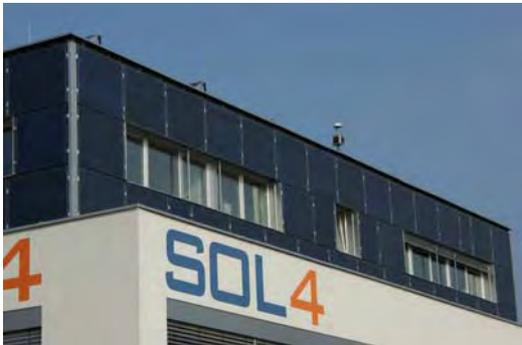
Abbildung 8: Ansicht Fassade mit Photovoltaikmodulen [AEE INTEC]
