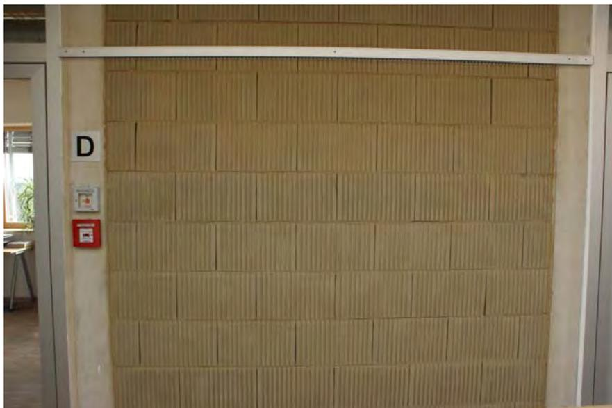
Abbildung 3: Innenwand aus speicheroptimierten Lehmziegeln [AEE INTEC]
