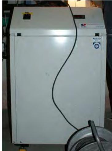
Abbildung 5: Wärmepumpe SOL4 [AEE INTEC]
