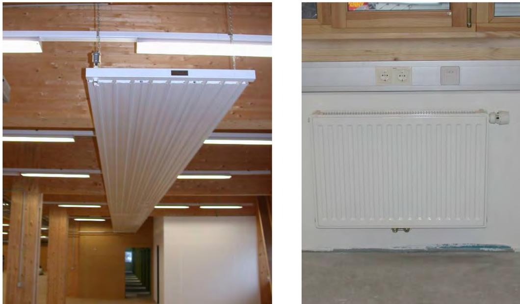
Abbildung 9: Links: Deckenstrahlplatten im Lager des Obergeschosses, Rechts: Radiator in einem Büro
