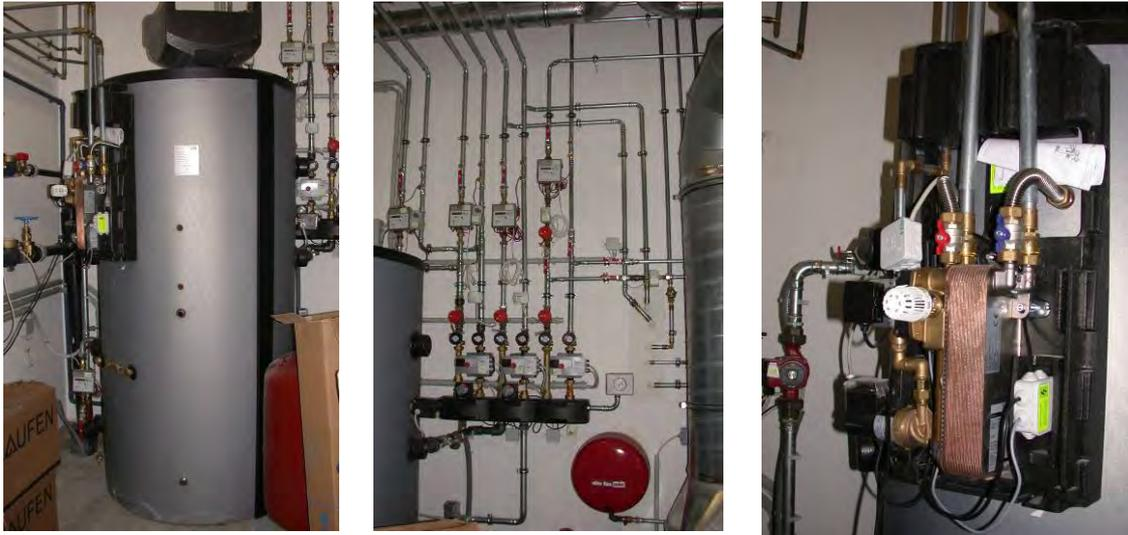
Abbildung 8: Links: Pufferspeicher mit integriertem Frischwassermodul; Mitte: Heizungsverteiler Technikraum; Rechts: Heizungsverteiler im Technikraum; Rechts: Frischwassermodul am Pufferspeicher
