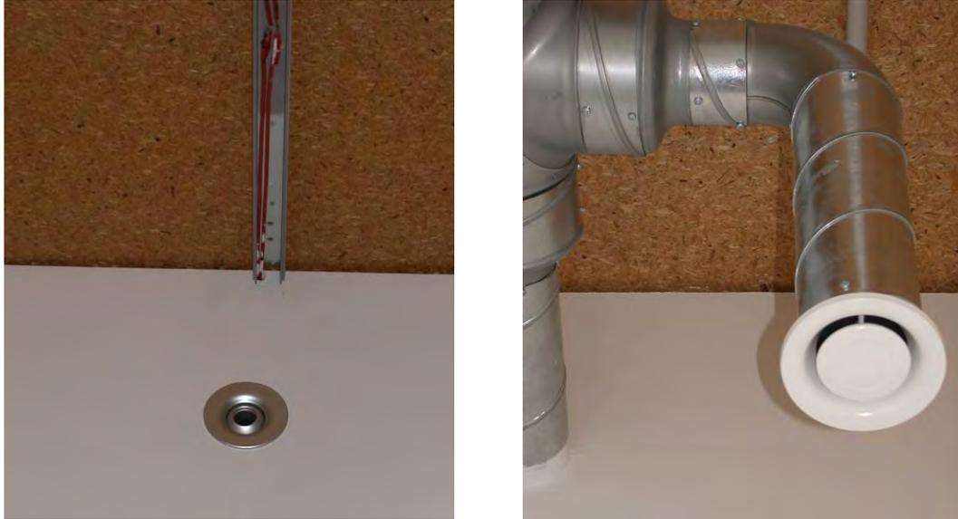
Abbildung 7: Links: Zuluftöffnung – Weitwurfdüse in einem Büro; Rechts: Abluftöffnung - Tellerventil (links) in einem Nassraum
