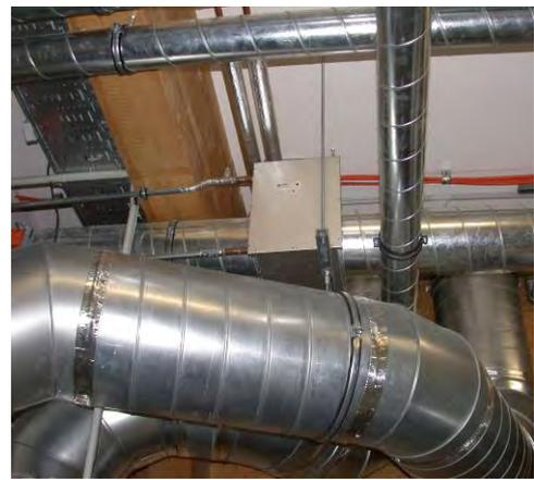
Abbildung 6: Links: Vorheizung/Vorkühlung mittels Solekreis; Mitte: zentrale Nachheizung der Zuluft; Rechts: Nachheizregister in der Zuluft zum Verkaufsbereich
