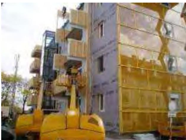
Abbildung 5: Vorgefertigte und wärmegeämmte Module am Dieselweg, Graz (Quelle: AEE INTEC)
