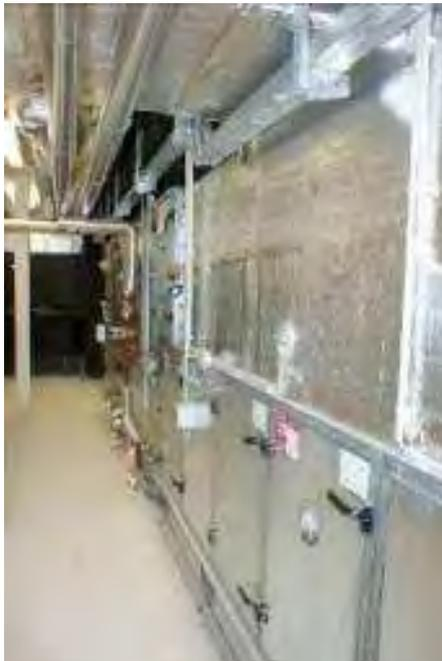
Abbildung 25: Große Lüftungsanlage mit integrierter Wärmerückgewinnung
