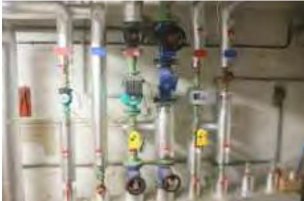
Abbildung 23: Wärmeverteiler- und integriertes Steuerungssystem (Quelle: AEE INTEC)
