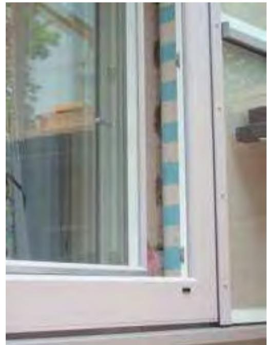
**Abbildung 24** Fensterlaibung mit Dampfbremse (Quelle: AEE INTEC)
