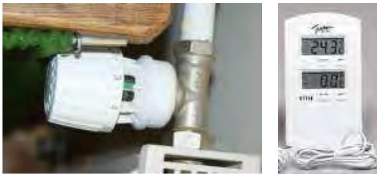
Abbildung 22: Thermostatventil und Außentemperatursensor
