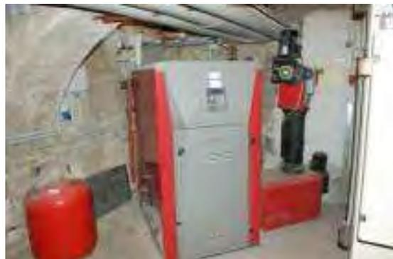
Abbildung 20: Scheitholz und Hackschnitzelkessel (Quellen: AEE INTEC)
