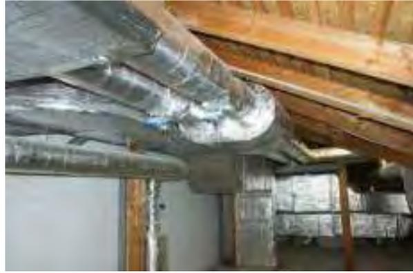
Abbildung 24: Lüftungsgerät mit integrierter Wärmerückgewinnung und gedämmte Lüftungsleitungen
