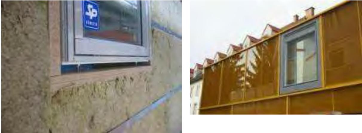
Abbildung 8: Dreischiebigenverglaste Wärmeschutzfenster mit einem U-Wert von  $0,85 \text{ W/m}^2\text{K}$ , verwendet im Pilot-Projekt Brogården/Sweden (linkes Bild) und in die Module integrierte Passivhausfenster am Dieselweg Graz (Quellen: SP und AEE INTEC)
