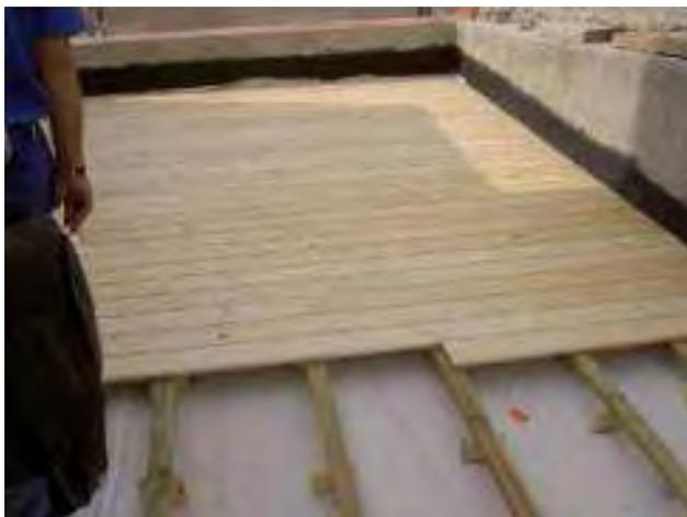
Abbildung 315: Hinterlüftetes Dach des spanischen Pilot-Projektes St Joan de Malta/Barcelona (Quelle: TTA)
