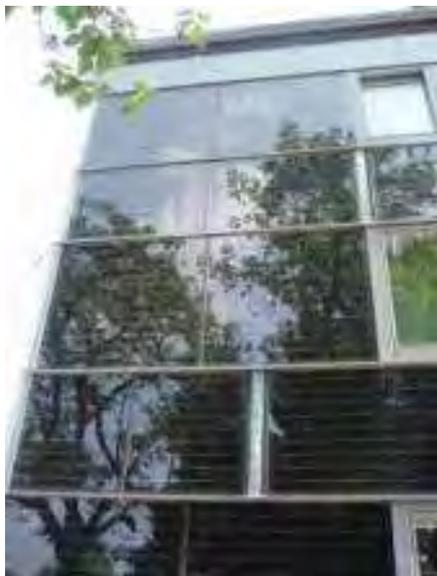
Abbildung 21: Solarthermische Fassadenkollektoren am Dieselweg in Graz (Quelle: AEE INTEC)
