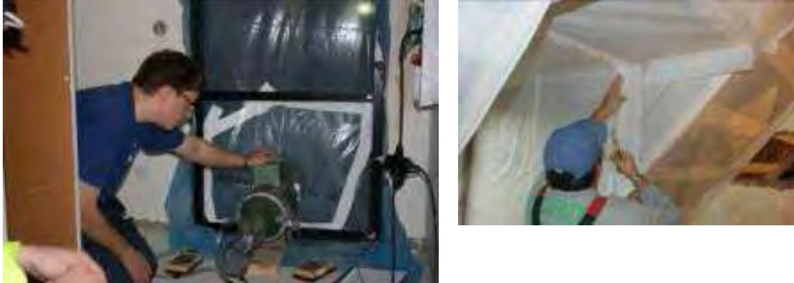
Abbildung 10: Blower Door Test im Pilot Projekt Brogården/Sweden (linkes Bild) und Herstellung der luftdichten Ebene im Dachboden am Dieselweg, Graz (Quellen: SP, AEE INTEC)
