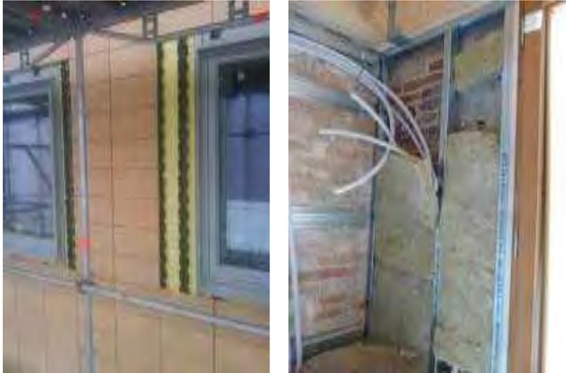
Abbildung 6: Dämmung und neue Fassade in Brogården/Schweden (linkes Bild) und Innendämmung wegen der Auflagen beim Dämmen einer historischen Fassade im Objekt San Juan de Malta/Spanien (Quellen: SP und TTA)
