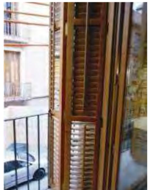
Abbildung 11: Zwei Beispiele von Außenjalousien; das linke Bild zeigt lichtführende Lamellen – der obere Teil lässt Tageslicht in den Raum (Quelle: AEE INTEC)
