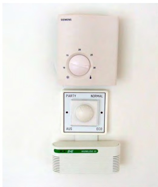
Abbildung 9 Temperatur- und Luftwechselregelung, Datenlogger (unten) zur Temperatur- und Feuchtemessung in einer Wohneinheit – PH Melone [AEE INTEC]
