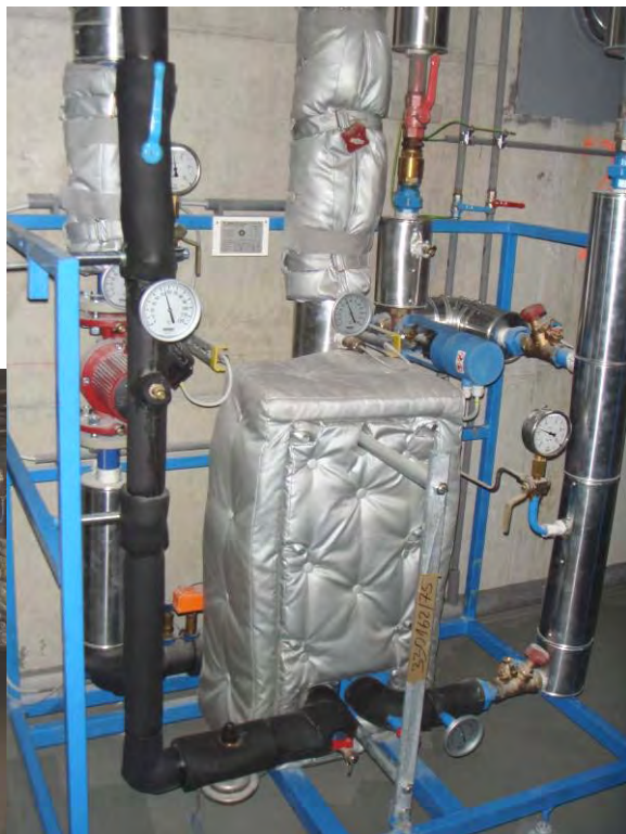
Fernwärmeübergabestation WW-Bereitung
