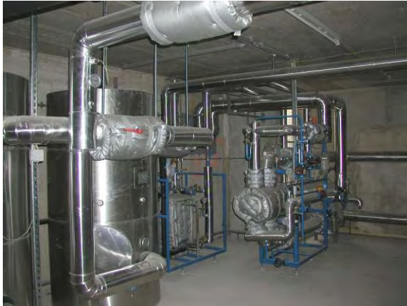
Fernwärmeübergabestation zentral mit WW-Speicher im Vordergrund
