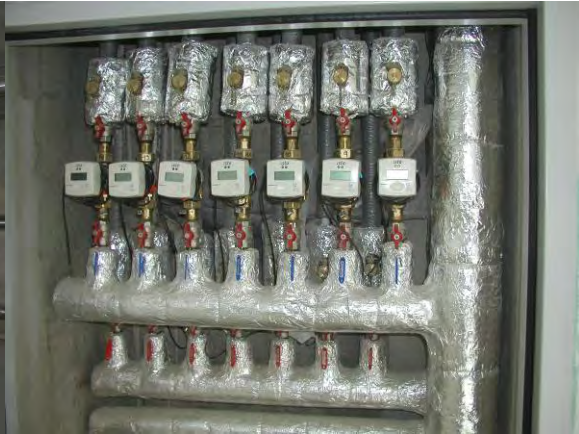
Steigschächte für Radiatorenversorgung
