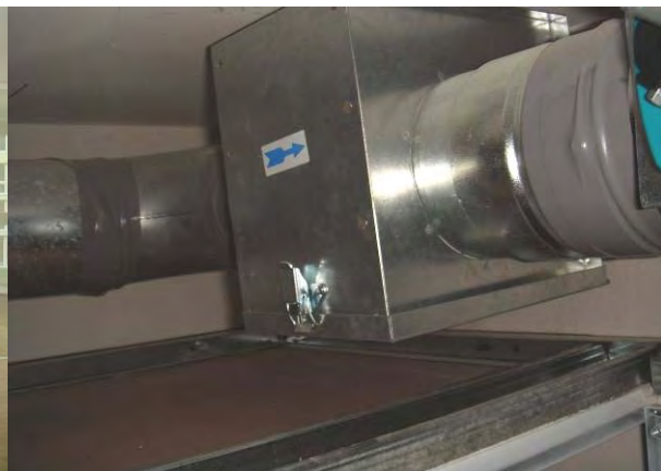
Zuluftfilter dezentral im Wohnbereich
