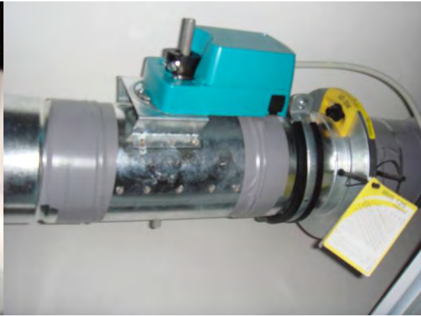
Volumsstromregelung der Zuluft Quelle: AEE INTEC
