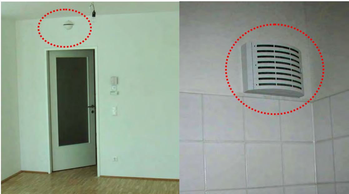
Abbildung 10 Zuluftöffnung im Wohnraum(links) und Abluftöffnung im Badezimmer (rechts) – PH Melone [AEE INTEC]
