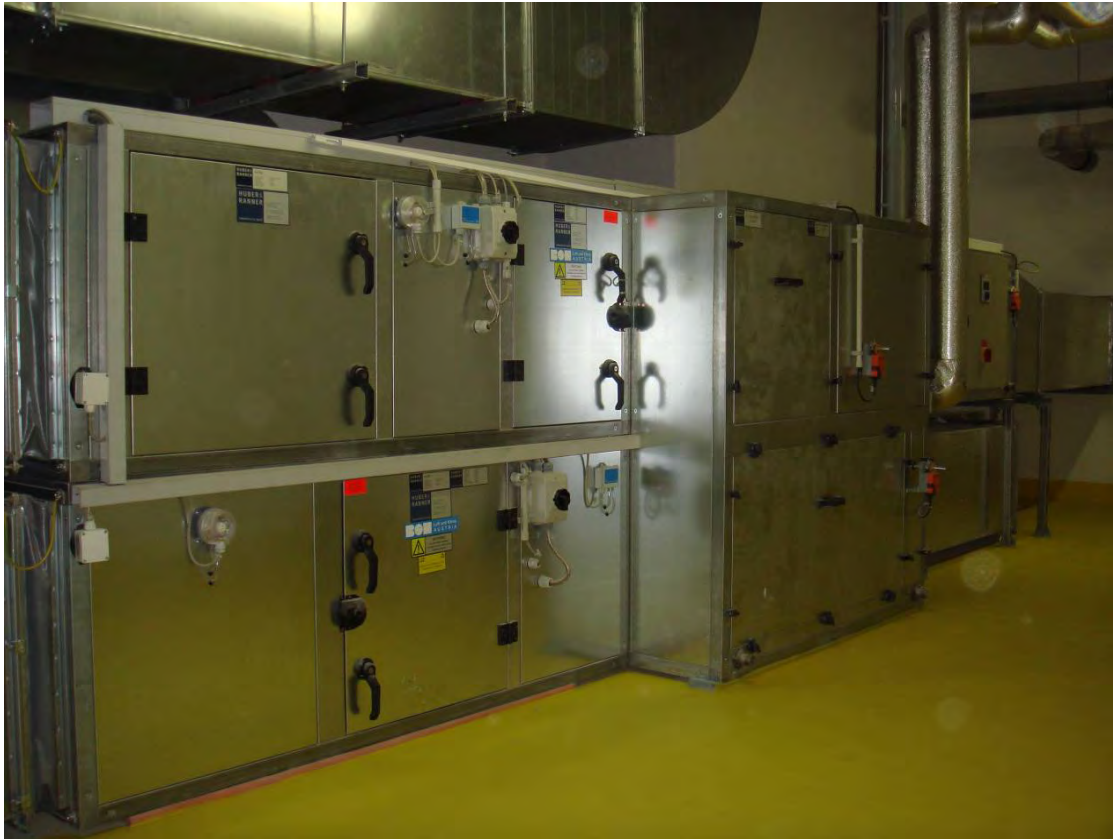
Abbildung 8 Lüftungszentrale im Keller des PH Melone [AEE INTEC]
