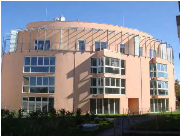
Außenansicht NEH Mango Quelle: AEE INTEC
