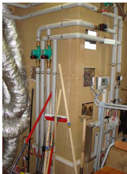
Pufferspeicher nach Einbau/Isolierung
