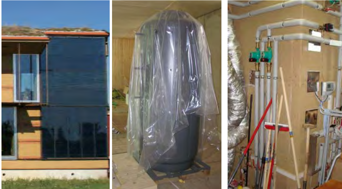
Abbildung 4: Links: thermischer Solarkollektor in Fassade; Mitte: 1500 Liter Solarspeicher vor Einbau; Rechts: Der fertig eingebaute, mit Flachs gedämmte und mit n&l Biofaser-Lehmverbundplatten verkleidete Speicher mit isolierten Leitungen [AEE Intec]
