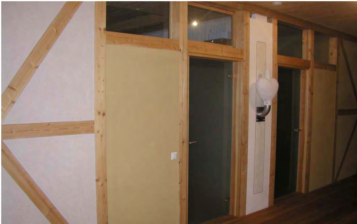
Innenraum- Zwischenwände und Methanolheizung
