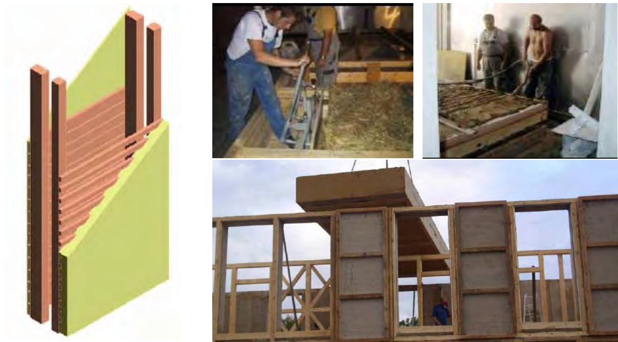
Abbildung 3: Fertigteil- Konstruktionsprinzip [natur &amp; lehm]
