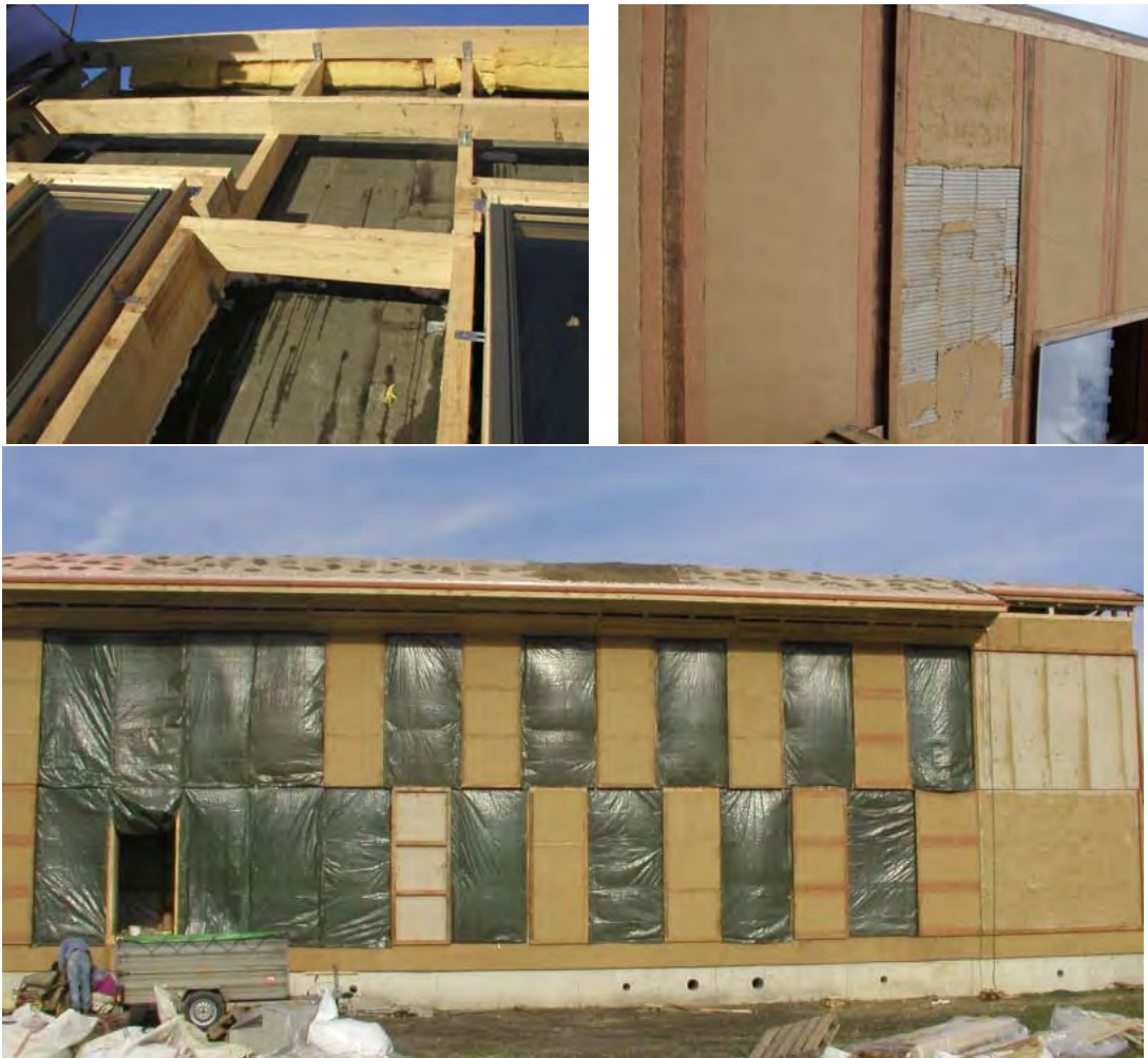
Holzriegelkonstruktion mit eingesetzten Lehmmodulen, Lehmverputz
