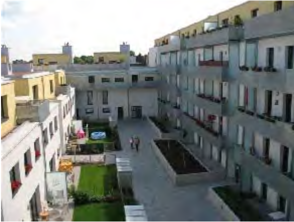
Innenhofansicht Quelle: :ah! 01.03.2007
