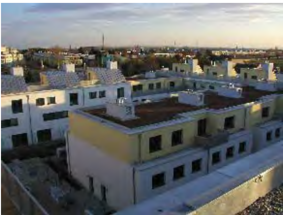
Dachansicht der fertigen Anlage Quelle: AEE- INTEC
