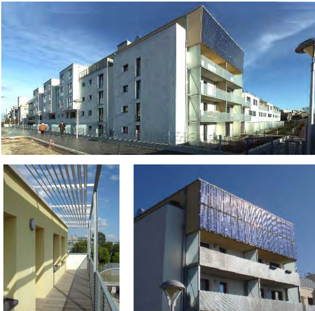
Abbildung 4: oben: Ansicht Südwest [Treberspurg & Partner Architekten] unten links : Verschattungselemente am südseitigen Balkon unten rechts: PV- Anlage an der Südfassade [AEE INTEC]
