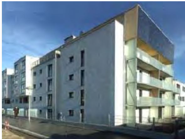
Straßenansicht Quelle: Treberspurg & Partner Architekten
