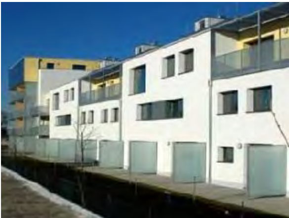
Südansicht Quelle: Treberspurg & Partner Architekten
