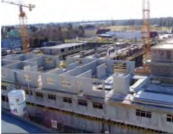
Rohbau vor Silvester 2005
