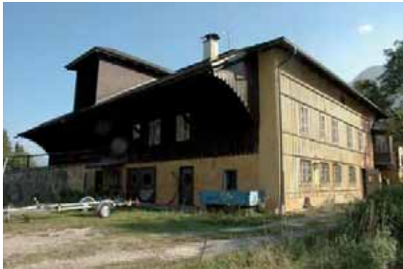
Nord- und Westansicht
