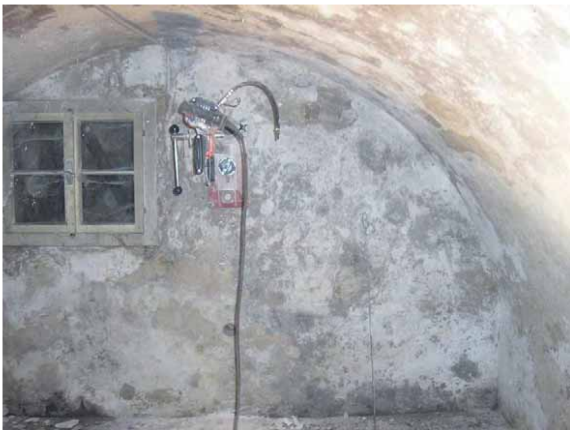
Abbildung 2-20: Foto 117: Bohrachse EG2, Heizkeller EG
