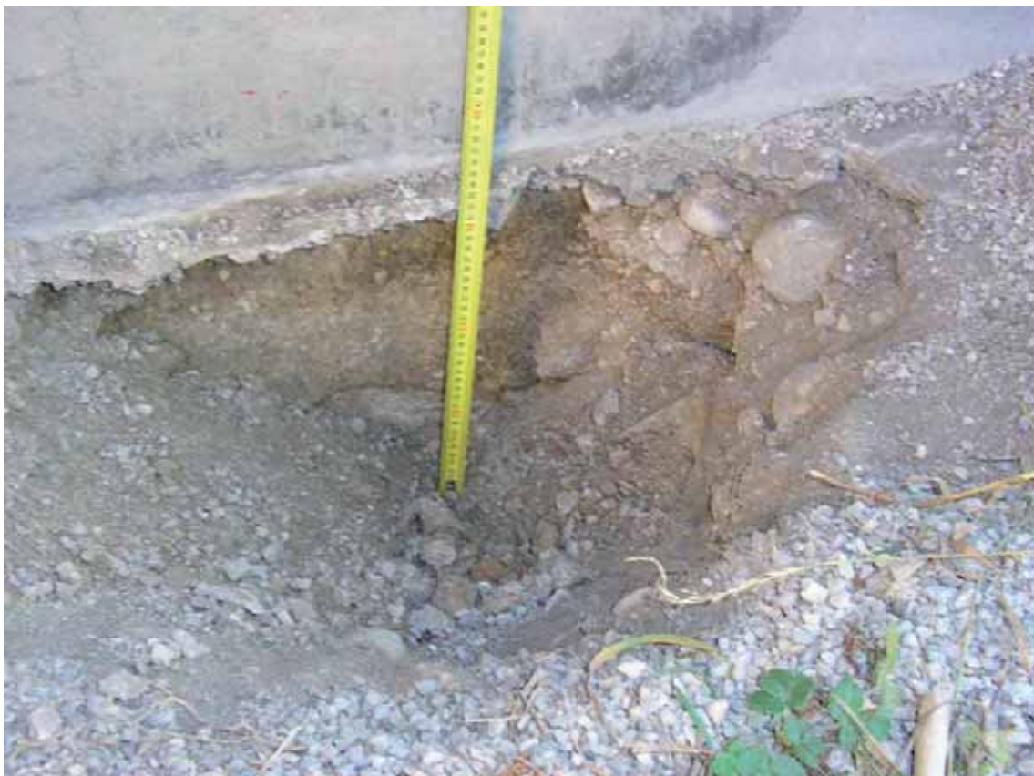
Abbildung 2-18: Foto 79: Außenfassade West
