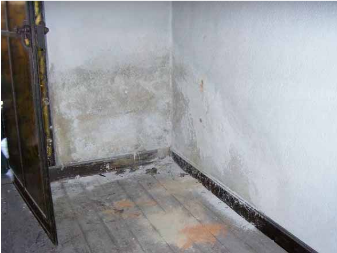
Abbildung 2-23: Foto 29: EG große Eingangshalle (3-dimensionale Feuchtigkeitsmessung)
