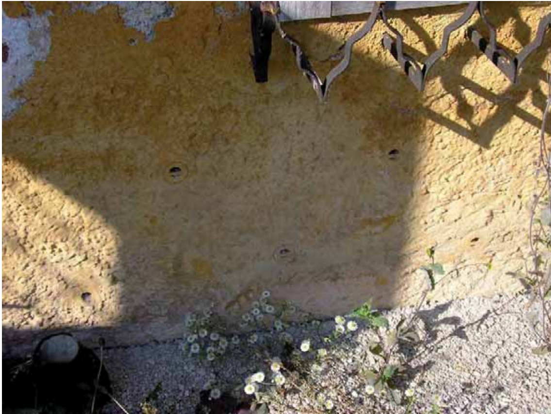
Abbildung 2-17: Foto 72: Außenfassade Ost
