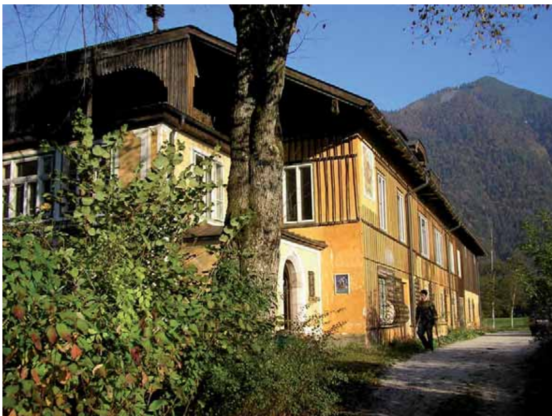
Abbildung 2-14: Foto 11: Außenansicht Ostseite
