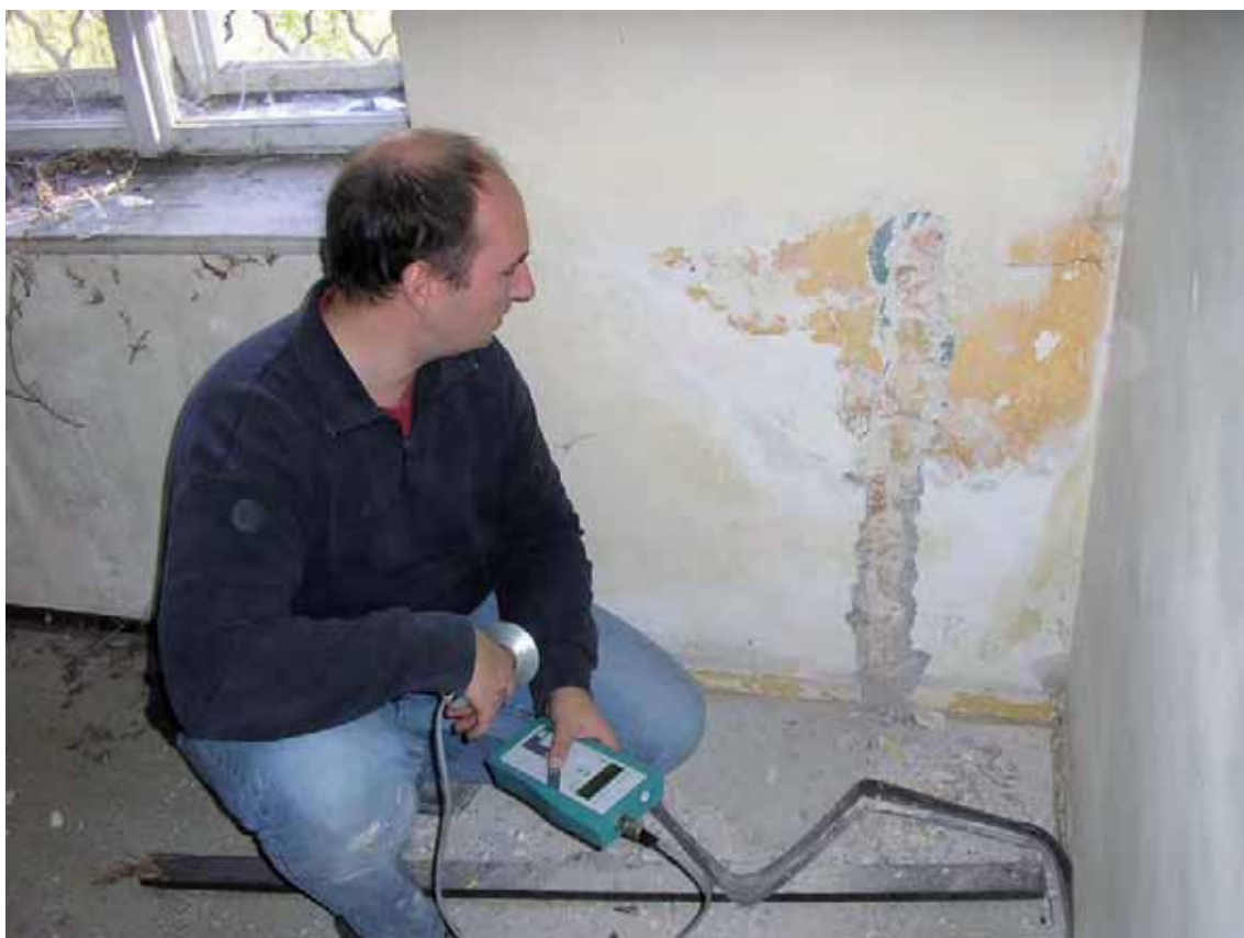
Abbildung 2-28: Foto 131: EG Raum vor Bad
