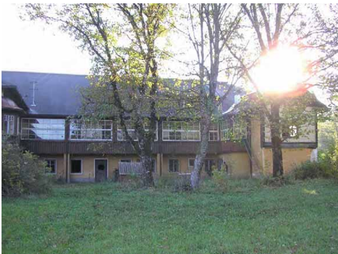
Abbildung 2-12: Foto 7: Außenansicht Westseite
