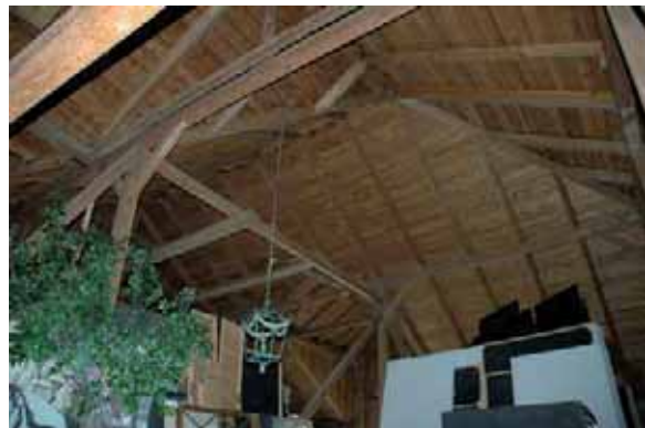
Dachstuhlkonstruktion – Richtung Scheunentor
