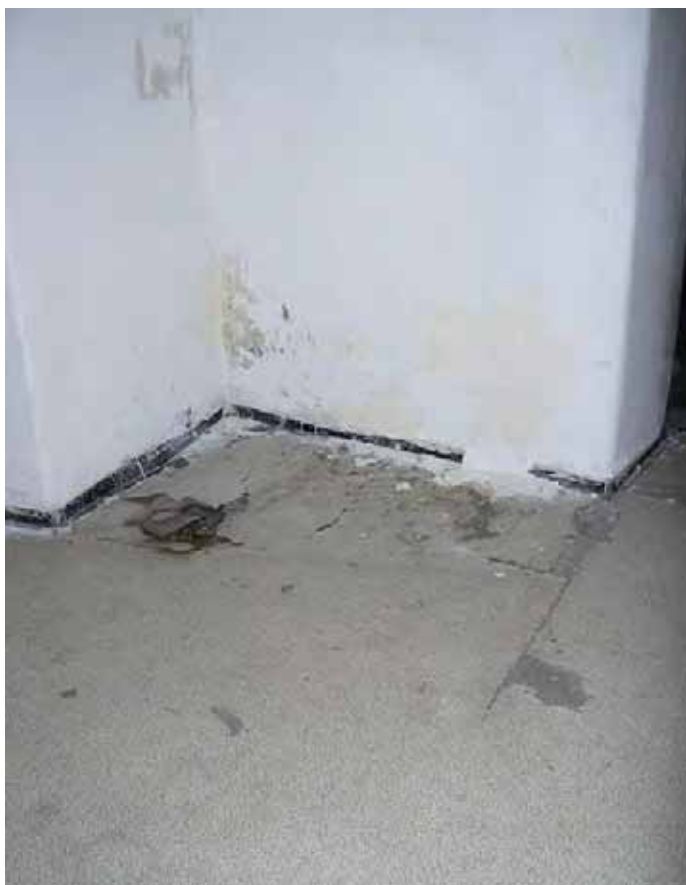
Abbildung 2-25: Foto 48: EG Gang, Loch im morschen Holzboden
