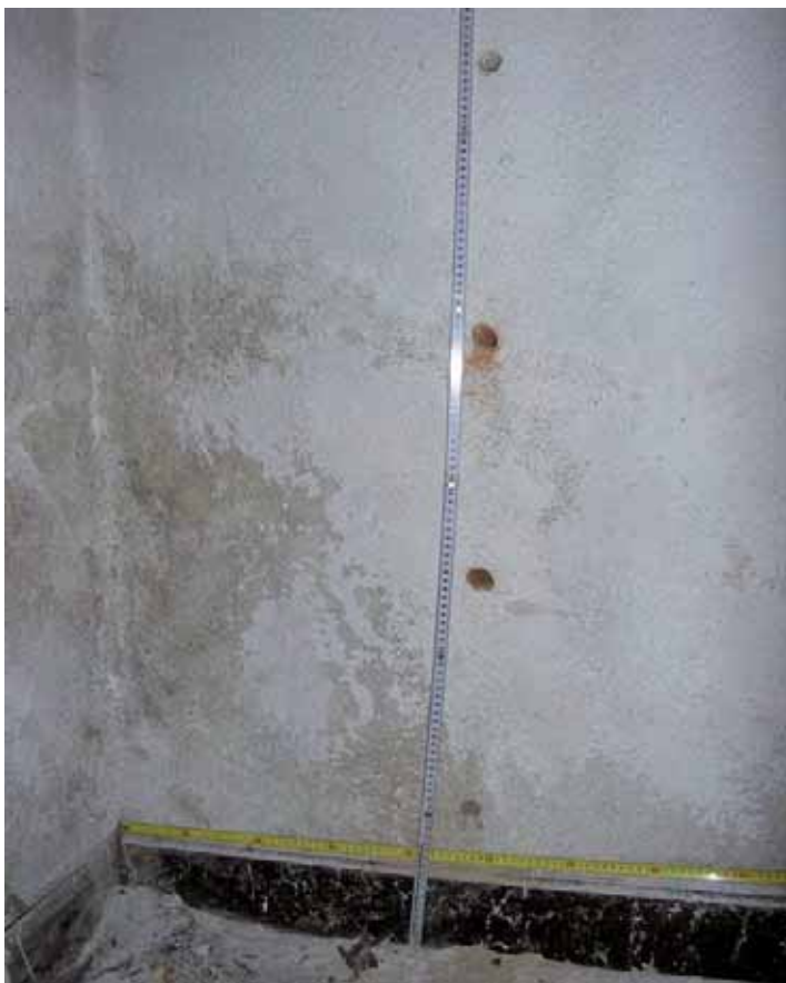
Abbildung 2-22: Foto 16: Bohrachse LD1, große Eingangshalle (EG)
