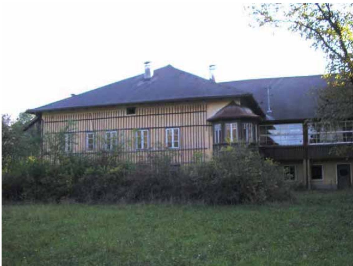
Abbildung 2-11: Foto 8: Außenansicht Westseite
