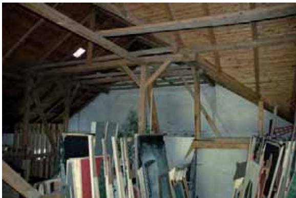
Dachstuhlkonstruktion – Scheune Richtung Wohntrakt
