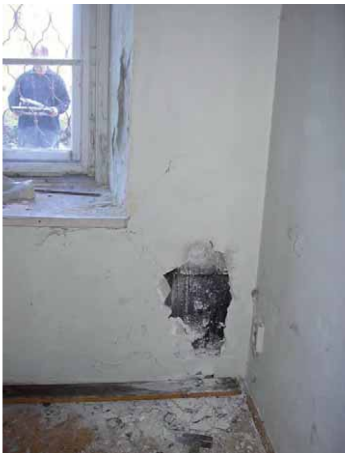
Abbildung 2-29: Foto 134: Bohrloch EG3, Zimmer EG (raumseitige Bitumenabdichtung)
