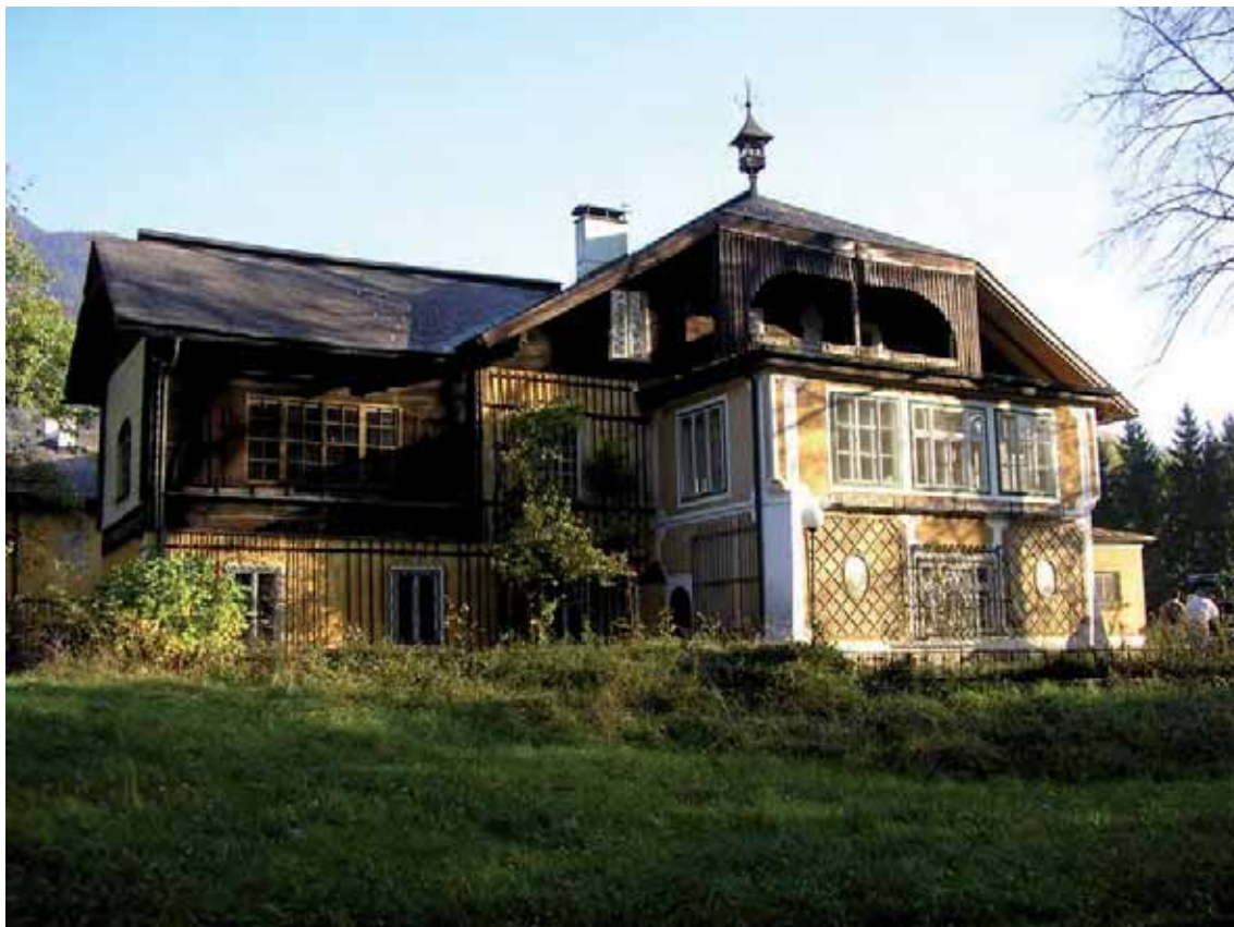
Abbildung 2-13: Foto 10: Außenansicht Südseite
