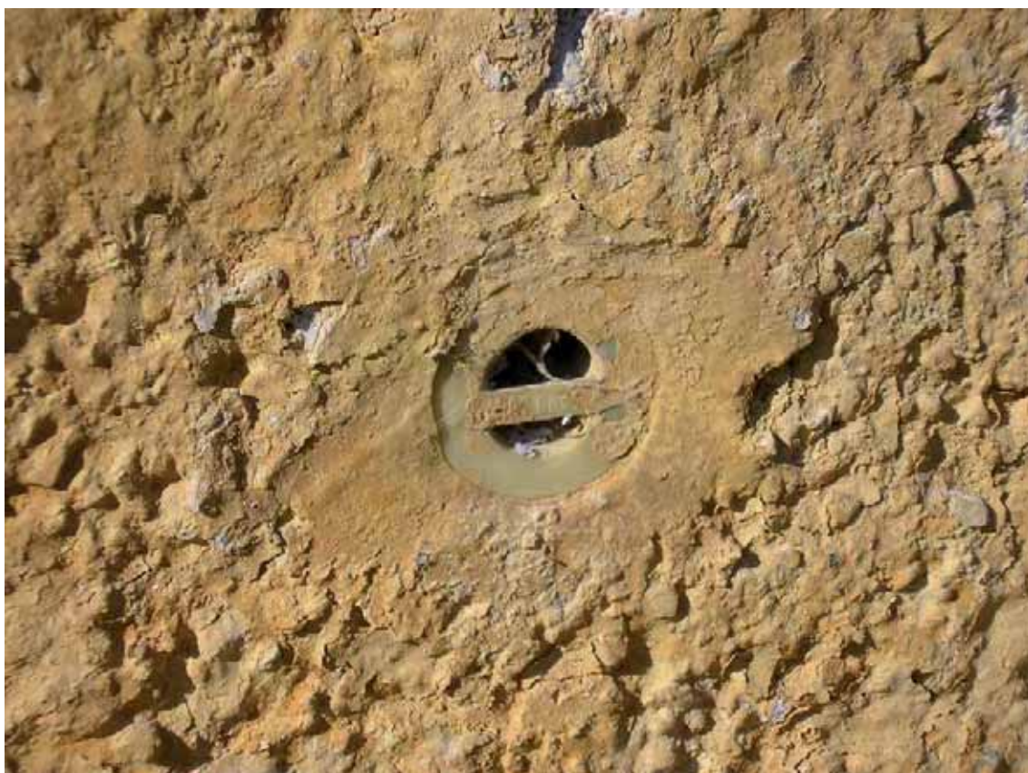
Abbildung 2-16: Foto 71: Außenfassade Ost
