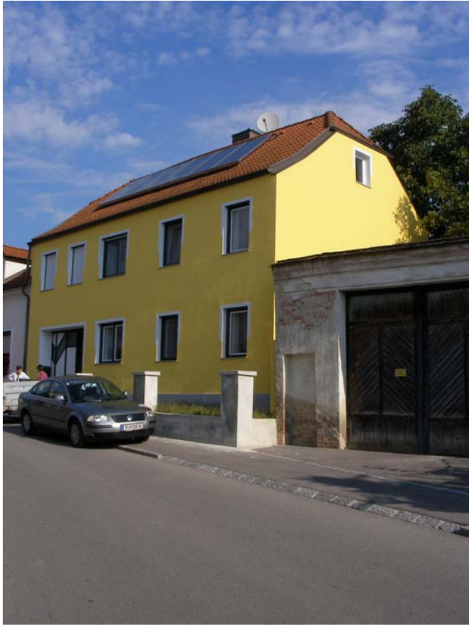
Abbildung 18: Stephanek nach Sanierung
