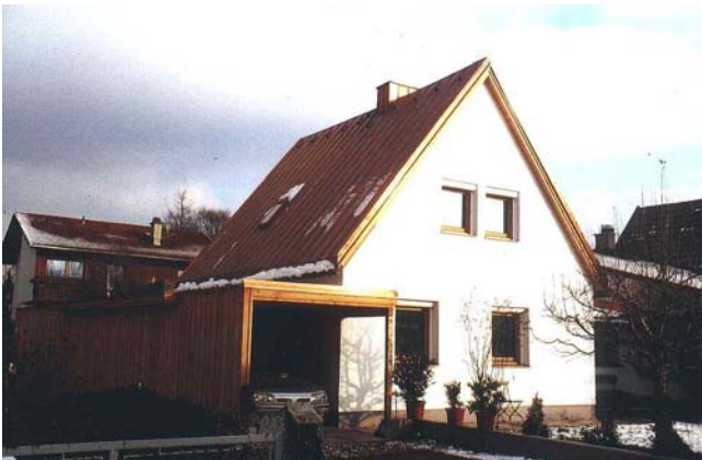
Abbildung 10: Wehinger Sanierung NW
