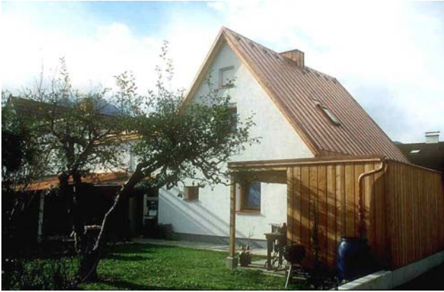
Abbildung 9: Wehinger Sanierung Ansicht NO
