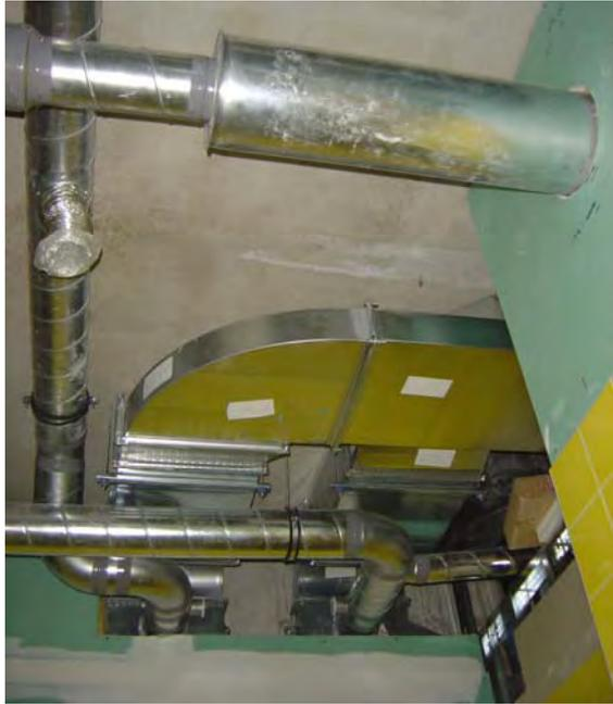
Die WC-Anlagen werden in beiden Baurakten über je ein separates, jeweils im 2.OG montiertes, Lüftungsgerät be- und entlüftet.
