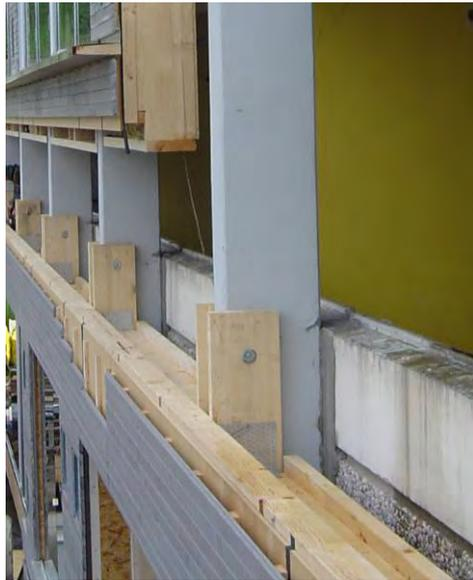
Die im Vergleich zu Vorprojekt/Entwurf erfolgte Überdämmung der Stahlbetonstützen Bestand mit 15 cm Wärmedämmung statt 2 – 5 cm Spezialdämmung wurde in den o.a. Berechnungen bereits berücksichtigt.
