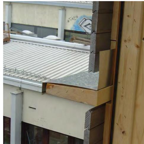
Die Zellulosedämmung wurde in B1-Qualität ausgeführt; sowohl Thermobuchenfassade und verputzte Fassade haben mind. B1-Qualität. Der Sturz- und Parapetbereich wurde mittels doppelter Gipskarton Feuerschutzplatten-Beplankung, Materialstärke 15 mm, ausgeführt, wobei beide Plattenlagen gespachtelt wurden. Die Klebebänder zur Erreichung der Dampfdichtigkeit zwischen Fensterstock und Betonbrüstung bzw. -sturz durften lt. Absprache mit der BVS Linz mit bitumenhaltigen Klebebändern ausgeführt werden.
