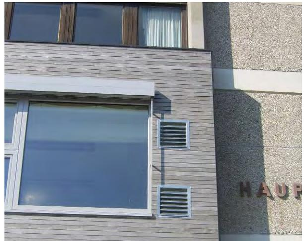
Die  $90^{\circ}$  abgewinkelte Luftkanalführung verursachte Strömungsgeräusche, die durch Schrägführung minimiert werden konnten. Die Kondensatleitungen konnten ins Gerät verlegt werden. Der Versuch, die Jalousien nicht bis hinunter zu führen, konnte wegen Überhitzung nicht umgesetzt werden.
