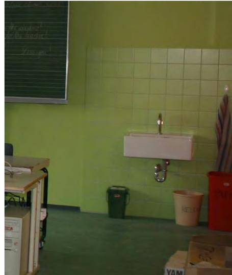
Sämtliche Waschtische in den Klassenzimmern und Sanitärräumen erhielten keinen Warmwasseranschluss.
