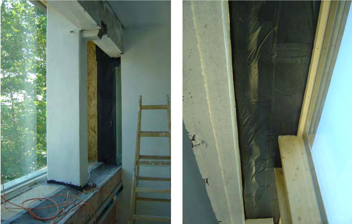
Ausführung der Luftdichtanschlüsse zwischen altem Stahlbetonfassadenbestand und vorgehängter Holzriegelkonstruktion im Parapet-, Säulen und Unterzugsbereich
