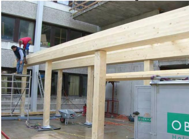
Sowohl die Holzstützen, die Deckenträger und die flächen geliefert und montiert.
