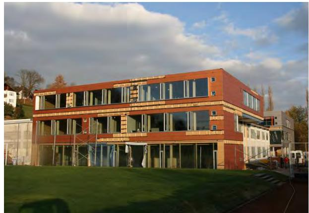
Bild 1: Polytechnische Schule nach Teilabbruchphase, Bild 2 und 3: Neun Tage nach Montagebeginn der Fertigteile stand der Zubau und der Innenausbau begann
