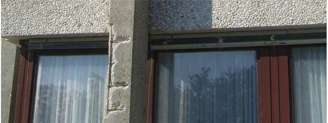
Die vor der Fassade angeordneten ungeschützten Stahlbetonstützen zeigten schon erhebliche Korrosionsschäden auf, und mussten zunächst saniert werden.
