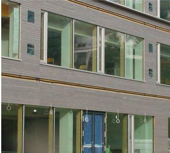
Seitens der Haustechnik bestand bei der dezentralen Lüftung das Erfordernis in jeder Klasse eine Zu- und Abluftöffnung auszuführen. Entgegen den ersten Entwürfen wurden keine aufwendigen Durchbrüche in den bestehenden Stahlbetonelementen ausgebildet, sondern die Lüftungskanäle leicht nach unten verzogen und durch die vorgefertigten Holzriegelelemente geführt. Die Kanaldurchdringungen konnten so ebenfalls schon in der Montagehalle vorinstalliert werden.
