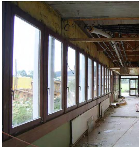
Während im Bestand die Stützen vor der Fassade und den Fenstern waren, wurde mit der Sanierung die gesamte statische Konstruktion in die thermische Hülle „eingepackt“.
