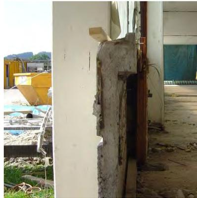
Der Sturzbereich ist zur Verbesserung der Tageslichtsituation gegenüber dem bestehenden Sturz der Stahlbetonelemente höher gelegt worden, indem die Betonschürzen vor den alten Jalousien durchgehend abgeschnitten wurden.
