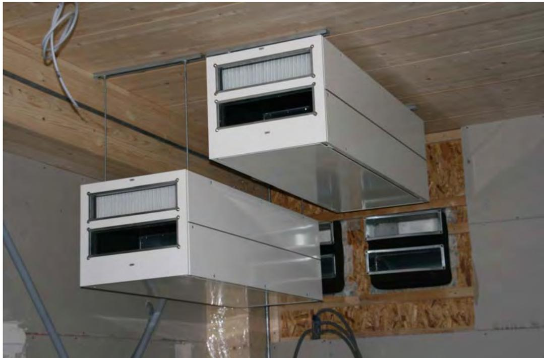
Abb. 58: Be- und Entlüftungsausführung in der Werkstätte mit höherem Luftbedarf
