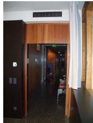
Abbildung 147: Zuluftgitter
