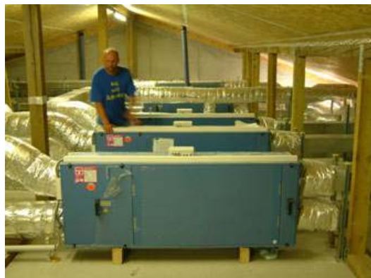
Abbildung 84: Lüftungsgeräte
