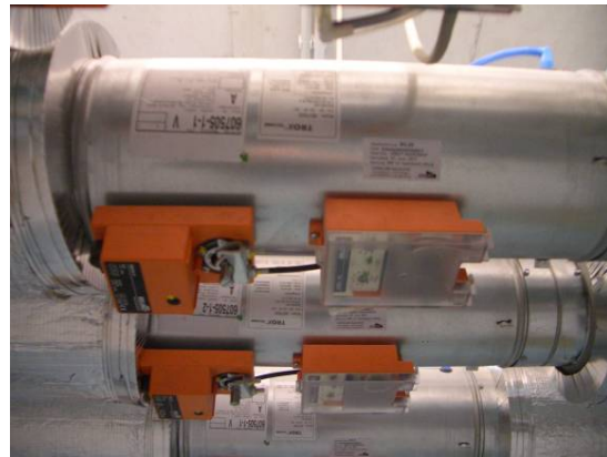
Abbildung 155: Elektrische Stellklappen
