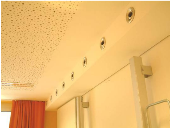
Abbildung 9.23: Düsensabstände etwas zu gering – Abhilfe „Auffächerung“ der Strahlen
