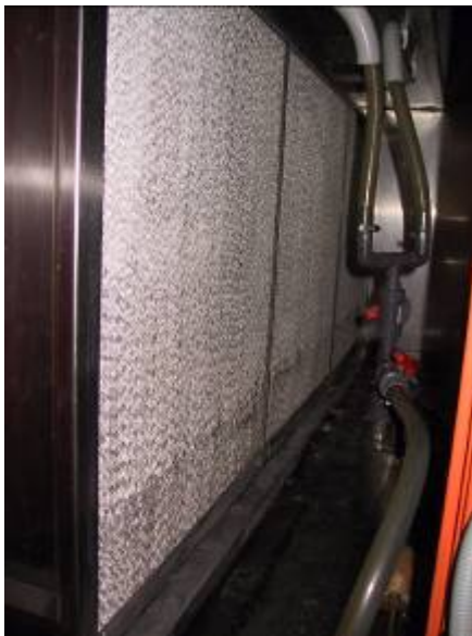
Abbildung 9.53: Bild des sehr gut gewarteten Kontaktbefeuchters
