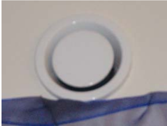
Abbildung 26: Abluftventil Klassenraum
