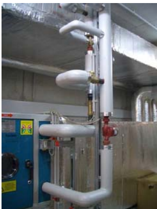
Abbildung 158: Nacherwärmung
