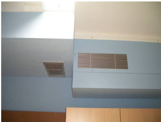
Abbildung 9.8: Luftführung Zu- und Abluft
