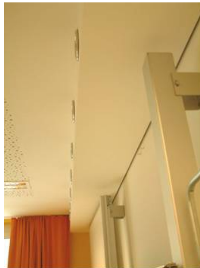
Abbildung 108: Absaugung (Schattenfuge)
