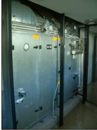
Abbildung 112: Lüftungsgerät
