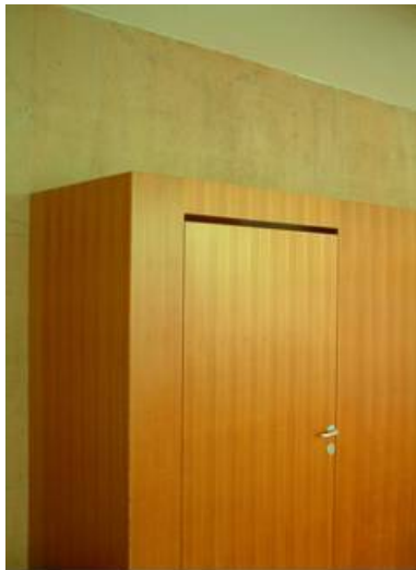
Abbildung 165: Überströmquerschnitt
