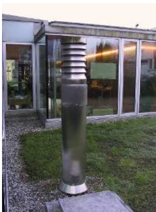
Abbildung 9.27: Ansaugung einer dezentralen Anlage
