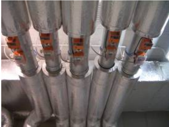
Abbildung 9.49 a und b: Automatische Luftmengenregelung über Mischgasfühler
