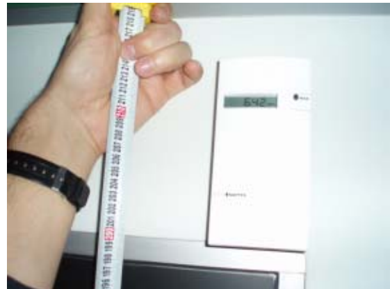
Abbildung 58: CO 2 Fühler
