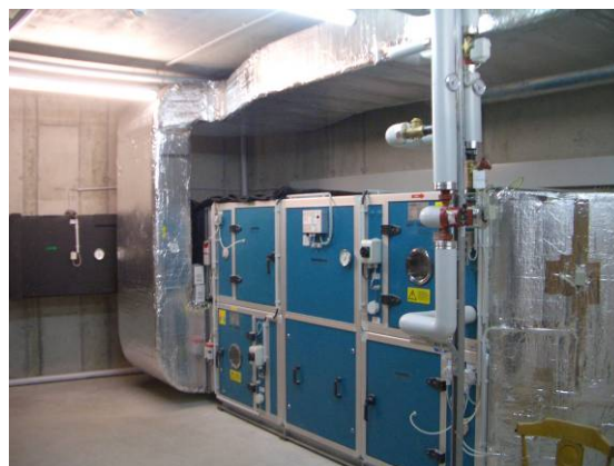
Abbildung 143: Lüftungsgerät
