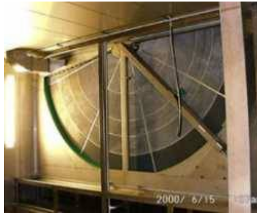
Abbildung 6.25: Rotor mit Sorption – Symbol und Bild
