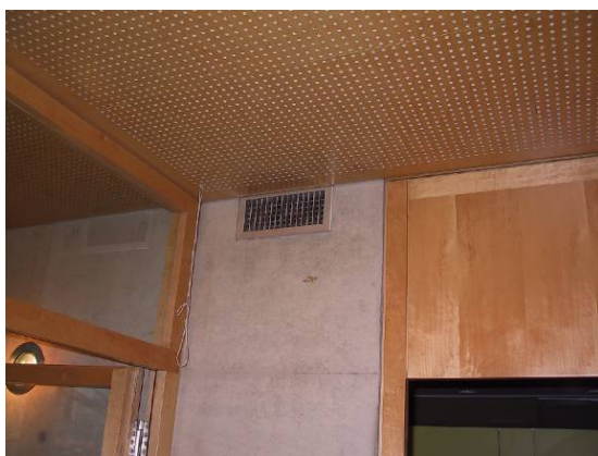
Abbildung 42: Abluftgitter
