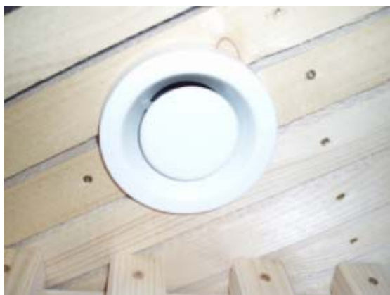
Abbildung 11: Abluftventil Klassenraum
