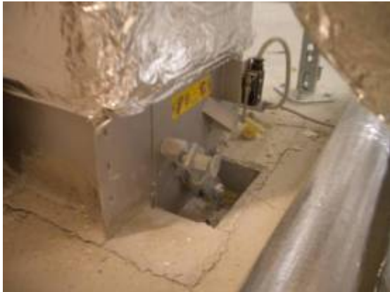
Abbildung 9.58: Brandschutzklappe mit Kontaktschalter für GLT
