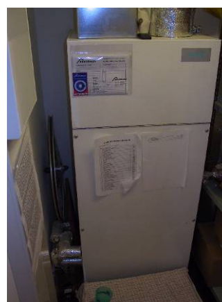
Abbildung 35: Lüftungsgerät
