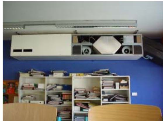
Abbildung 133: Lüftungsgerät
