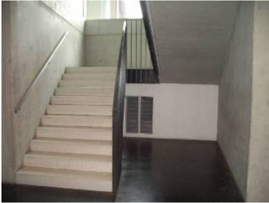
Abbildung 9.56: Ablufführung aus dem zentralen Stiegenhaus spart eine aufwändige Luftleitungsführung für die Abluft
