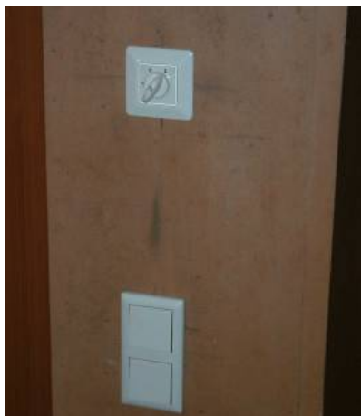
Abbildung 9.51: 3-Stufenschalter ohne Abschaltmöglichkeit durch den Nutzer bei dezentraler Anlage
