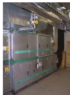
Abbildung 121: Lüftungsgerät
