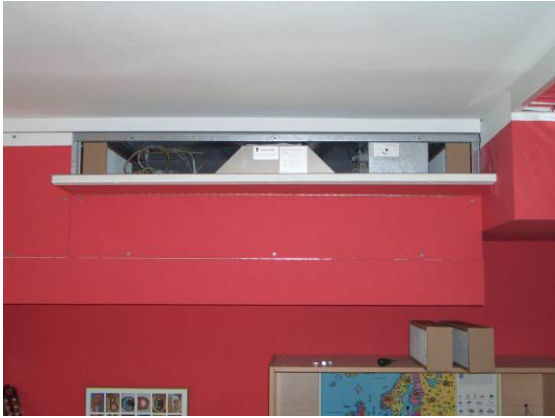
Abbildung 63: Wärmetauscher
