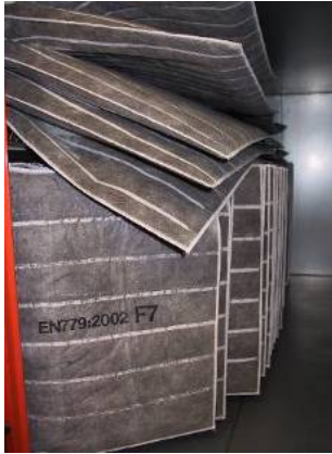
Abbildung 9.40: Stehende (jeweils unten) und liegende Taschenfilter (jeweils oben)
