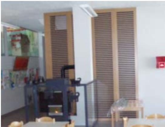
Abbildung 50: Quellluftauslass
