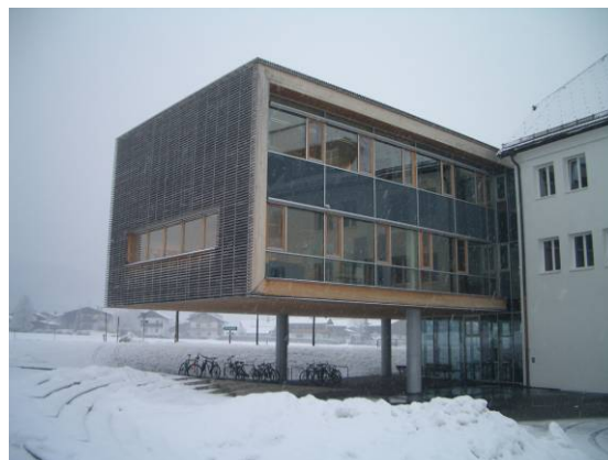
Abbildung 141: Neuer Zubau + Altbau
