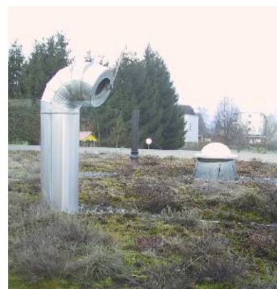
Abbildung 9.39: Fortluftführung über Dach
