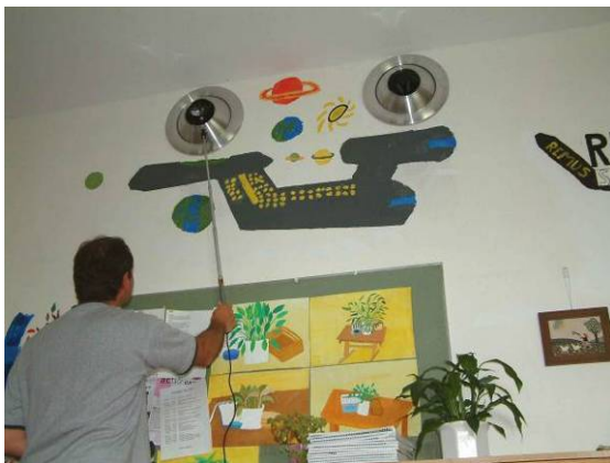
Abbildung 9.24: Überdimensionierung der Kugeldüsen (DM 150, Austrittsgeschw. 3,5 und 3,9 m/s)
