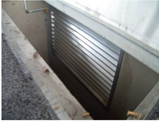
Abbildung 152: Fortluftführung
