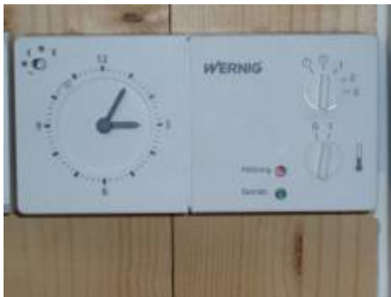
Abbildung 9.47 a und b: Steuerungsgeräte für dezentrale Lüftungsgeräte
