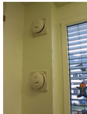
Abbildung 79: Zuluft/Abluftgitter
