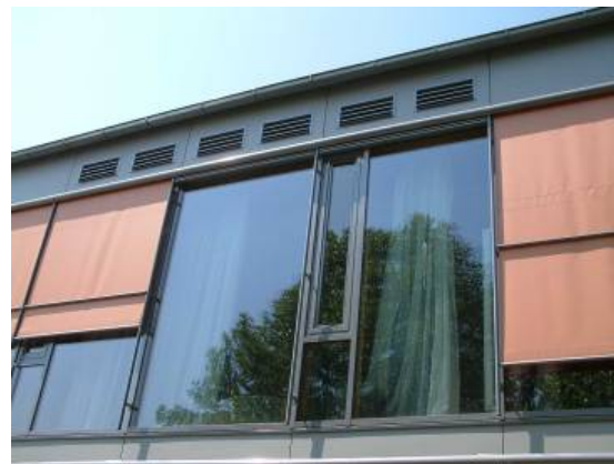
Abbildung 9.28: Ansaugung über Gitter in der Drempe/wand des Spitzbodens
