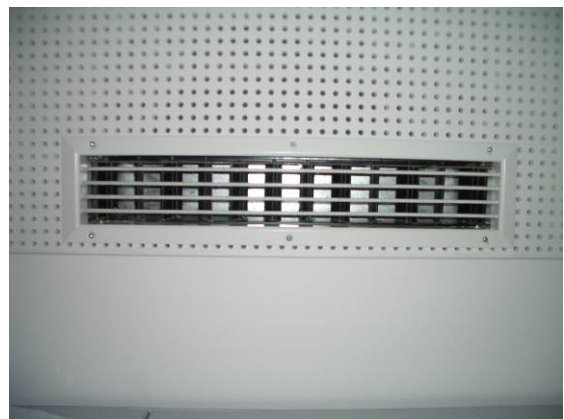
Abbildung 176: Zuluftgitter
