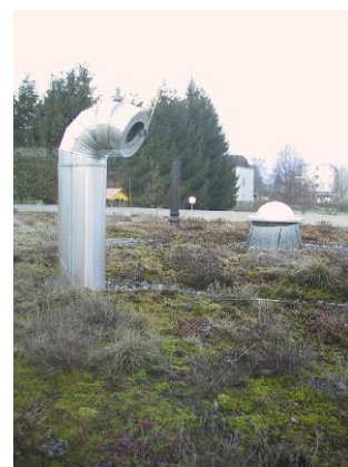
Abbildung 43: Fortluftführung
