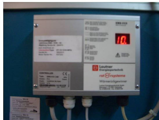
Abbildung 159: Drehzahlregelung für Rotor
