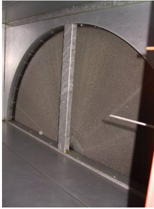
Abbildung 95: Wärmetauscher
