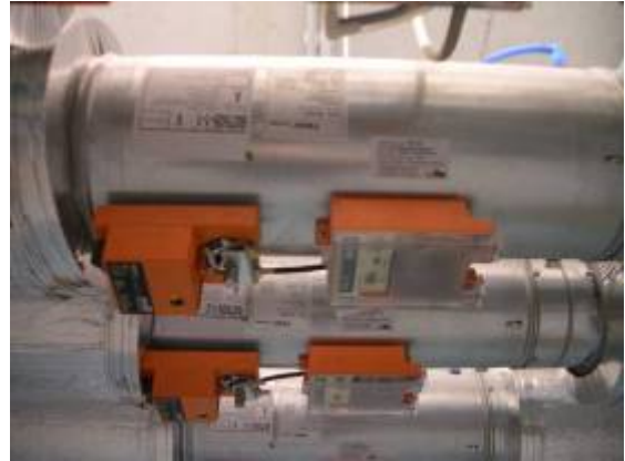
Abbildung 9.49 a und b: Automatische Luftmengenregelung über Mischgasfühler
