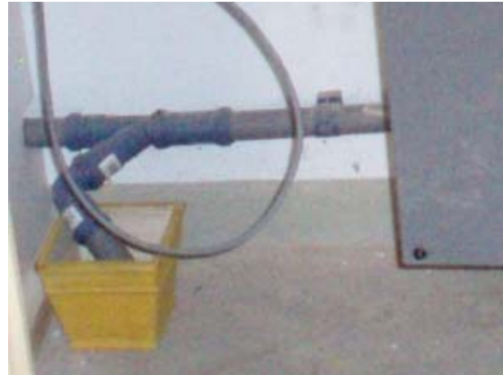
Abbildung 27: Kondensatabfluss
