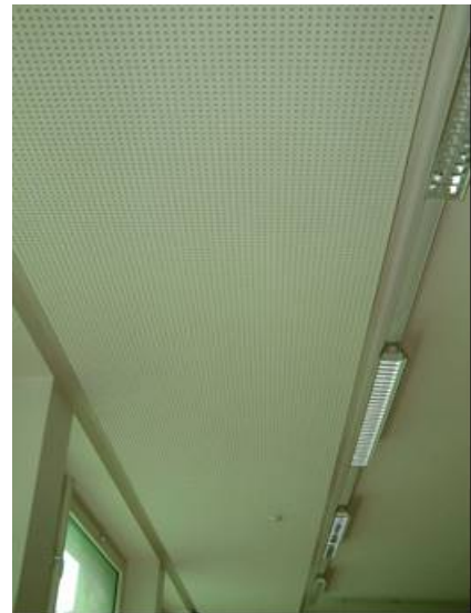
Abbildung 168: Zuluft (Lochpaneel)
