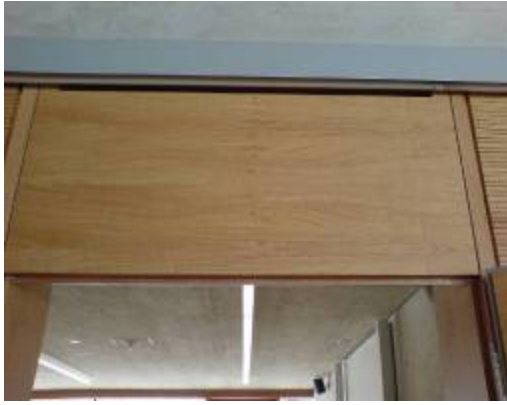
Abbildung 9.59 a und b: Zu gering bzw. sehr knapp bemessene Überströmbereiche
