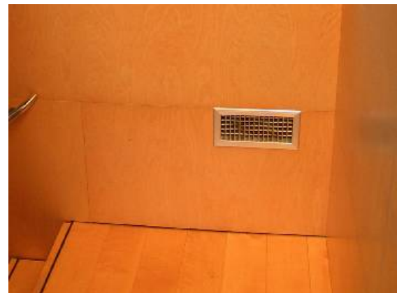
Abbildung 39: Zuluftgitter
