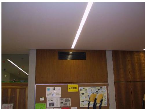
Abbildung 101: Abluftgitter
