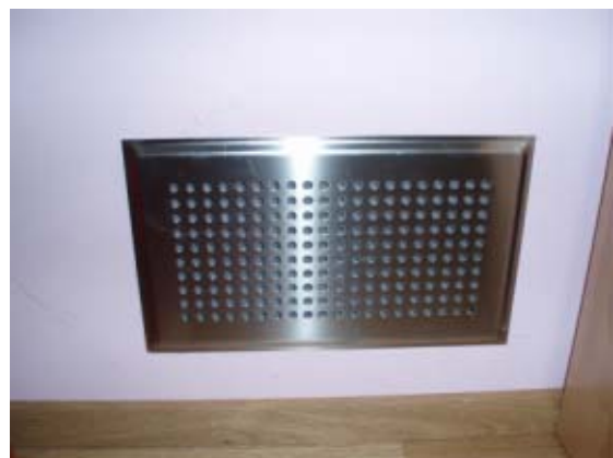
Abbildung 8: Zuluftgitter
