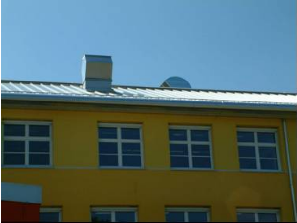
Abbildung 103: Luftansaugung und -ausblasung
