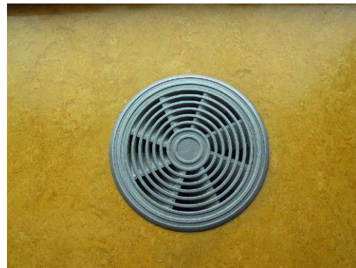
Abbildung 98: Zuluftgitter
