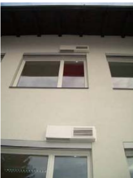
Abbildung 69: Fortluftführung
