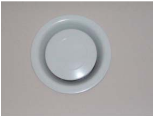
Abbildung 54: Abluftventil
