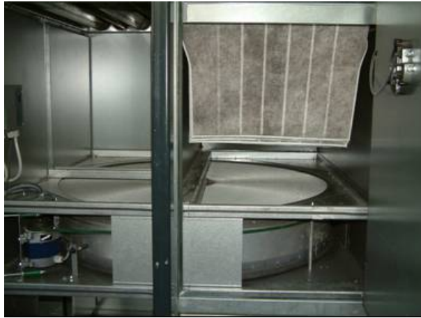
Abbildung 113: Rotationswärmetauscher
