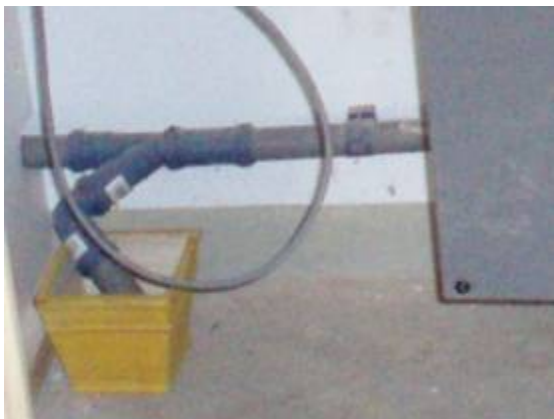
Abbildung 9.46: Provisorische Lösung für das Kondensat (mit Leckströmung)
