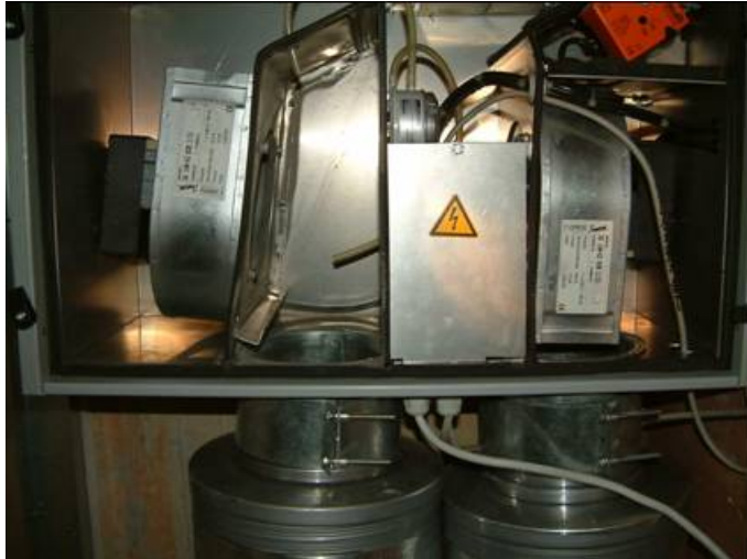
Abbildung 163: Innenansicht Lüftungsgerät
