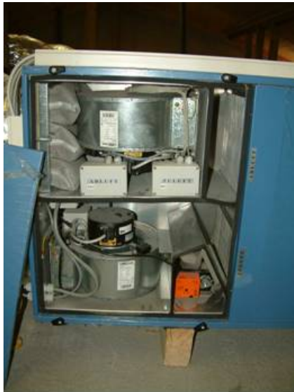
Abbildung 85: Innenansicht Lüftungsgerät
