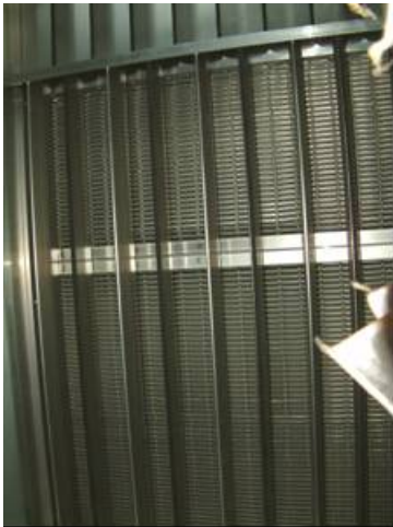
Abbildung 105: Platten-WT mit Bypass
