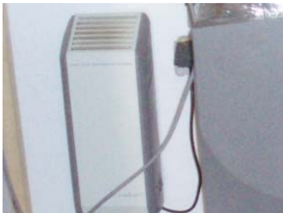
Abbildung 30: Heizgerät neben Lüftungsanlage
