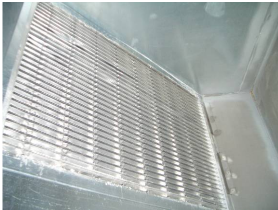
Abbildung 173: Wärmetauscher
