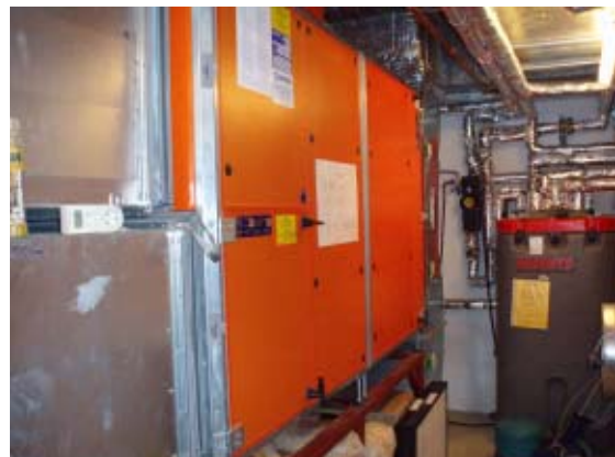
Abbildung 47: Lüftungsgerät
