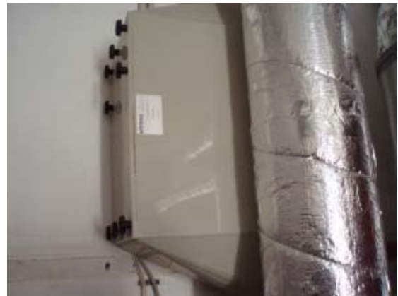
Abbildung 21: Feinstaubfilter
