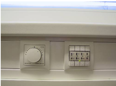
Abbildung 78: Raumsteuerung Lüftung
