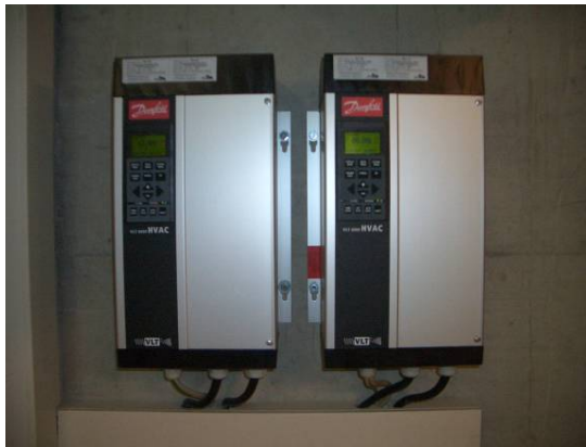
Abbildung 154: Drehzahlregelung
