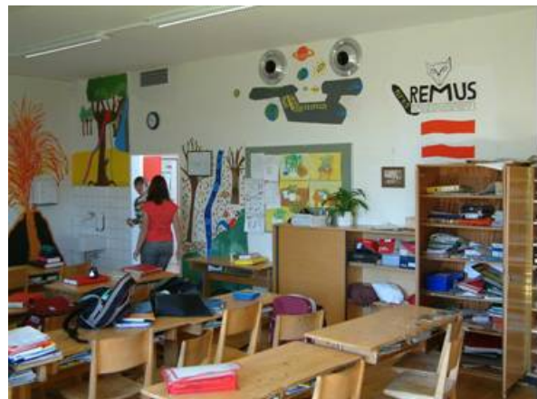
Abbildung 117: Abluftgitter über Tür
