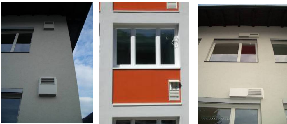
Abbildung 9.35 a–c: Speziell ausgeführte Außenluftansaugung/Fortluftauslass
