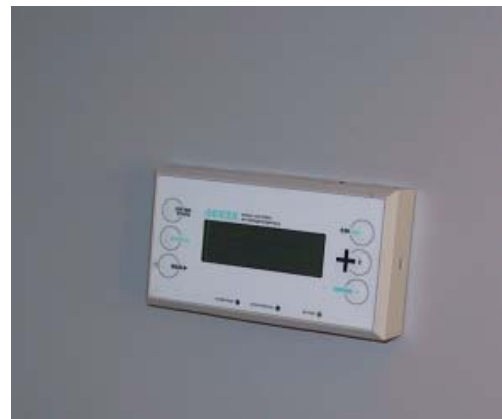
Abbildung 9.47 a und b: Steuerungsgeräte für dezentrale Lüftungsgeräte
