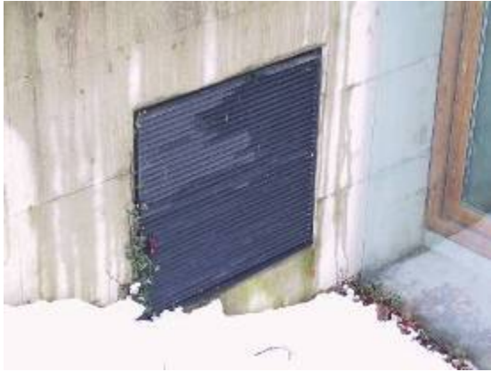
Abbildung 9.36: Außenluftansaugung mit freiem Querschnitt nur in der Größenordnung des Kanalquerschnittes
