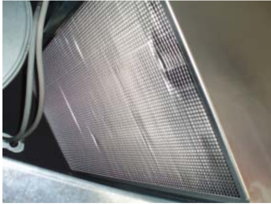
Abbildung 134: Wärmetauscher
