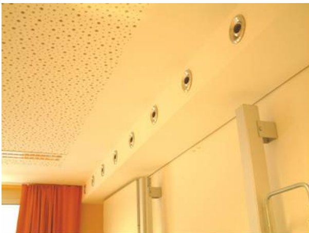
Abbildung 107: Lufteinbringung
