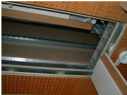
Abbildung 161: Einbausituation Lüftungsgerät
