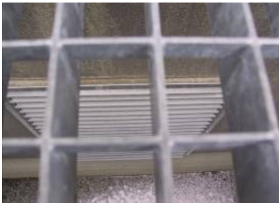
Abbildung 9.31 a und b: Ansaugsituation durch Kellerschacht: li Blick in den Schacht, re. Außenansicht: Gefahr der Ansaugung von bodennahen Gasen (z.B. Radon). Schneefreiheit durch Fassaden- nähe und Schachtgitter gegeben
