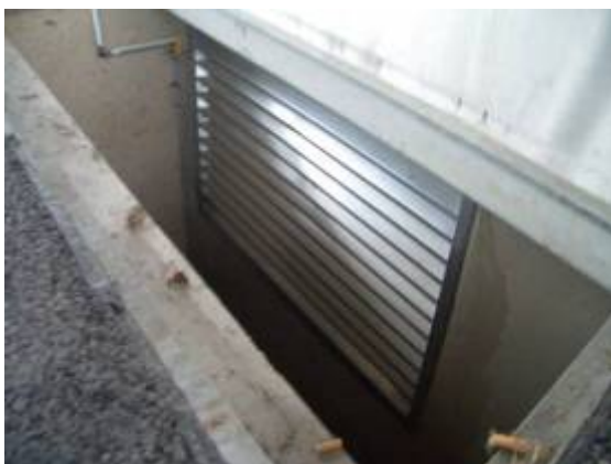
Abbildung 9.38: Fortluft über einen Kellerschacht
