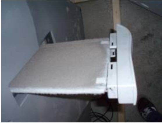
Abbildung 9.43: Einfache Filtermatte (G4) einer dezentralen Anlage
