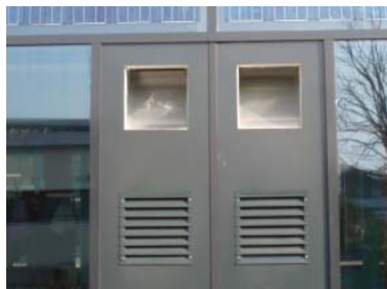
Abbildung 139: Fortluftführung
