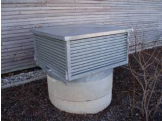
Abbildung 9.29: Zu geringe Ansaughöhe
