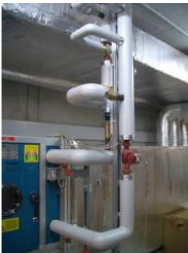
Abbildung 9.52: Nacherwärmung über ein wassergeführtes System
