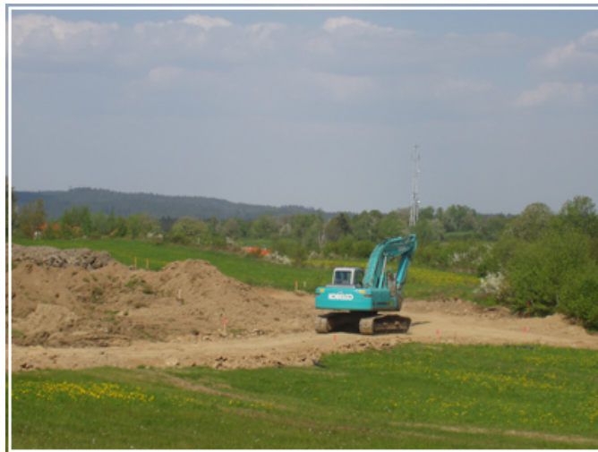
Abbildung 7 – Errichtung der Rohtrassen des Straßennetzes
