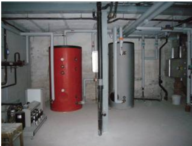
Bild: Pufferspeicher
