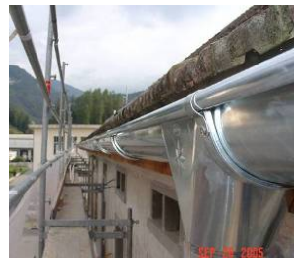
Bild: Vordach, Spenglerarbeit, Hohlkehlenanierung
