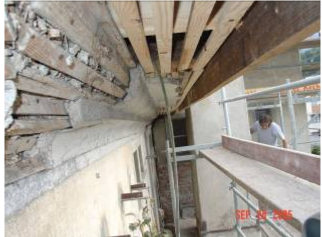
Bild: Dachsanierung Vordach/Hohlkelle
