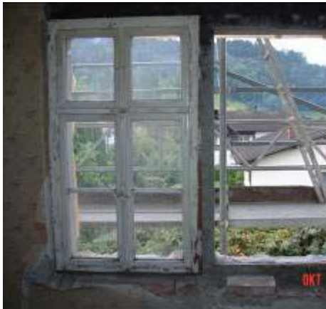
Bild: vor Sanierungsstart, Ansicht innen
