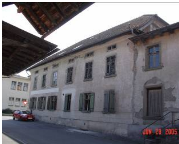
Bild: vor Sanierungsstart
