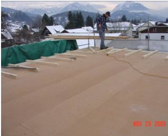
Bild: Dachsanierung Rosensaal
