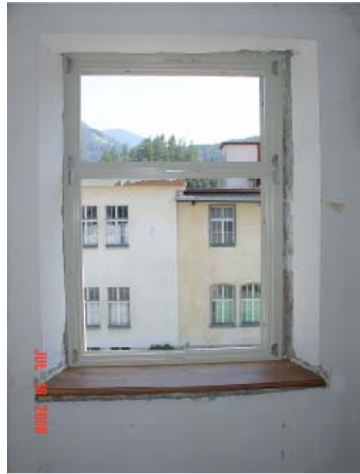
Bild: Fenstereinbau mit Stopfwole
