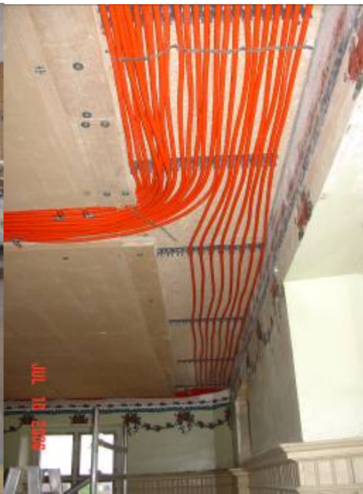
Bild: Deckenheizung
