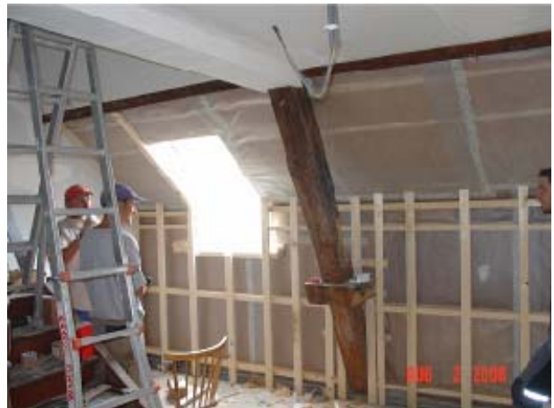
Bild: Holzfaserdämmung im Trockenbau bei Wänden
