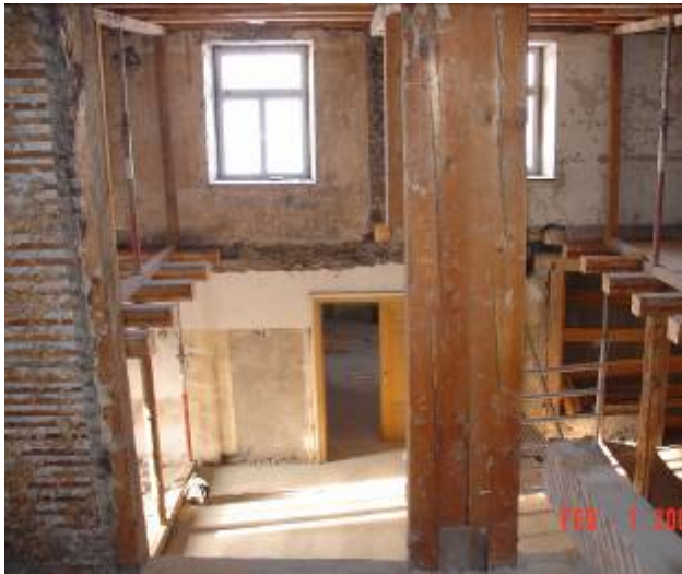
Bild: statisch notwendige Verbesserungen der intakten Deckenbalken
