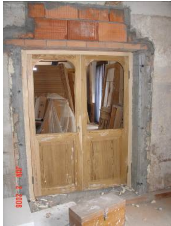
Bild: alte Türen wurden renoviert, neue Öffnungen angepasst - das ist hoch ökologisch
