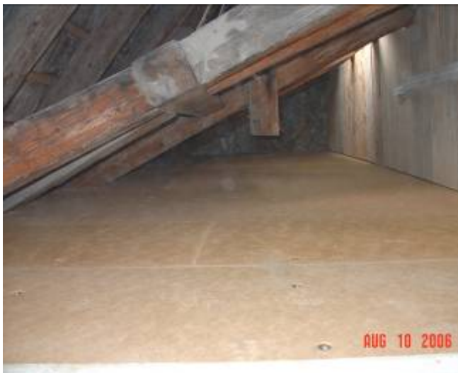
Bild: Dämmung in unbeheiztem Dachraum
