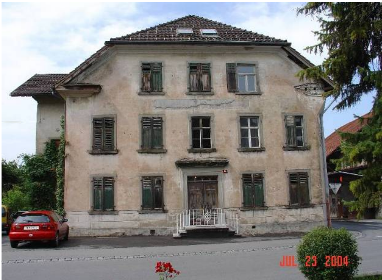
Bild: Freihof Sulz vor Sanierungsstart, Gebäude erbaut 1796
