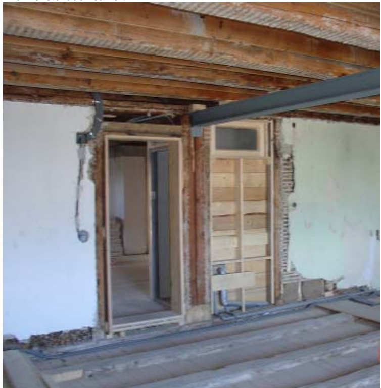
Bild: bestehende Tür versetzt
