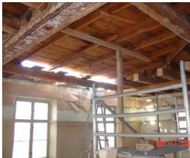
Bild: Decke Rosensaal, nach außen kragende Balken
