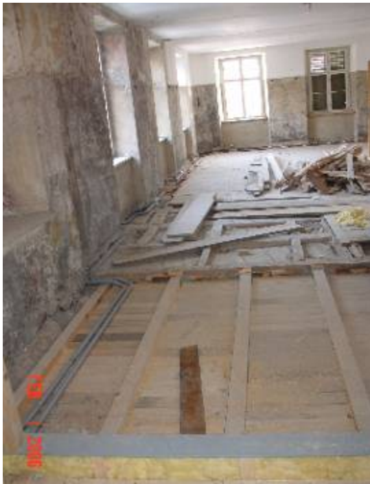
Bild: Heizungsverteilungsleitung
