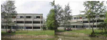
Altbestand vor Sanierung
