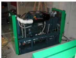
Bild 3: Rapsöl-betriebener Notstrom-generator mit Wärmeauskopplung
