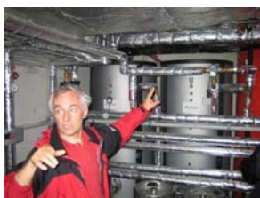
Bild 5: Pufferspeicher
