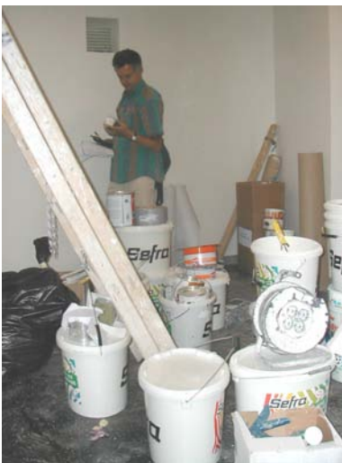
Baustellenkontrolle im Zuge des Chemikalienmanagements
