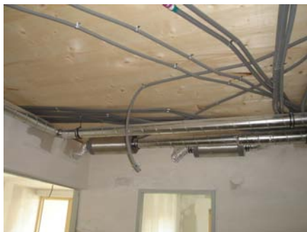
links: Detail Penthouse Fassade - Terrasse: Dichtung, rechts: Fenster; unten: Decke mit Lüftungsinstallationen
