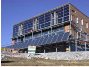
Bild 1: Fassaden Sonnenkollektoren
