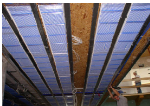
Bild 5: installierte Kühldecke
