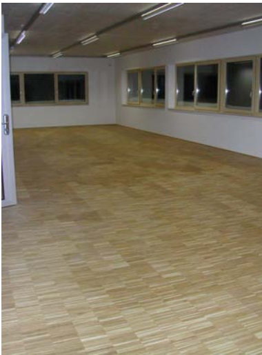
Großflächiger Einsatz nachwachsender Rohstoffe, hier Parkett, mit emissionsarmen Klebstoffen und Lacken verlegt
