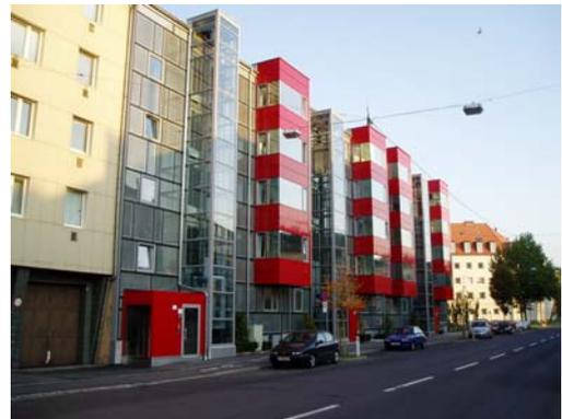
Als Außenhaut kamen fabrikmäßig vorgefertigte Fassadenelemente zum Einsatz. Die gap-solar Fassade ist ein hocheffizientes Wärmedämmsystem. Kernstück des Fassaden-Systems ist eine spezielle Wabe. Die Sonnenstrahlung wird in die Fassade aufgenommen und hebt den Temperaturunterschied zwischen Innenraum und Außenklima durch Schaffung einer warmen Zone an der Außenseite der Wand auf
